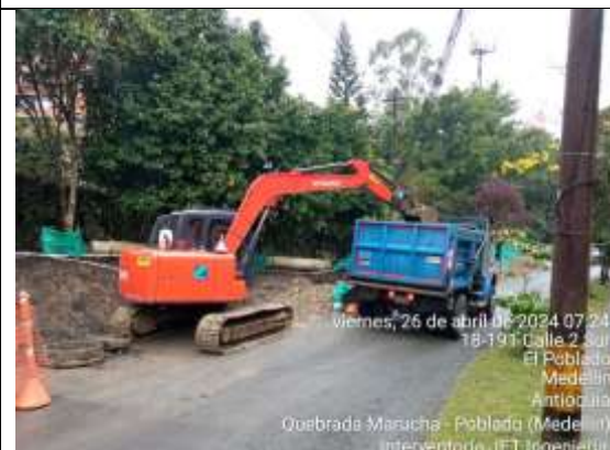
Foto 7 Continuidad de las actividades de excavación mecánica y retiro de material común.
