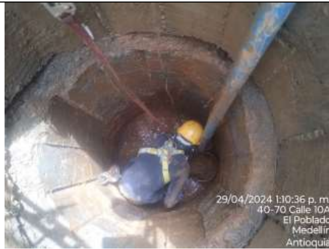
Foto 13. Excavación en caisson #1.
