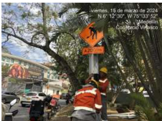
Foto 44. Instalación de señalización pmt Q Presidenta
