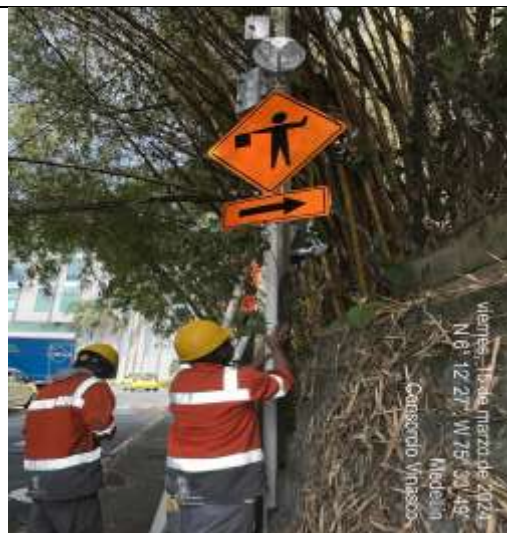
Foto 45. Instalación de señalización pmt Q Presidenta
