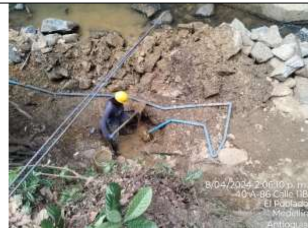
Foto 3. Excavación para caisson #2.
