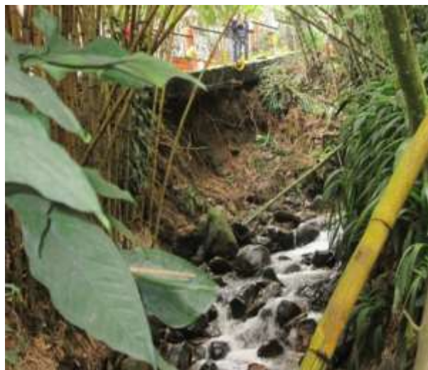
Estado inicial de la quebrada
