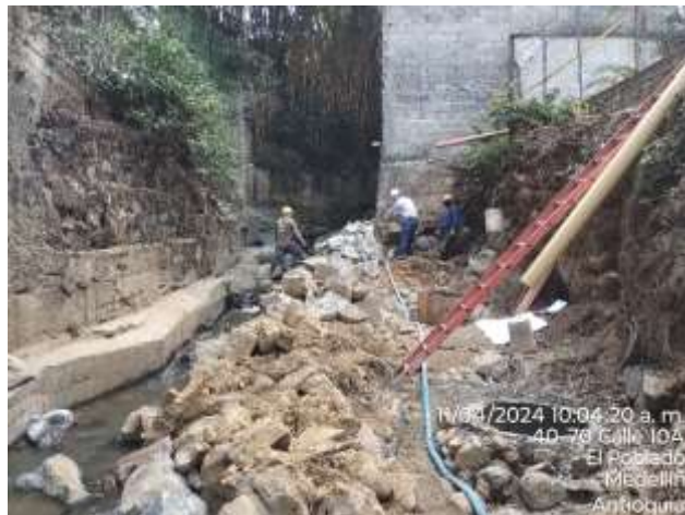
Foto 1: Construcción de barrera protectora para evitar el ingreso de agua.
