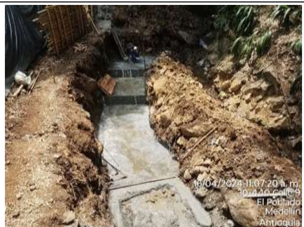
Foto 10. Vaciado de solado en terraza 3.
