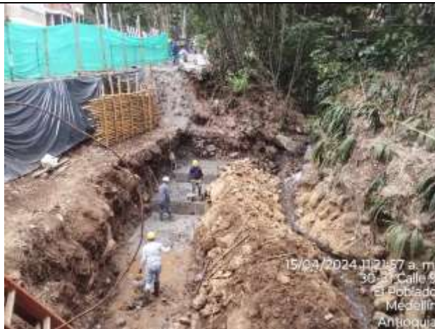
Foto 9: vaciado de concreto solado en terrazas 1 y 2.
