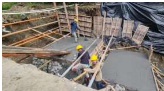
Foto 6 Fundida de mejoramiento de sub rasante en concreto ciclópeo
