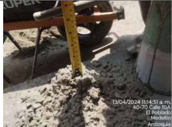
Foto 6: resultado de muestra de asentamiento al concreto para anillos de protección.
