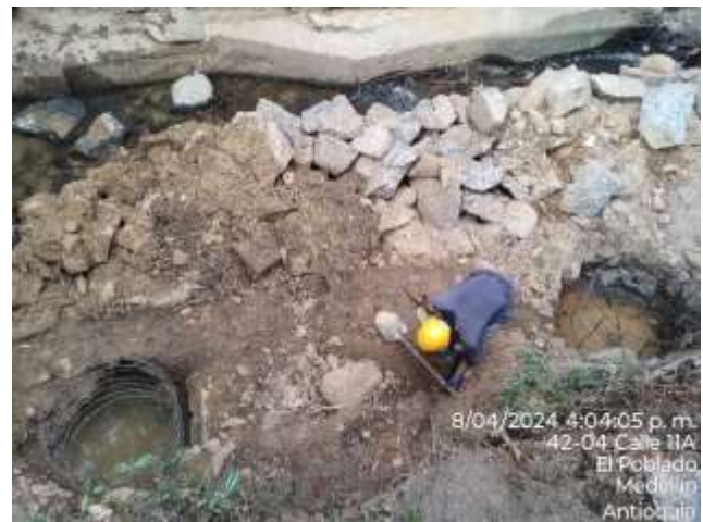
Foto 8: armado y colocación de se acero de refuerzo par anillos en caisson #2 y #3.
