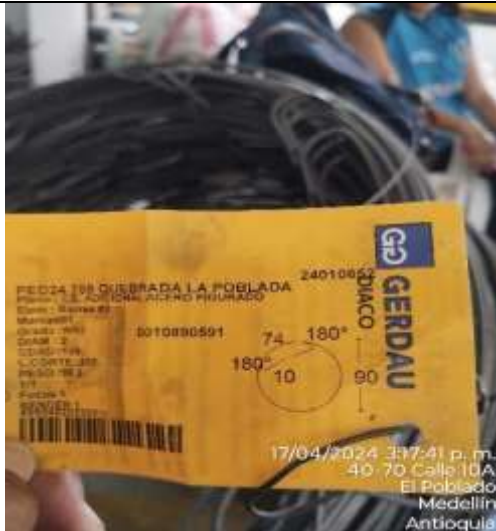
Foto 9: verificación de acero de refuerzo para anillos.
