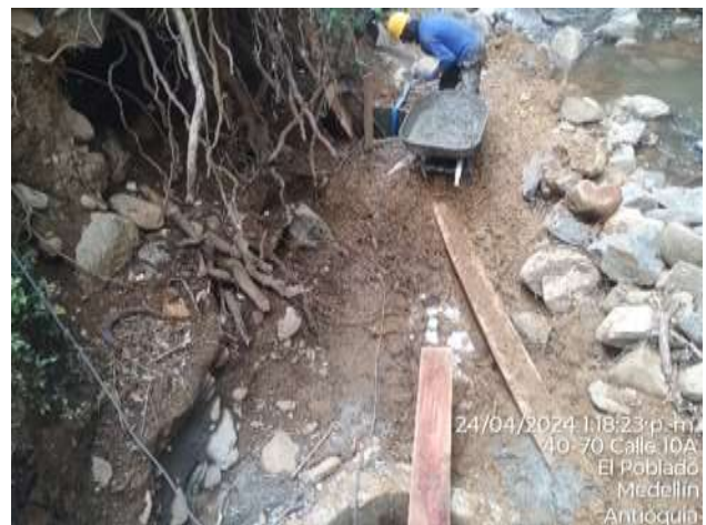
Foto 12: vaciado de concreto en anillo de protección.
