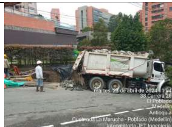
Foto 5 Llegada de piedra para concreto ciclópeo
