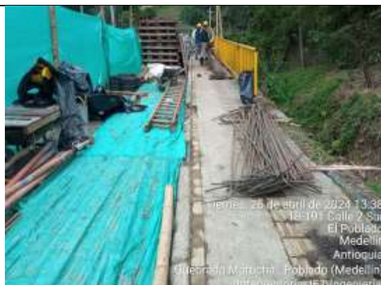
Foto 8 Corte y figurado de acero de 5/8 de pulgada para refuerzo principal de muros y losa de fondo del canal.
