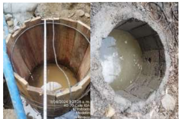
Foto 4: construcción de anillos de protección en caisson 1, 2, 3, y 4.
