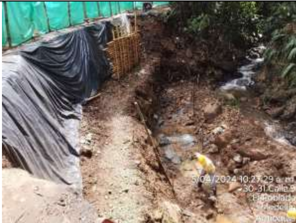
Foto 3. Protección de talud con plástico.
