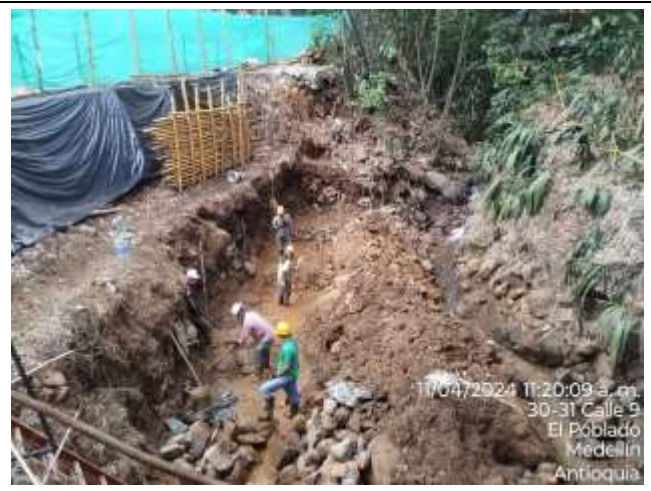
Foto 8: verificación de niveles para vaciado de solado.
