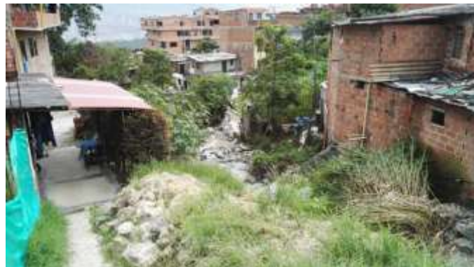
Estado inicial de la quebrada.
