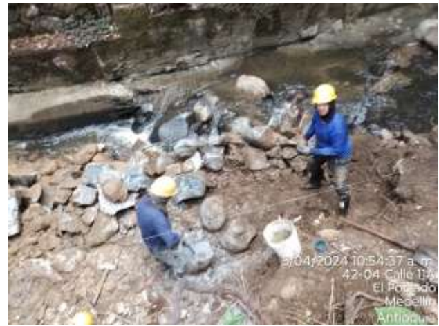
Foto 2: Demolición de roca en excavación para el caisson 2.
