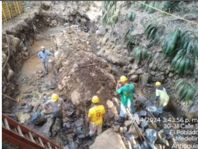
Foto 7. Repaleo de material proveniente de la excavación.
