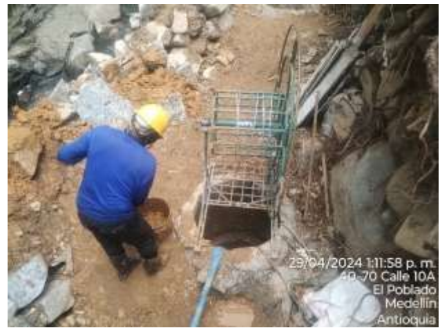
Foto 14: excavación par caisson #2.
