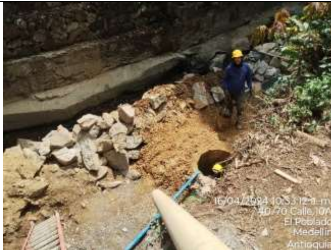
Foto 7. Excavación para caisson #2.
