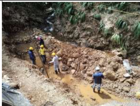
Foto 4: excavación en roca a cielo abierto.
