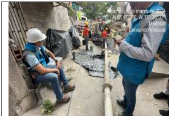
Foto 32. Protección del suelo . Quebrada Malpaso.
