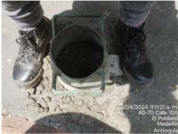
Foto 5: elaboración de muestra de asentamientos al concreto de 3000Psi para Anillos de protección.
