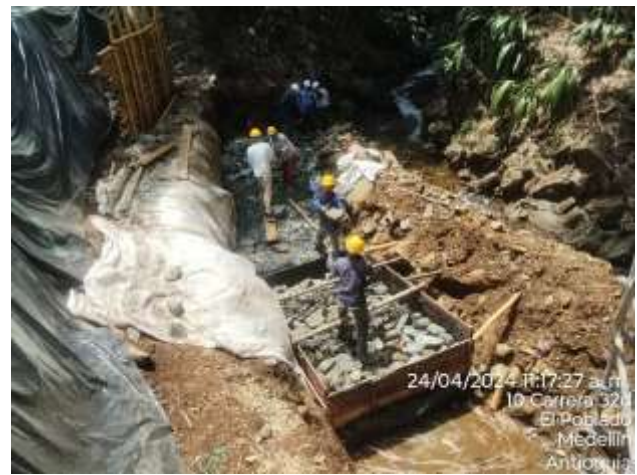
Foto 12: Construcción de enrocado en geoestera.
