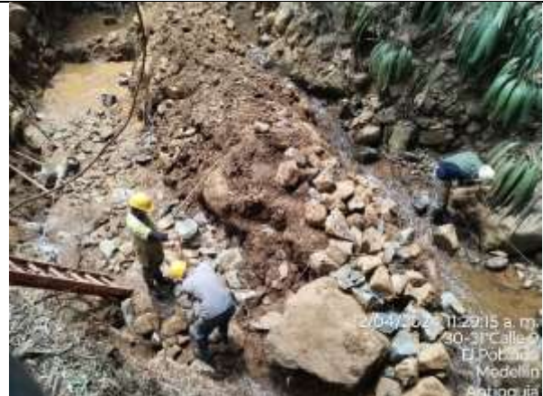
Foto 6: Demolición de roca.
