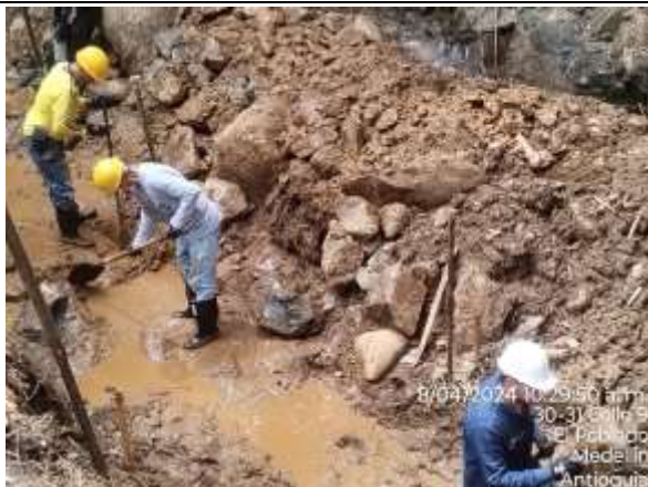
Foto 5: excavación en roca a cielo abierto.
