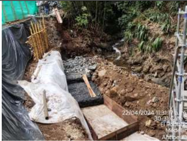
Foto 11. Construcción de enrocado con Geoestera
