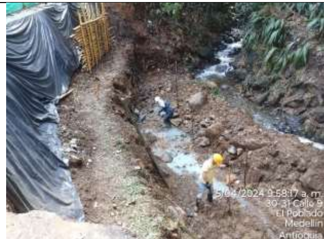
Foto 2: excavación para terrazo de niveles.
