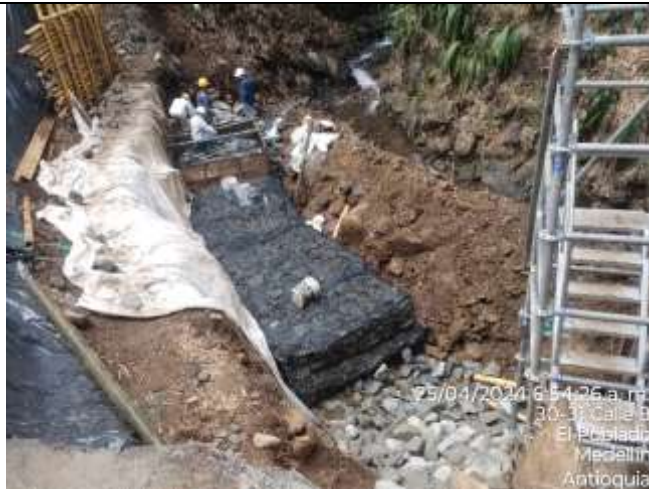
Foto 13. Excavación en caisson #1.
