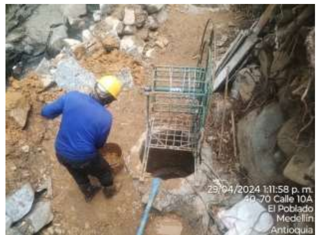
Foto 14: excavación par caisson #2.
