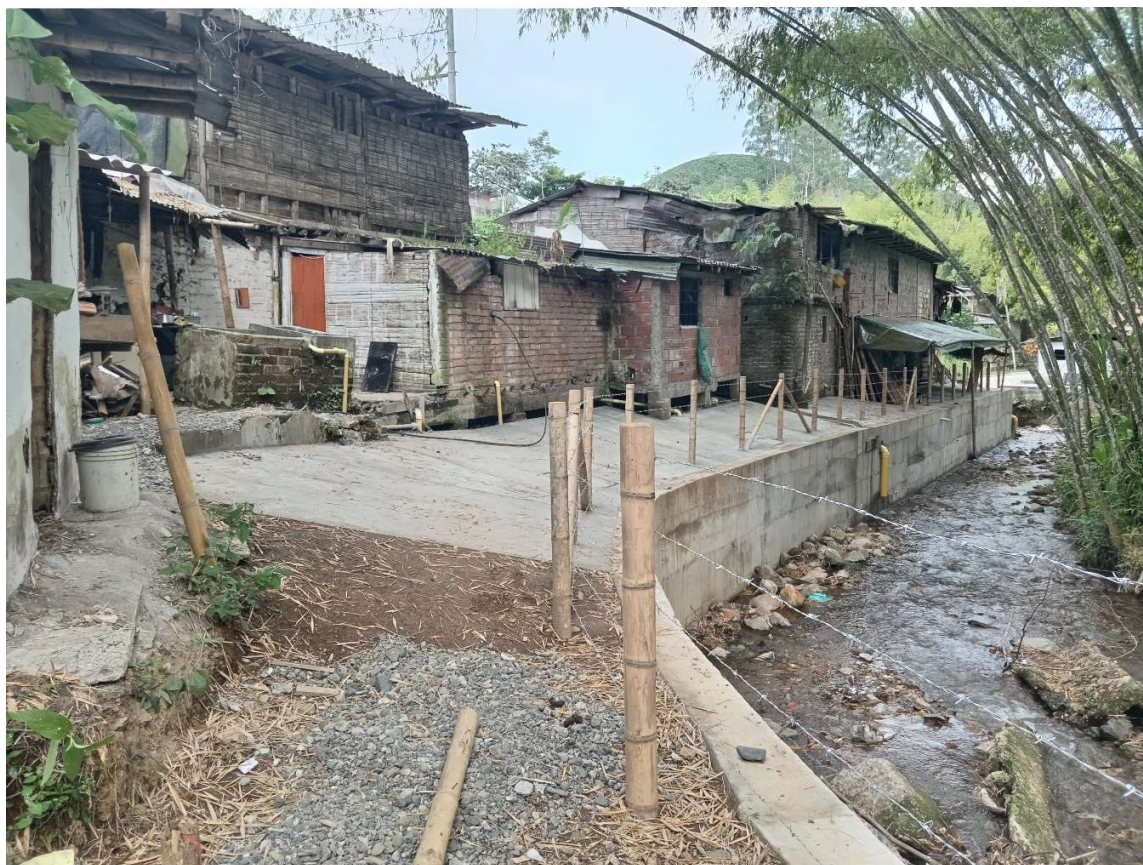
Ilustración 3. Obras ejecutadas en La Estrella
