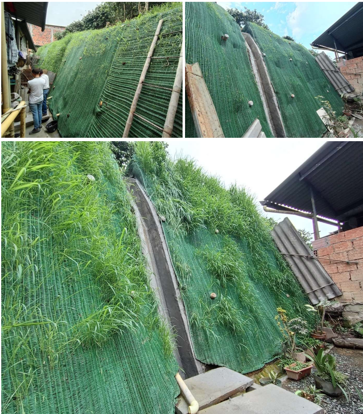
Ilustración 9. Obras ejecutadas en San Martín
