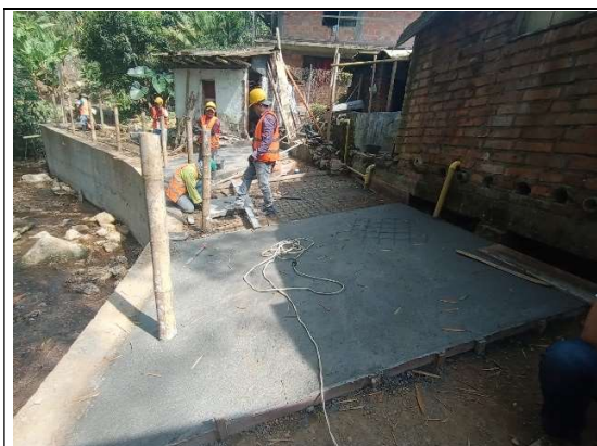
Intervención en el punto de La Estrella
