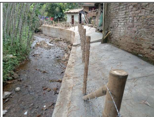
Intervención en el punto de La Estrella
