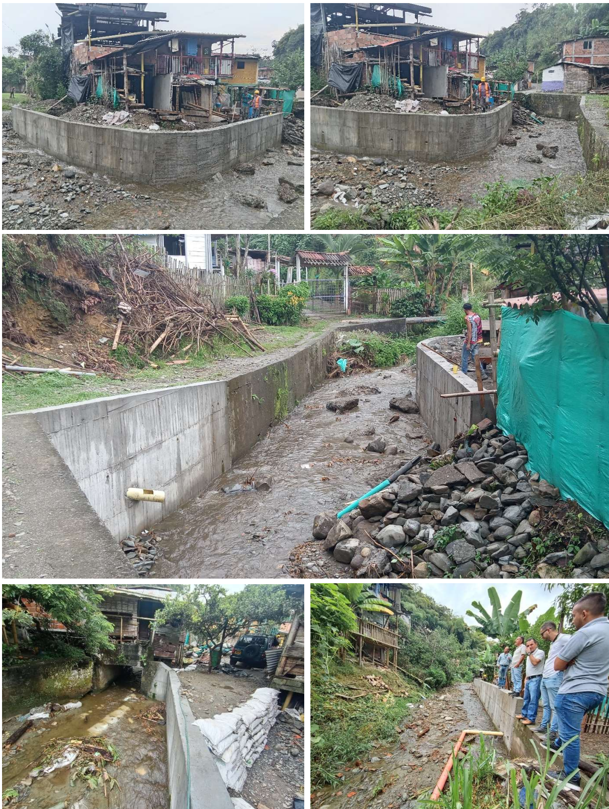
Ilustración 16. Obras ejecutadas en Guayabal
