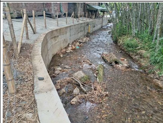
Intervención en el punto de La Estrella
