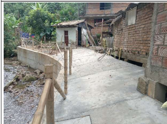
Intervención en el punto de La Estrella
