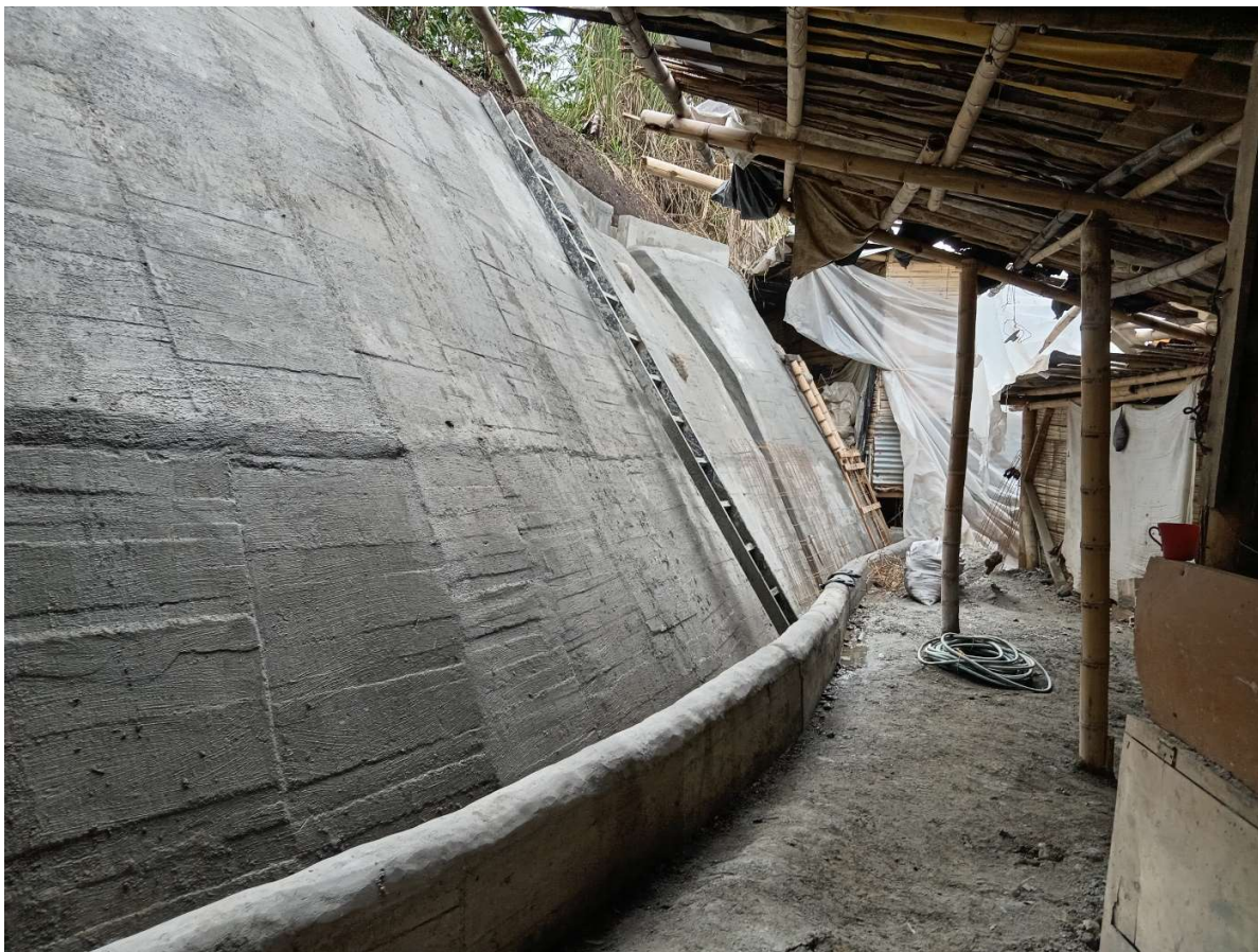
Ilustración 12. Obras ejecutadas en La Frontera vista general
