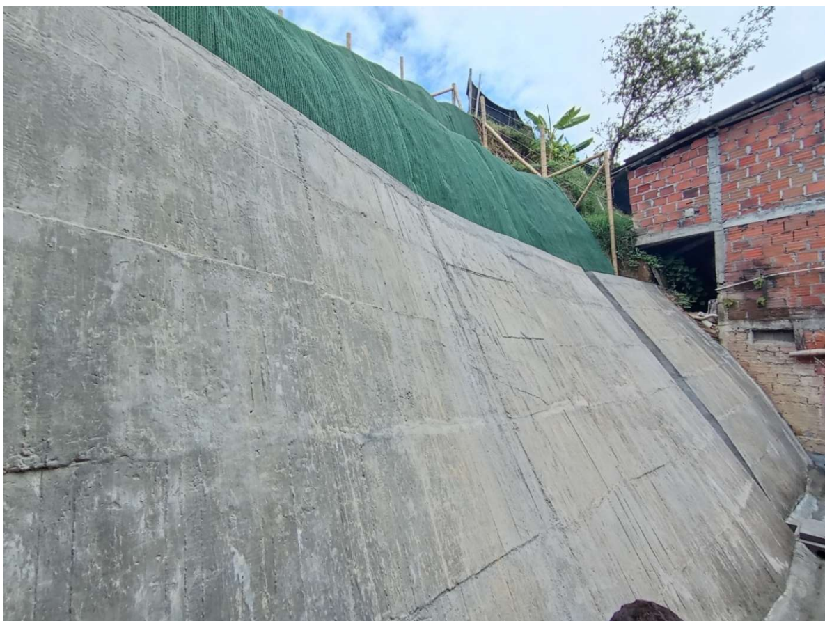
Ilustración 5. Obras ejecutadas en el Túnel
