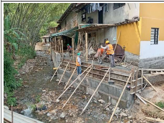
Intervención en el punto de La Estrella
