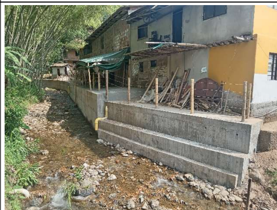
Intervención en el punto de La Estrella
