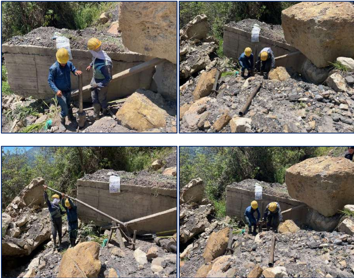
Figura 7. Actividades de exploración mediante la utilización del barreno helicoidal, ensayos de campo de pruebas de penetración estándar SPT.
