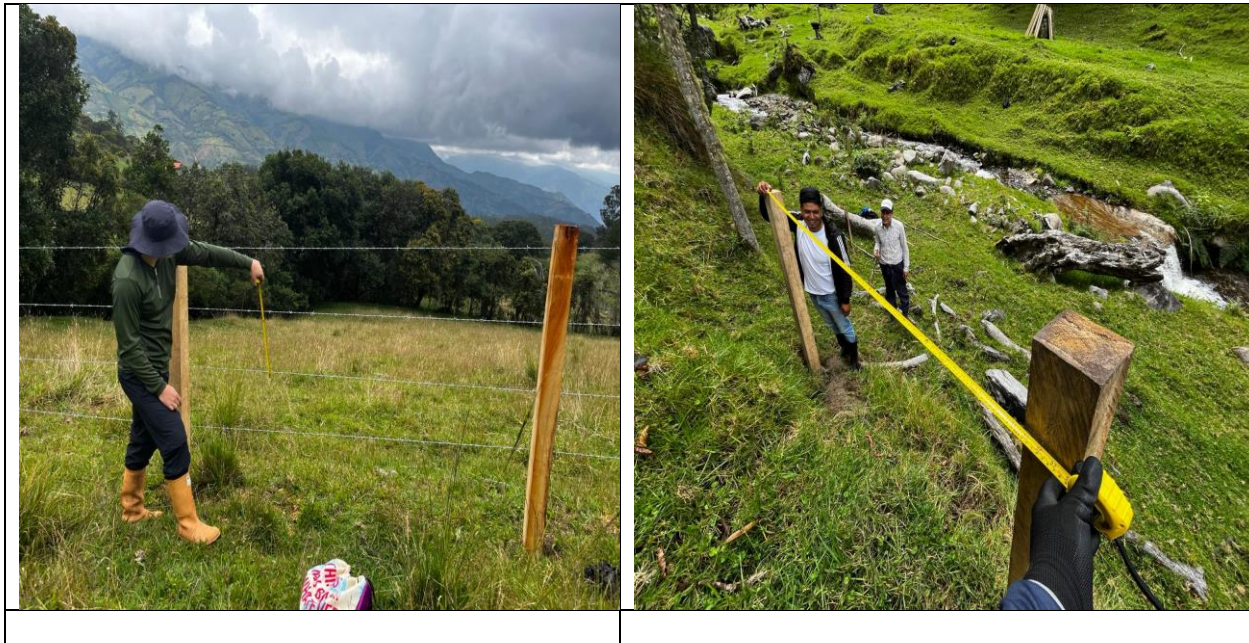
Figura 6. Verificación de aislamiento
