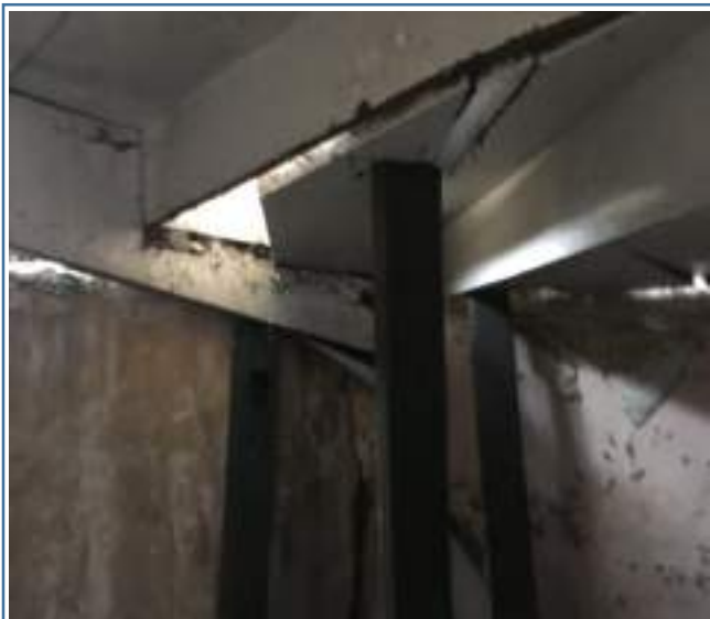
Foto 41. Peldaños Escalera entrada altillo - inicial
