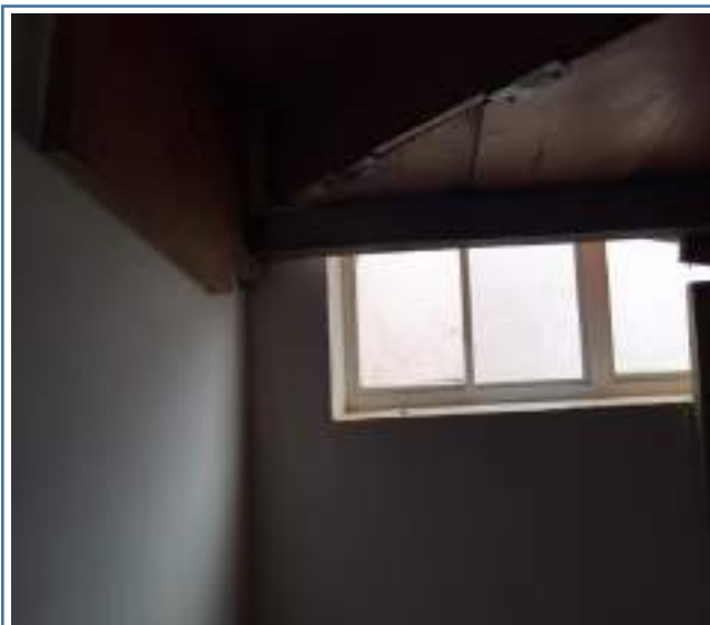
Foto 38. Debajo Escalera entrada altillo - final
