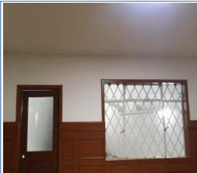
Foto 184. Muro y techo Estudio - final
