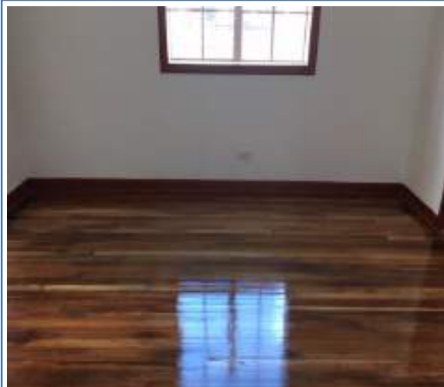
Foto 106. piso alcoba 3 - final
