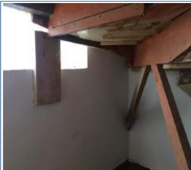
Foto 42. Peldaños Escalera entrada altillo - final
