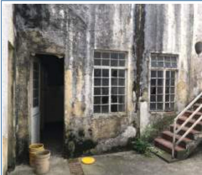
Foto 173. Patio interno a zona de lavado- inicial
