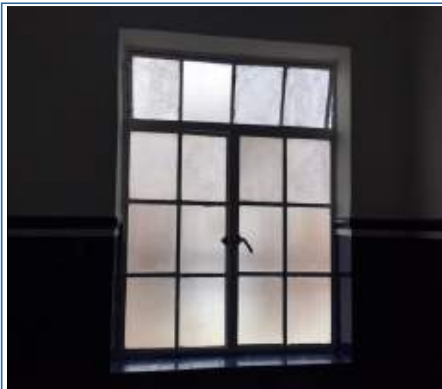
Foto 164. Ventana Baño principal - final
