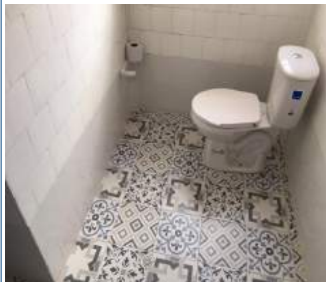
Foto 126. Muro y piso baño auxiliar - final
