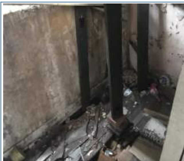
Foto 39. Piso Debajo Escalera entrada altillo - inicial
