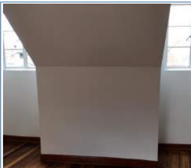
Foto 8. Muro lateral altillo - final
