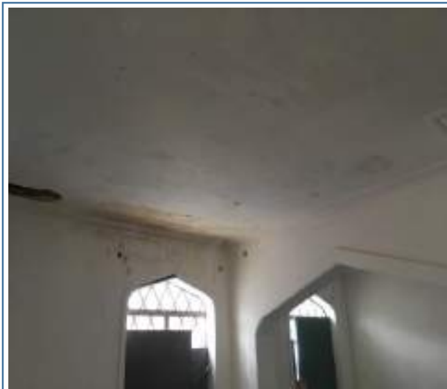
Foto 215. Cielo raso sala comedor - inicial
