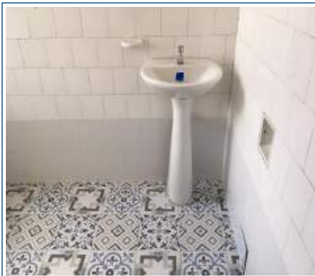
Foto 122. Piso baño auxiliar - final
