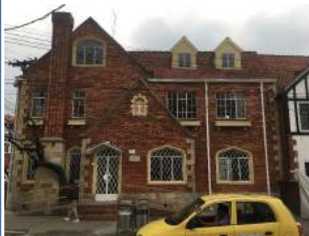
Foto 234. Fachada principal calle 32- final
