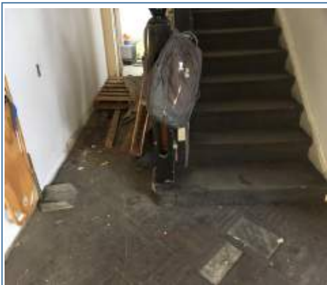
Foto 197. Escaleras a 2º piso - inicial
