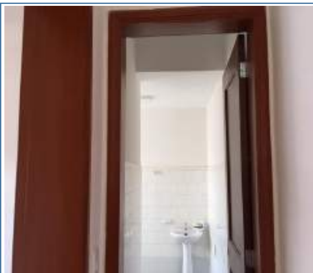
Foto 120. Entrada puerta baño auxiliar - final
