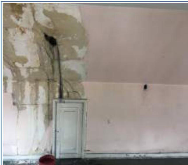
Foto 25. Muro costado occidental altillo – inicial
