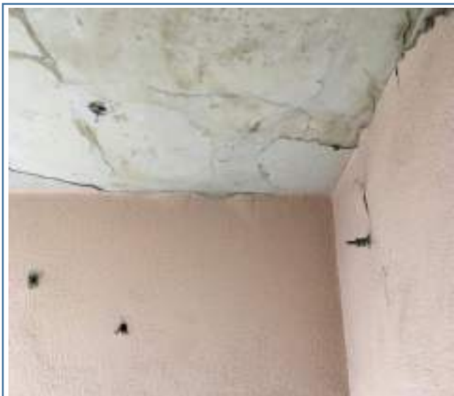
Foto 123. Techo y lampara baño auxiliar - inicial
