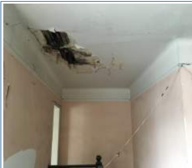
Foto 87. Muros y cielo raso hall 2º piso - inicial
