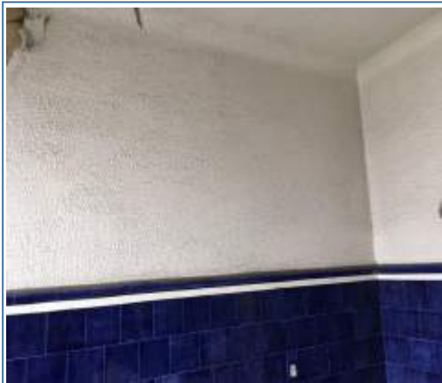
Foto 149. Muros Baño principal - inicial
