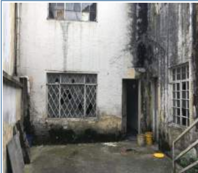
Foto 165. Patio interno - inicial
