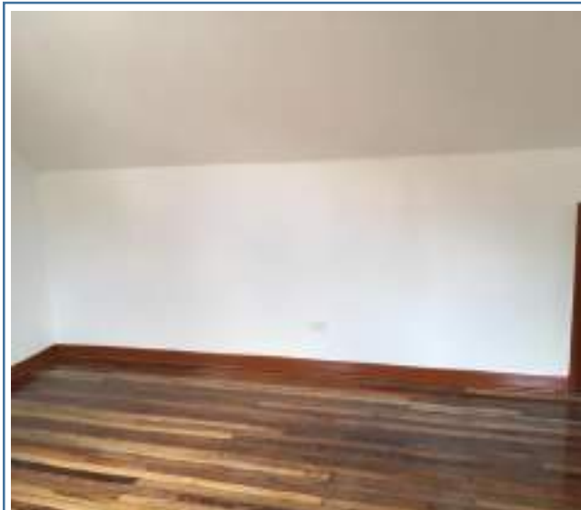
Foto 24. Esquina muro costado sur altillo - final
