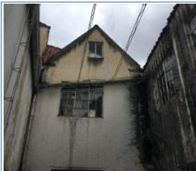
Foto 167. Patio interno a altillo - inicial
