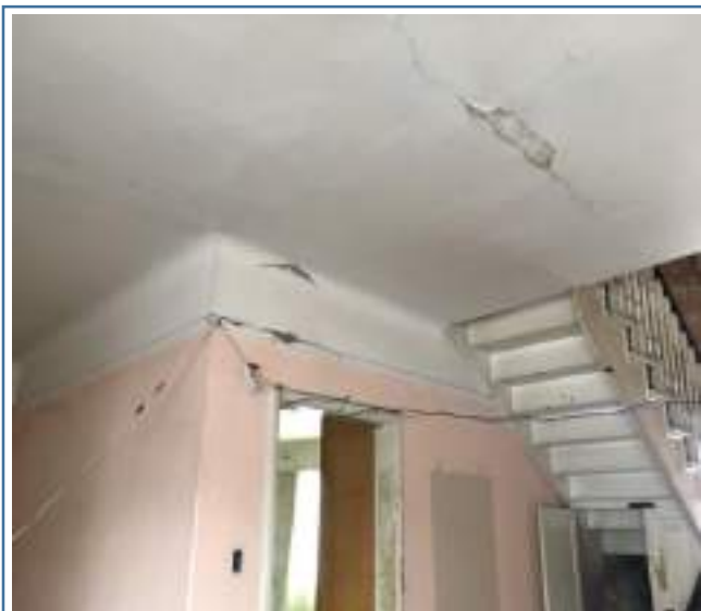
Foto 91. Cielo raso hall 2º piso - inicial
