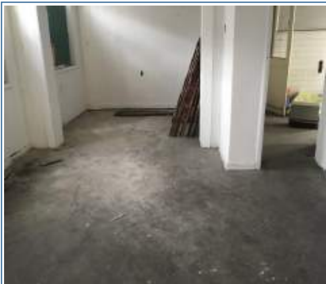
Foto 209. Piso parquet sala comedor - inicial
