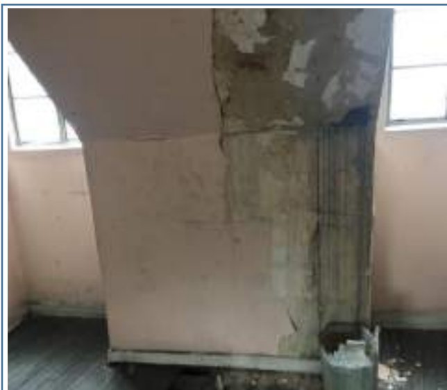
Foto 7. Muro lateral altillo- inicial
