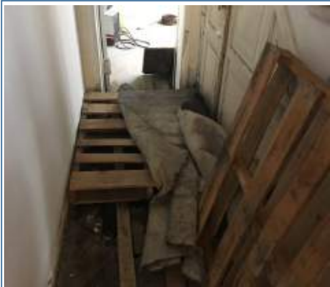
Foto 201. Pasillo a zona de lavado - inicial
