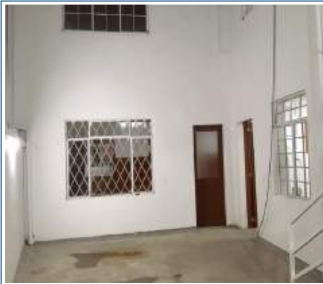
Foto 166. Patio interno - final
