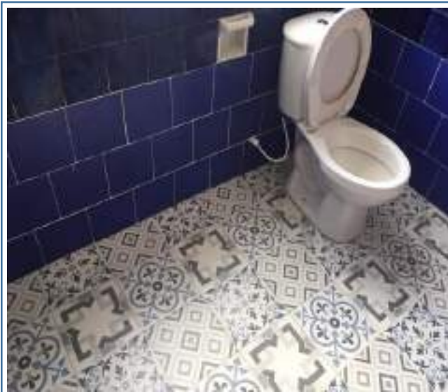
Foto 146. Sanitario Baño principal - final
