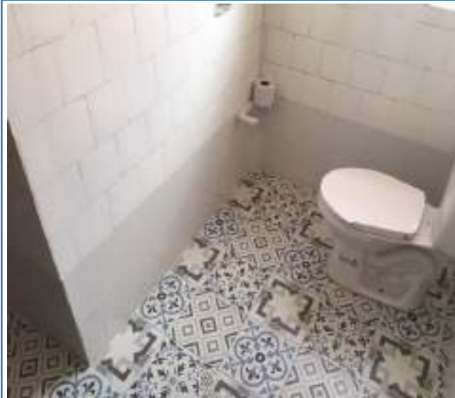
Foto 132. Enchape muro y piso baño auxiliar - final
