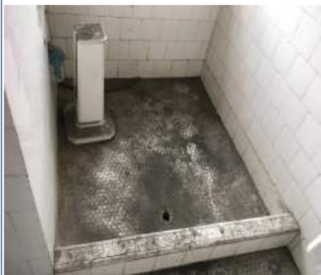
Foto 125. Muro y piso baño auxiliar - inicial
