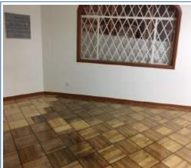
Foto 222. Muro y piso Sala - final
