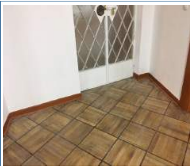
Foto 206. Entrada principal parte inferior - final
