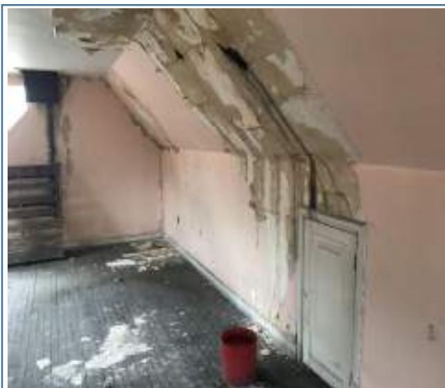
Foto 15. Muro y piso altillo - inicial
