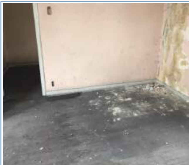
Foto 47. Muro esquina alcoba 2 - inicial
