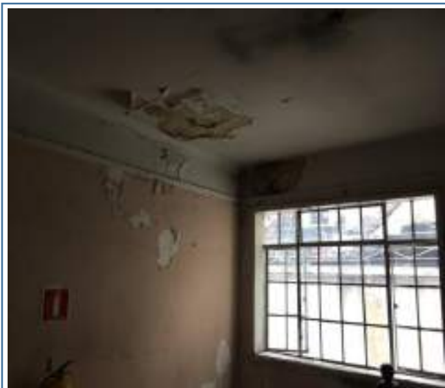
Foto 79. Techo hall 2º planta costado occid - inicial
