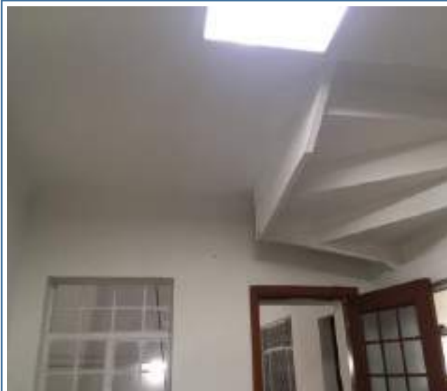
Foto 230. Zona de lavado cielo raso - final
