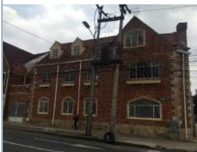
Foto 236. Fachada principal carrera 16 - Final
