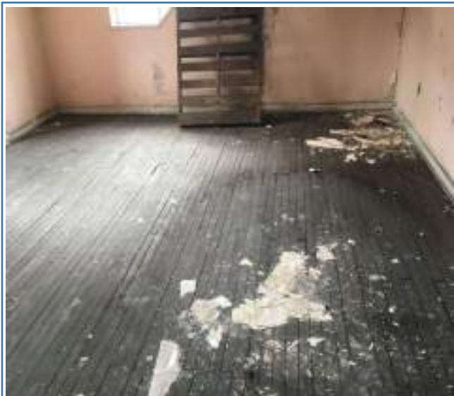
Foto 21. Piso pasillo sur altillo - inicial
