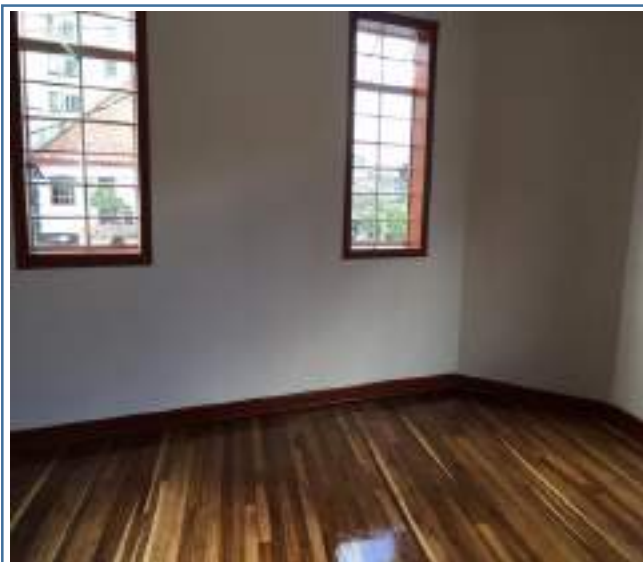
Foto 56. Muros y piso alcoba 1 - final
