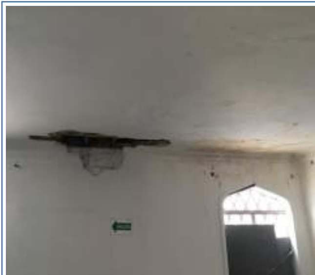
Foto 219. Cielo raso Sala - inicial
