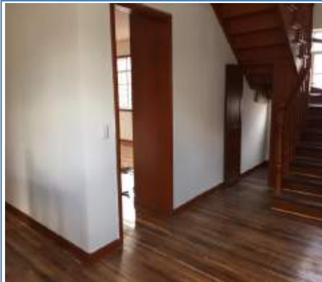
Foto 90. piso hall 2º piso - inicial
