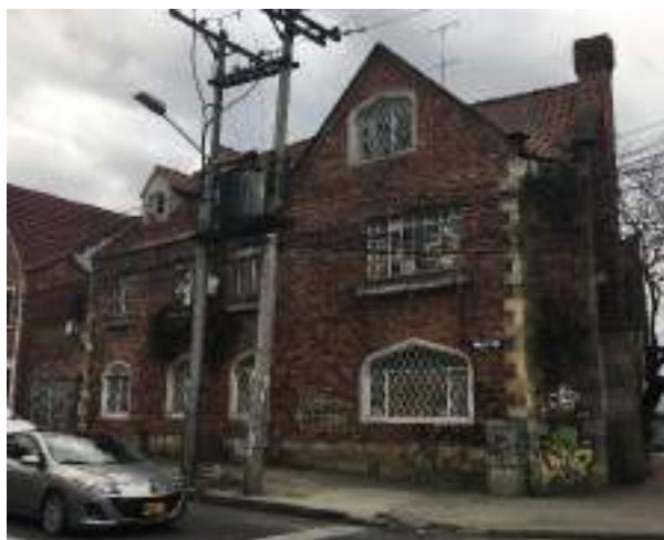
Foto 235. Fachada principal carrera 16 - Inicial
