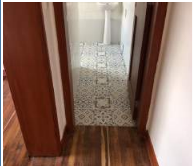
Foto 118. Entrada baño auxiliar - final
