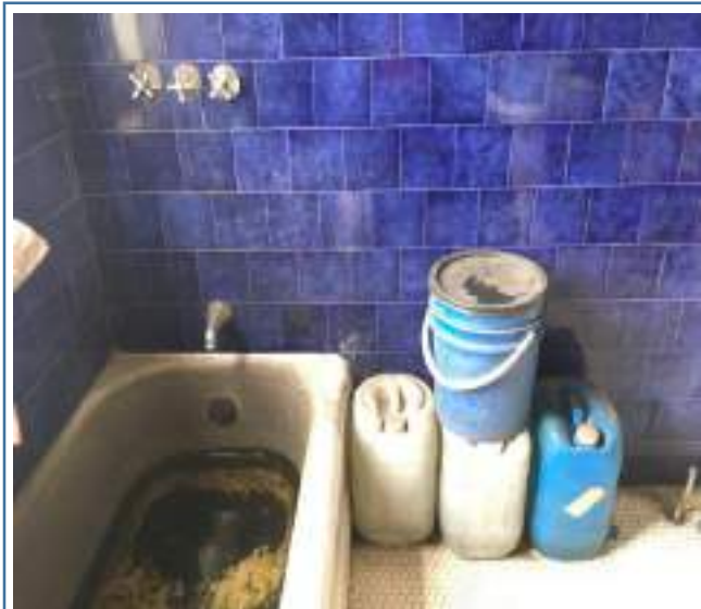
Foto 151. Enchape Baño principal - inicial
