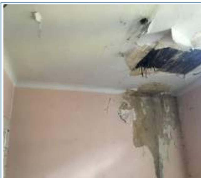
Foto 111. Esquina y muro alcoba 3 - inicial
