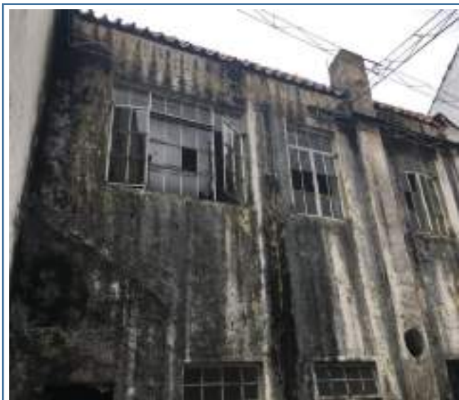
Foto 175. Patio interno a alcoba 4 - inicial
