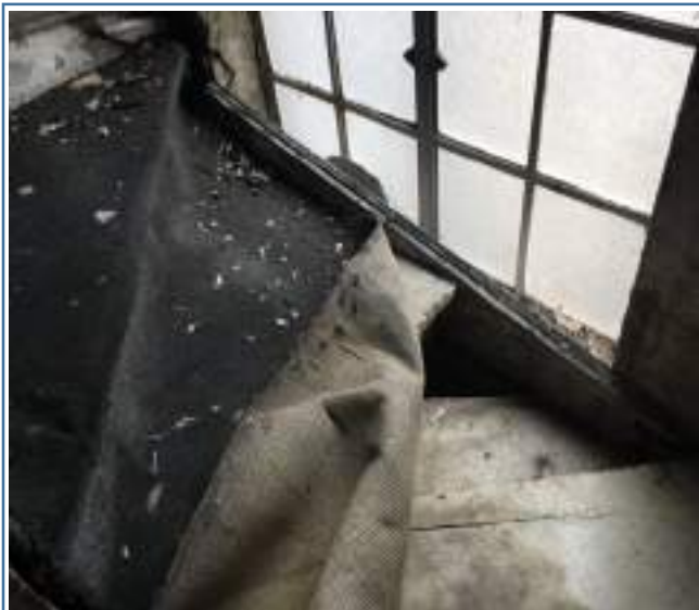
Foto 33. Escalera zona central entrada altillo - inicial
