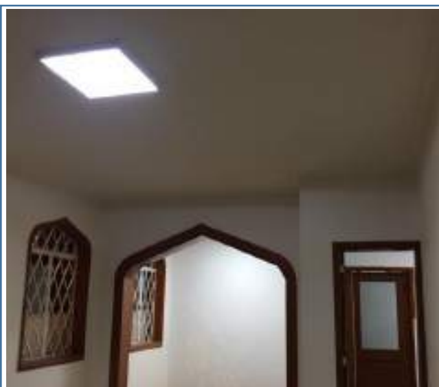
Foto 212. Cielo raso sala comedor - final
