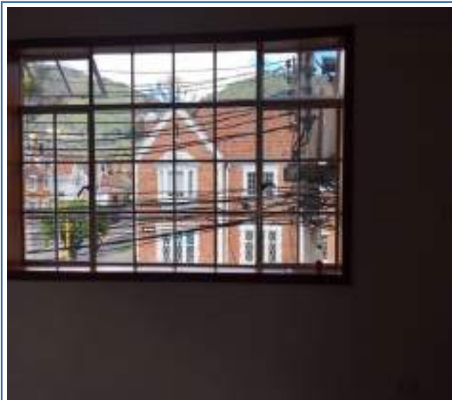
Foto 72. Ventana costado oriental alcoba 1 - final
