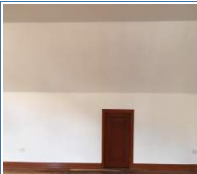
Foto 26. Muro costado occidental altillo - final
