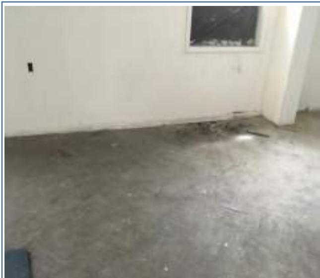
Foto 217. Piso parquet Sala - inicial
