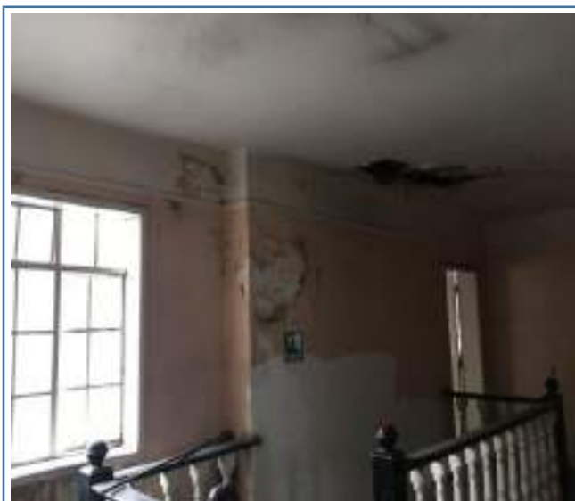
Foto 83. Techo sobre escalera 2º piso - inicial
