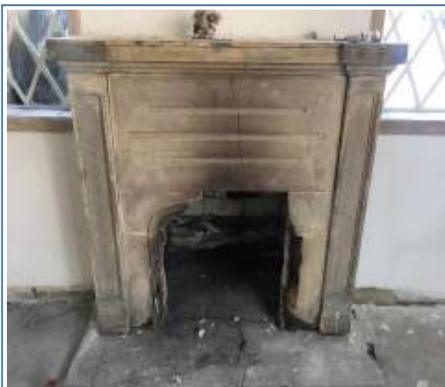
Foto 231. Estado inicial chimenea
