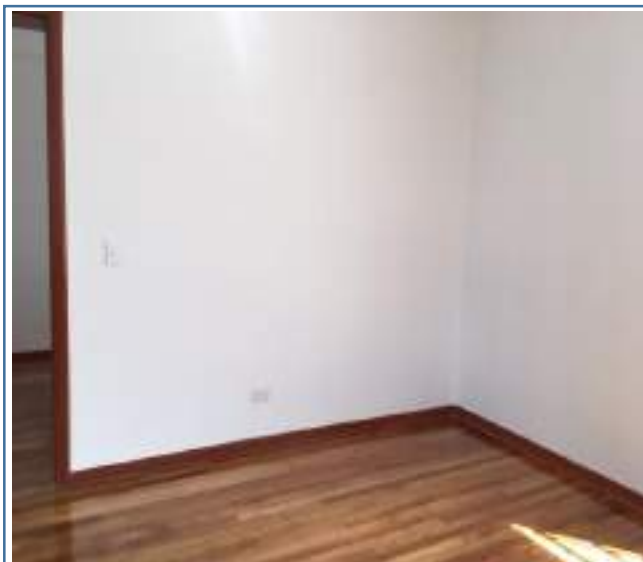
Foto 48. Muro esquina alcoba 2 - final
