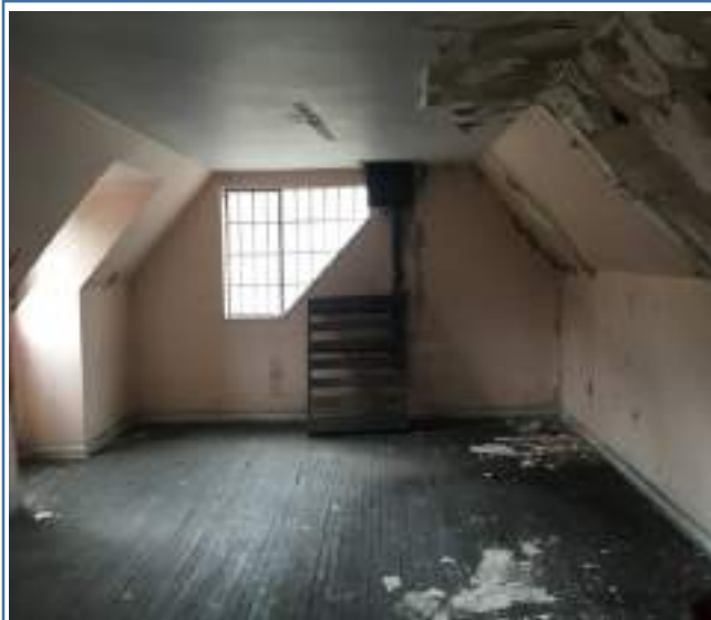
Foto 17. Piso pasillo y techo attillo - inicial
