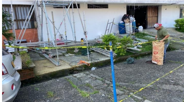
Señalización en obra
