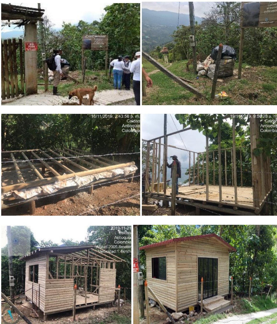
Figura 36. Construcción del puesto de control guardabosques, Vereda El Vallano
