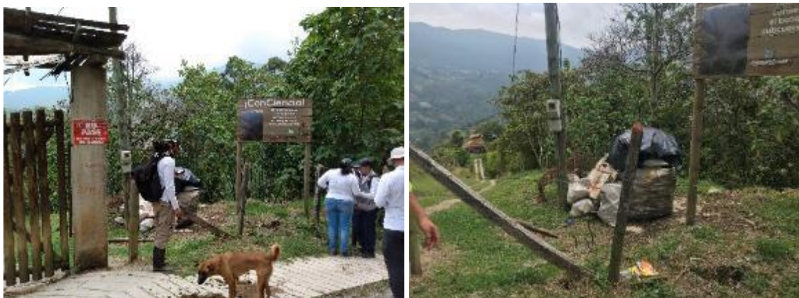
Imagen 95. Ubicación y construcción del puesto de control guardabosques sector Arenales
