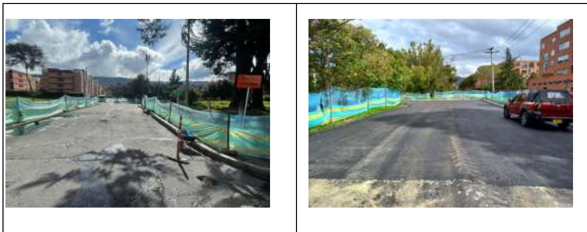
Ilustración 11. Cerramiento de obra
