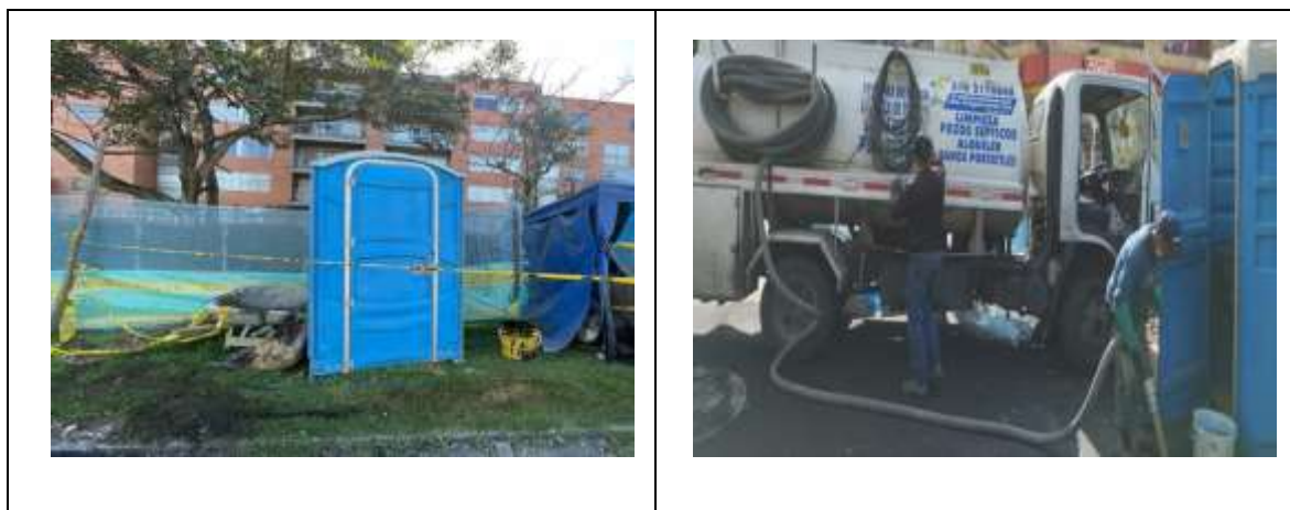
Ilustración 10. Instalación y limpieza de Baterías Sanitarias
