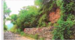
Figura 6. Identificación de coberturas vegetales área de influencia – Vegetación secundaria alta
