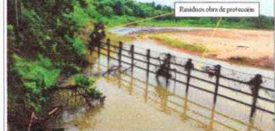
Figura 3. Restos de obra de protección - Restos obra de protección.
