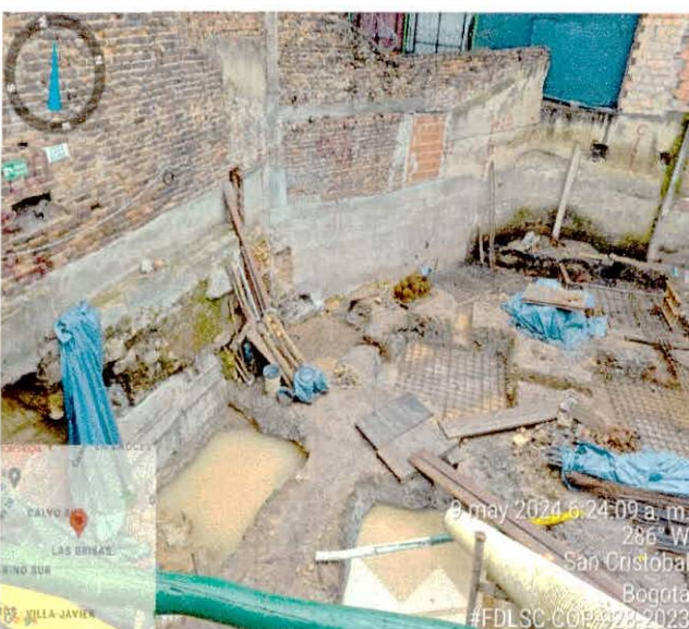
EXCAVACIÓN MANUAL VIGAS Y ZAPATAS, EJES DEL 1 AL 4 y EJES DEL A' AL E
