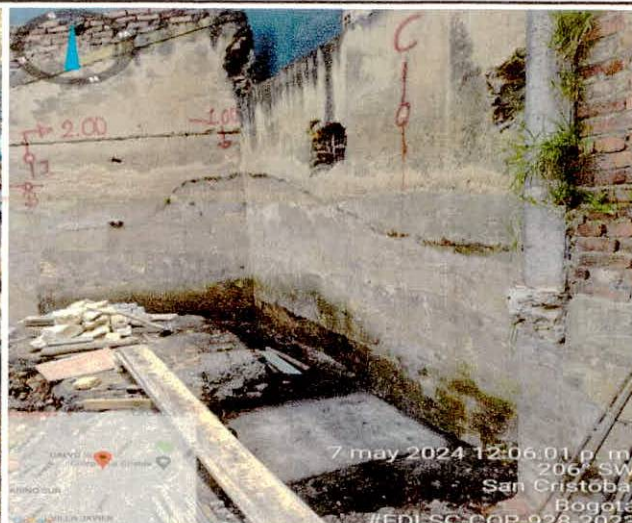
EXCAVACIÓN MANUAL VIGAS Y ZAPATAS, EJES DEL 1 AL 4 y EJES DEL A' AL E
