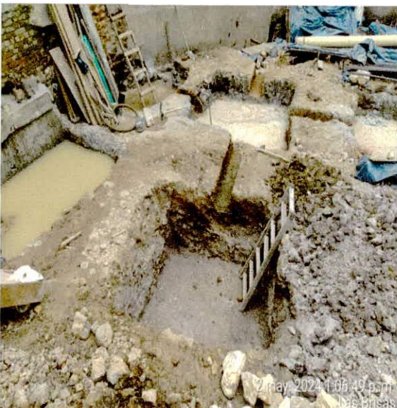
EXCAVACIÓN MANUAL VIGAS Y ZAPATAS, EJES DEL 1 AL 4 y EJES DEL A' AL E
