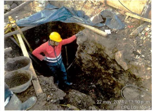
EXCAVACIÓN ZAPATA 1C
