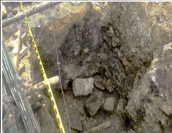
EXCAVACIÓN ZAPATA 1C
