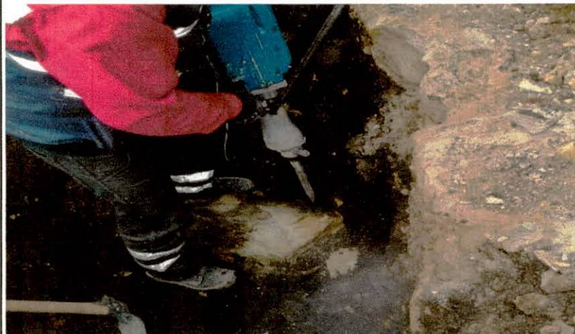
EXCAVACIÓN ZAPATA 1B
