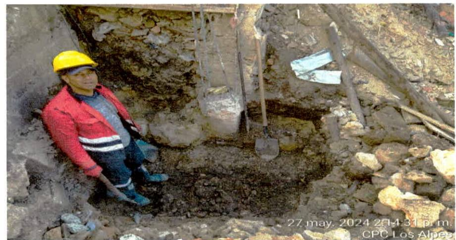
EXCAVACIÓN ZAPATA 1B
