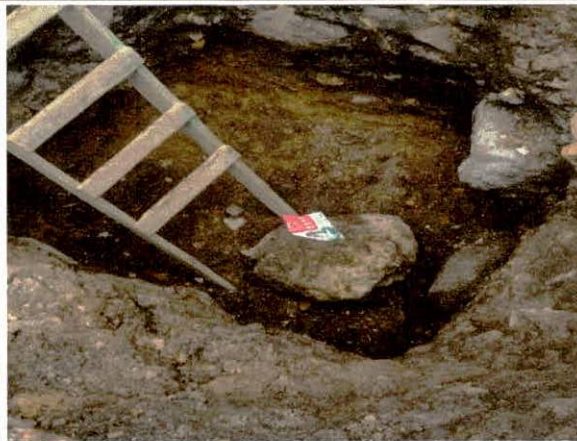
EXCAVACIÓN ZAPATA 1C
