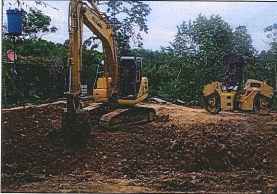
Foto No. 5. Suministro, instalación y compactación de material de relleno tipo recebo en piscina de evaporación.
