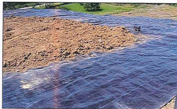
Foto No. 2. Suministro e Instalación de Geomembrana de 60 mils.
