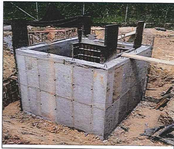
Foto No. 4. Suministro e instalación de Concreto 4000 psi para tanques y estructuras de ingeniería ambiental, impermeabilizado, plastificado y micro sílices
