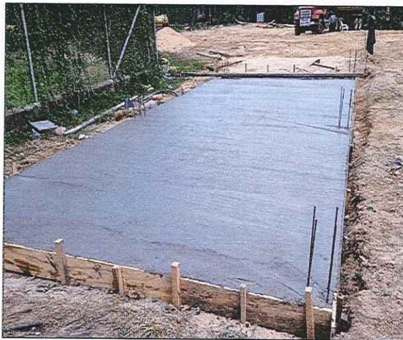
Foto No. 4. Suministro e instalación de Concreto 4000 psi para tanques y estructuras de ingeniería ambiental, impermeabilizado, plastificado y micro sílices
