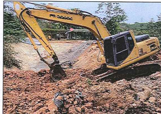
Foto No. 5. Suministro, instalación y compactación de material de relleno tipo recebo en piscina de evaporación.
