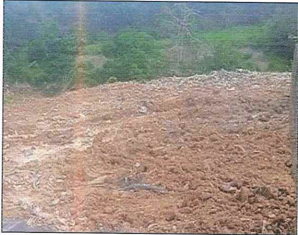
Foto No. 3. Suministro, extendido y conformación de relleno con materia tipo arcilla e=40\text{cm} sobre basura existente a cielo abierto.
