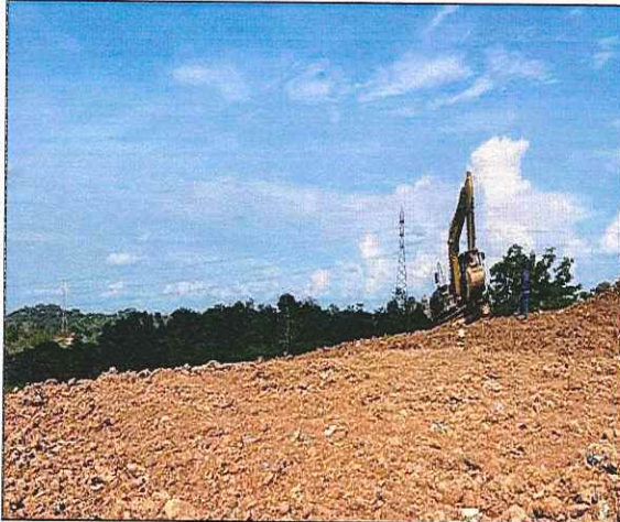
Foto No. 3. Suministro, extendido y conformación de relleno con materia tipo arcilla e=40\text{cm} sobre basura existente a cielo abierto.
