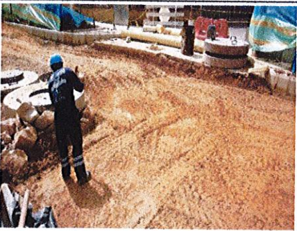
FOTO No. 4 CIV 16002846 - Reposición de capa de subbase por lluvias.
