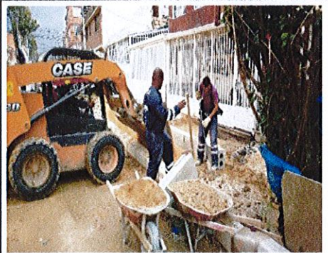
FOTO No. 6 CIV 16002769 - Instalación de elementos prefabricados tipo sardinel y bordillo.
