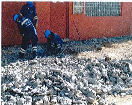
FOTO No. 1 CIV 16001745 - Demolición de placa existente en concreto.
