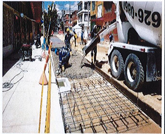
CIV16002769 - Fundida de placa de pavimento rígido MR-45, colocación de aceros de refuerzo y acero de transferencia.
