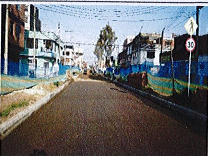
FOTO No. 11 CIV 16002905 - Cereo y compactación paa capa estabilizada con emulsión.
