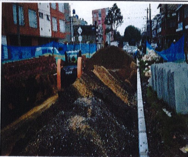
CIV 16002905 - Mezcla en seco fresado y base granular para estructura de pavimento.
