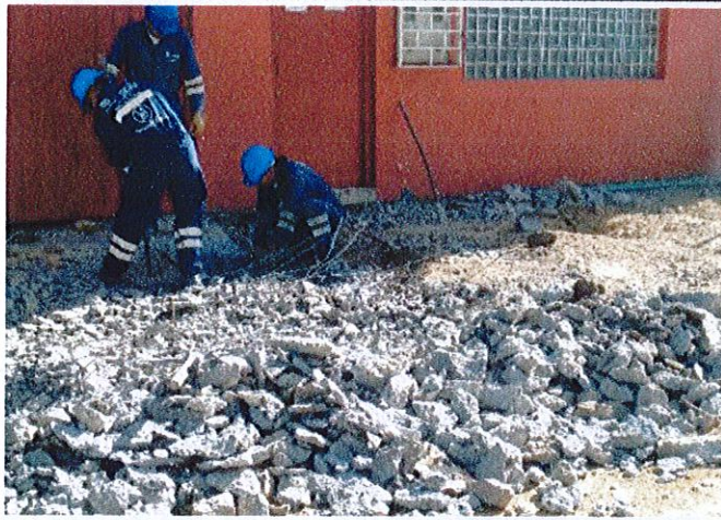
CIV16001745 - Demolición de placa existente en concreto.
