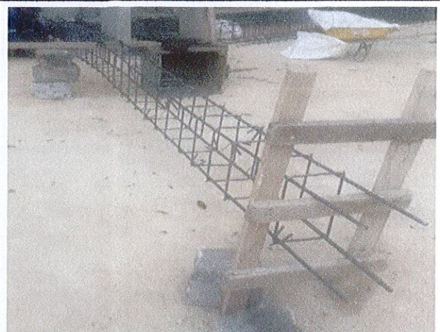
CIV16001745 - Figurado y amarre de acero de refuerzo para vigas de transición.
