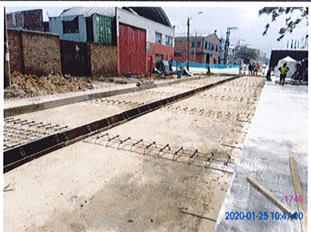
CIV16001745 - Instalación de canastillas con barras de transferencia e instalación de acero de
