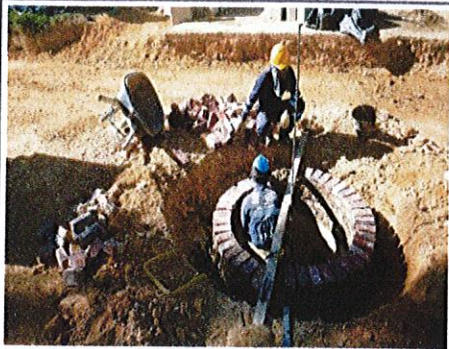
FOTO No. 7 CIV 16002879 - Renovación de pozos carrera 32B.
