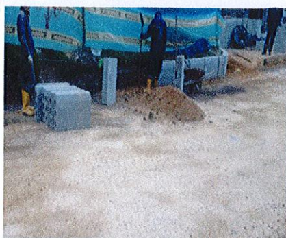
FOTO No. 11 CIV 16002879 - Instalación de elementos prefabricados tipo sardinel A10.
