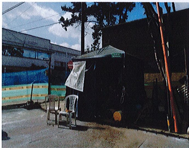
Inspección campamento frente Pensilvania.
