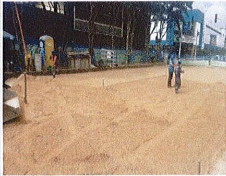
FOTO No. 1 CIV 16001745 - Extendido de material granular tipo subbase.
