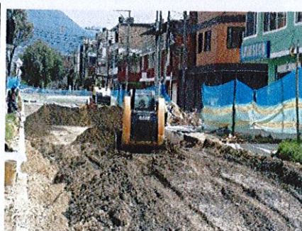
FOTO No. 8 CIV 16002879 - Mezclado de base granular - fresado y Emulsión para capa estabilizada.
