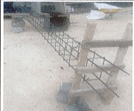
FOTO No. 3 CIV 16001745 - Figurado y amarre de acero de refuerzo para vigas de transición.
