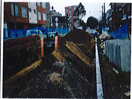
FOTO No. 9 CIV 16002905 - Mezcla en seco fresado y base granular para estructura de pavimento.
