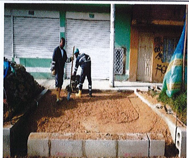
CIV 16002879 - Actividad de rellenos con base granular e instalación de elementos prefabricados.
