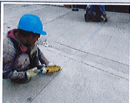
FOTO No. 3 CIV 16001745 - Dilatación, limpieza, instalación de cordón y sello de juntas.
