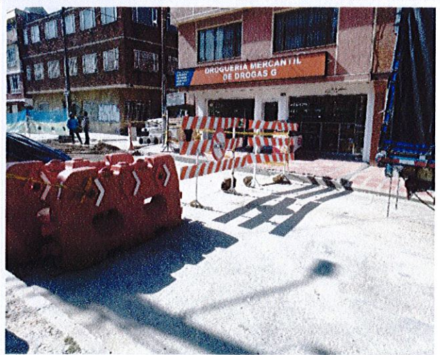
Verificación implementación de señales
