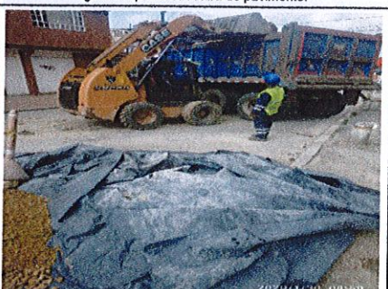
FOTO No. 12 Limpieza de Escombros de la calle 2.
