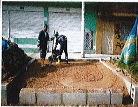
FOTO No. 10 CIV 16002879 - Actividad de rellenos con base granular e instalación de elementos prefabricados.
