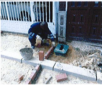
FOTO No. 8 CIV 16002769 - Instalación de cajillas en plástico medidores agua potable.
