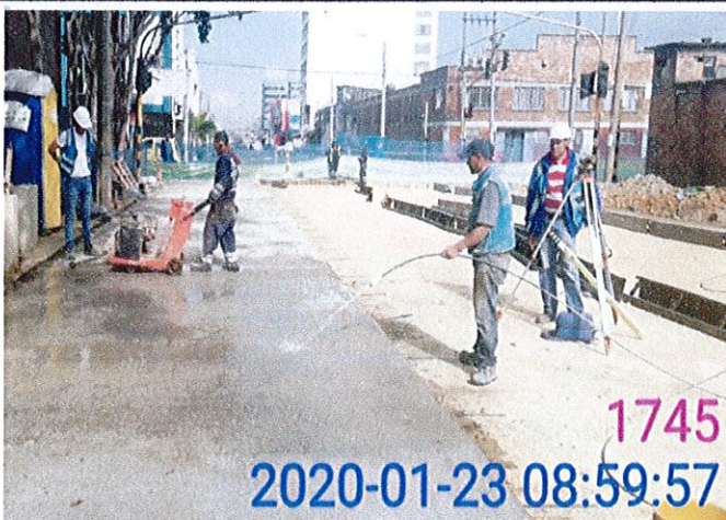
CIV16001745 - Curado y corte de dilataciones en placa MR45.
