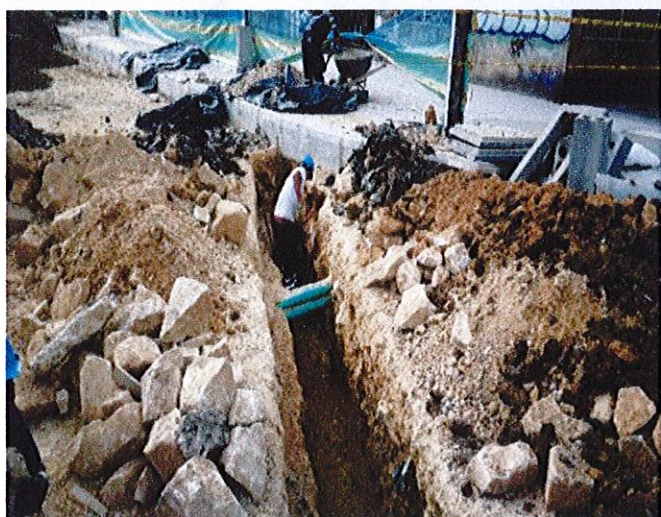
CIV 16002846 - Excavación manual para instalación de tubería.
