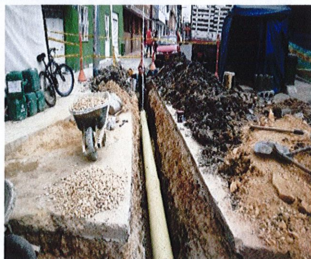
CIV 16002846 - Instalación de tubería novafort carrera 32C a sumidero costado norte.
