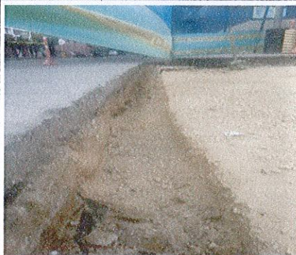
FOTO No. 2 CIV 16001745 - Excavación para fundida de viga de transición.
