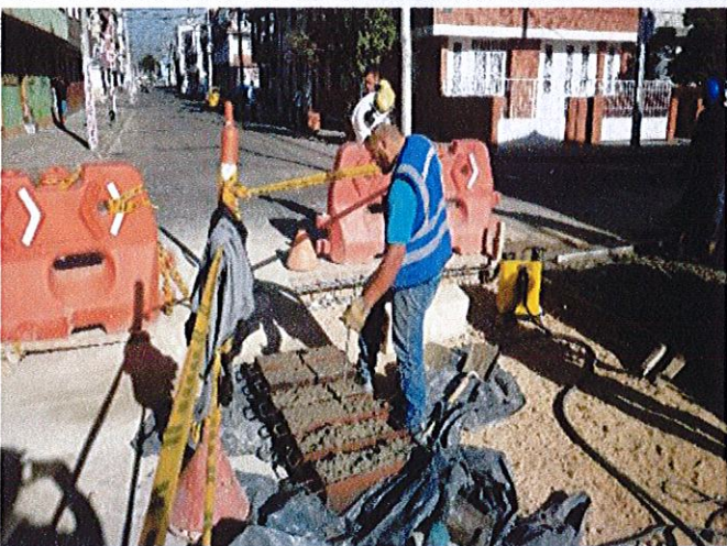
CIV 16002769 - Toma de muestras del concreto empleado (Viguetas).
