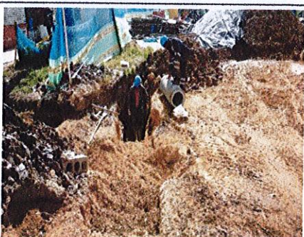
FOTO No. 5 CIV 16002846 - Instalación de tubería concreto reforzado para sumideros.
