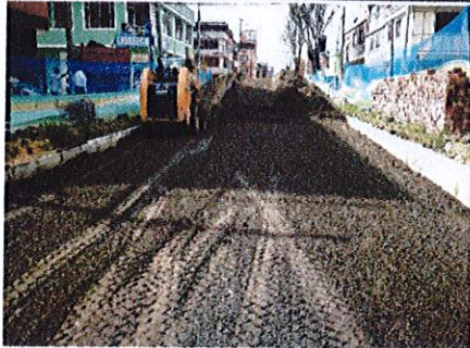
FOTO No. 10 CIV 16002905 - Extendida y cereo de mezcla estabilizada con emulsión.
