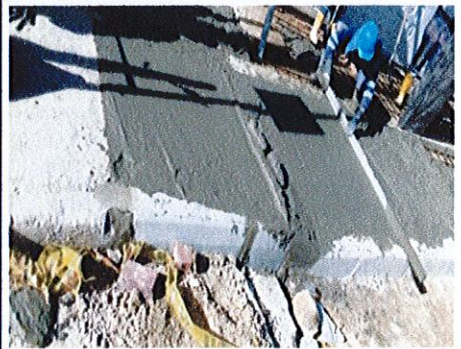
FOTO No. 9 CIV 16002769 - Fundida de andén en concreto de 3000 PSI costado sur.
