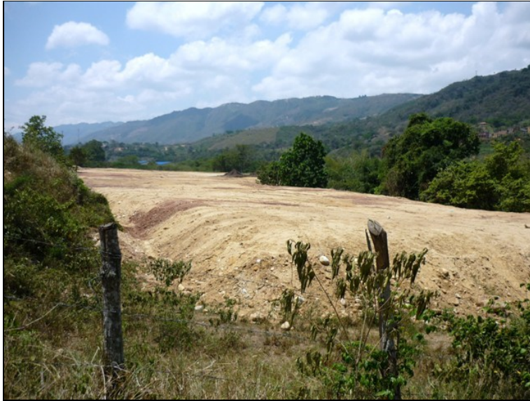
Foto 20 Llenos compactados, en la zona industrial, margen derecha del río de Oro
