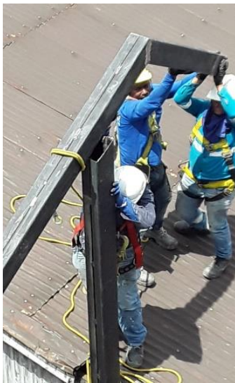
FOTO 3- Armado de estructura metálica para la sobrecubierta. certificado.
