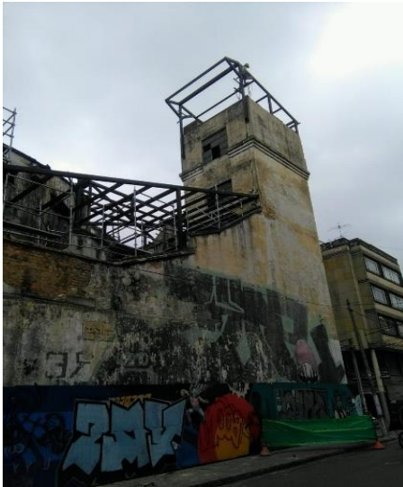
FOTO 1- Armado de estructura metálica para la sobrecubierta. certificado.
