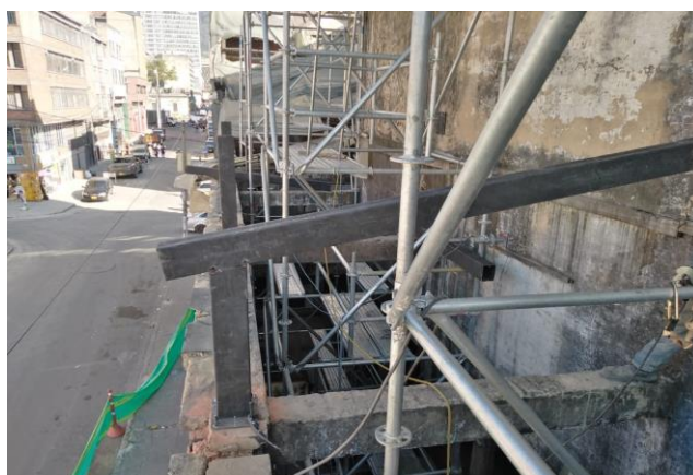
FOTO 8- Armado de estructura metálica para la sobrecubierta.
