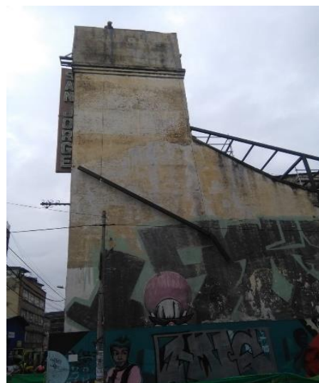
FOTO 4- Armado de estructura metálica para la sobrecubierta.
