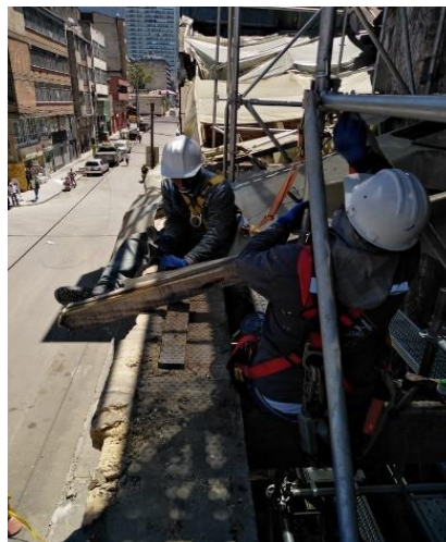
FOTO 6- Armado de estructura metálica para la sobrecubierta.
