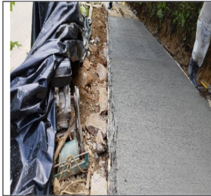
Vaciado de concreto
