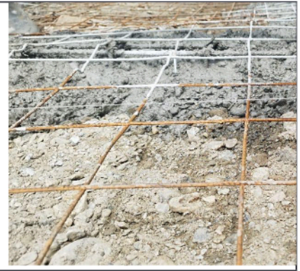
Armado de malla para vaciado
