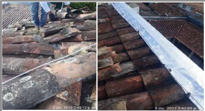
Comentario: recorrido de cubierta e instalación de manto asfáltico con alfaja.
