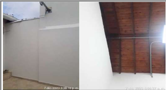
Comentario: impermeabilización con pañete y pintura de patio.
