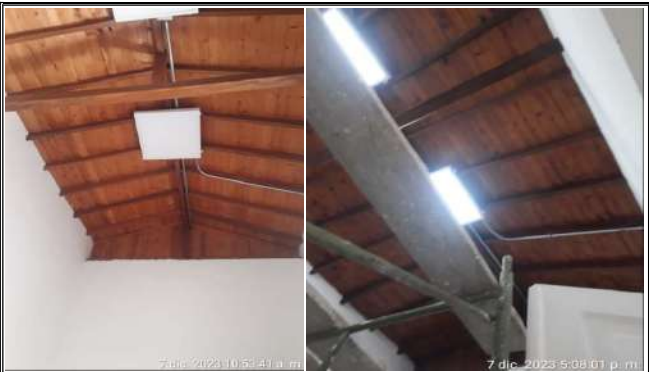
Comentario: cambio de luminarias de 60*60cm.
