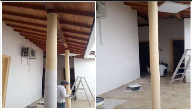
Comentario: pintura de columnas de patio.
