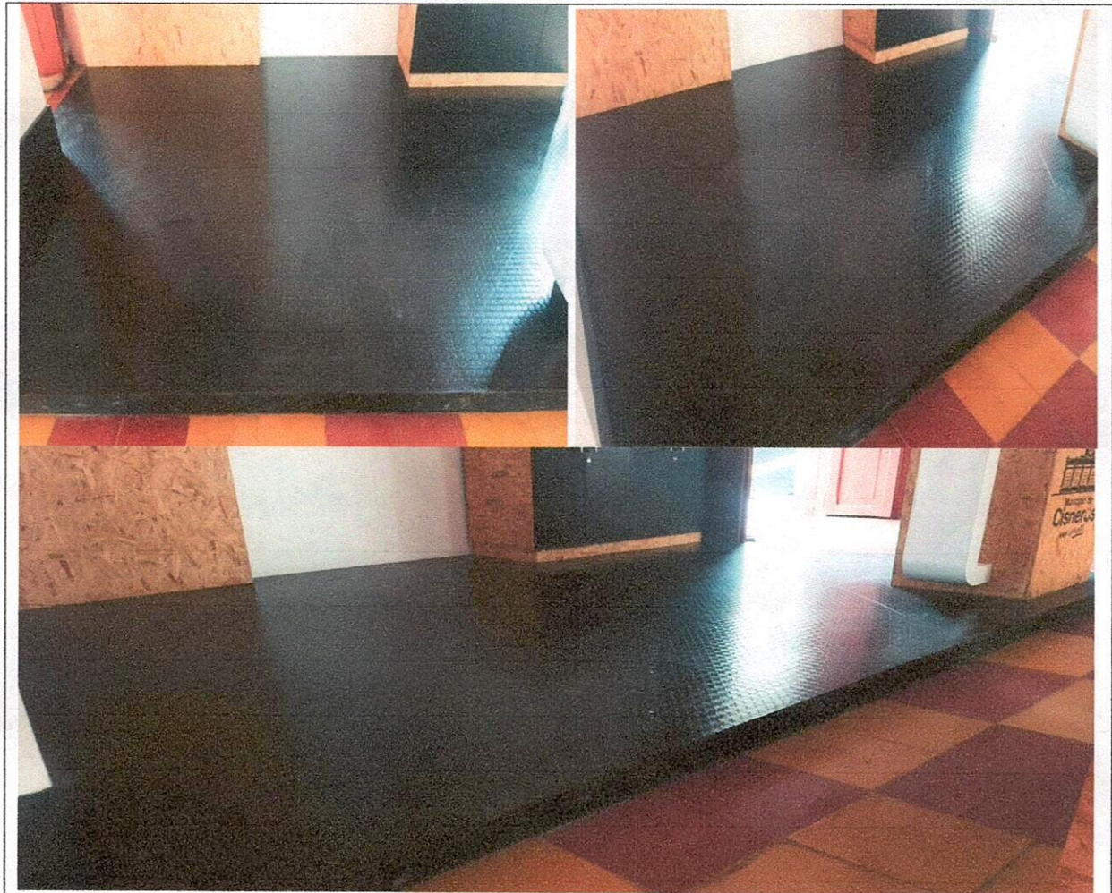
ANEXO 3: INSTALACIÓN DE TABLERO FONDO OSB DE 15 MM DE GRUESO, 3. 80 DE LARGO, 2.44 DE ALTO EN MDF BLANCO PINTADO EN LACA NO AMARILLABLE
