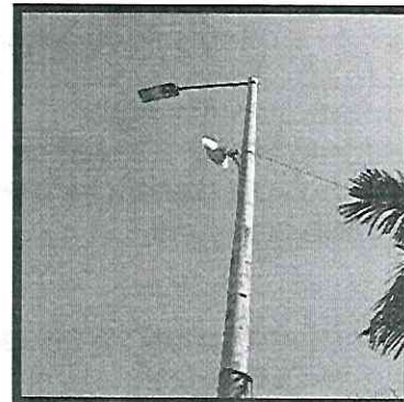
Instalación servicio de internet por radio enlace Wireless – Canal de Backup
