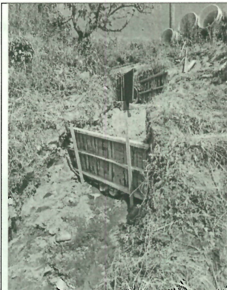
Imagen 3. Excavación y rocería.
