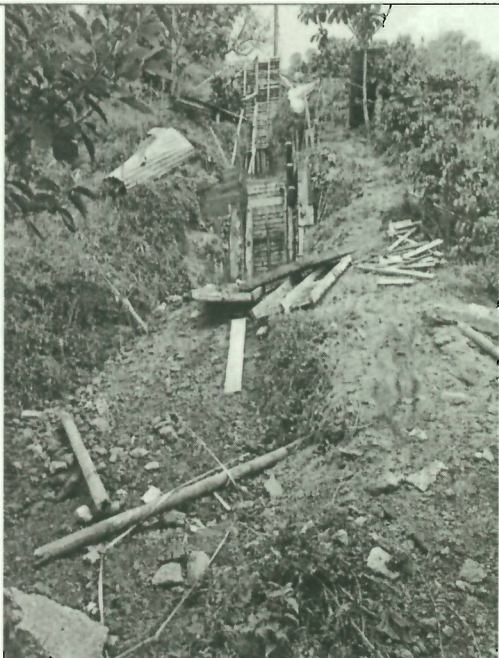
Imagen 6. Concreto para cajas.
