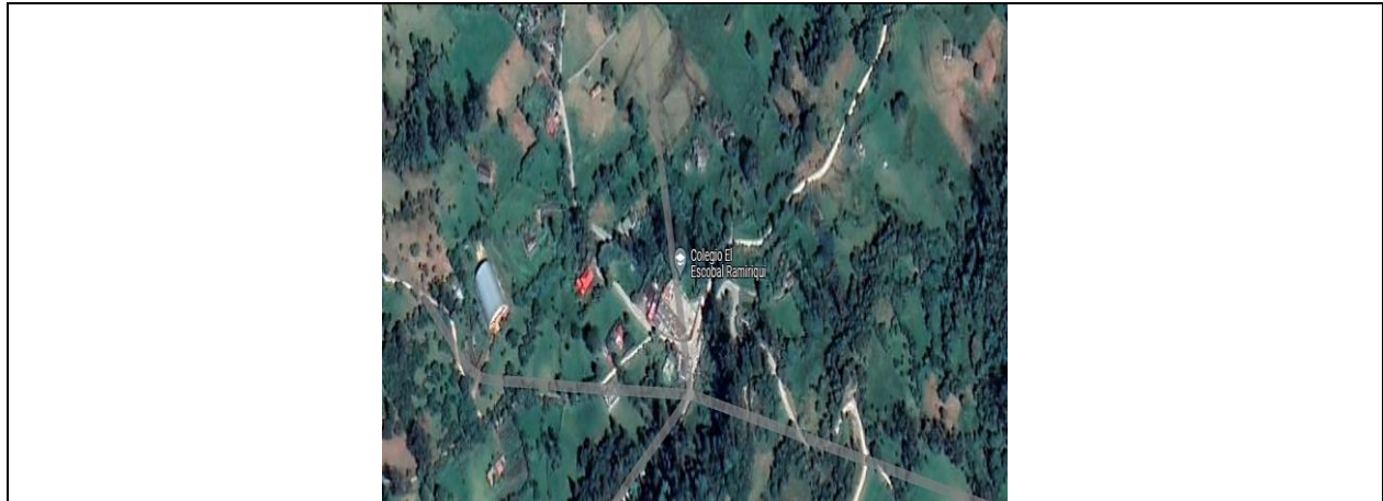
FOTO No 1. EL PROYECTO SE ENCUENTRA UBICADO EN EL DEPARTAMENTO DE BOYACÁ EN EL MUNICIPIO DE RAMIRIQUÍ BOYACÁ -VEREDA EL ESCOBAL
