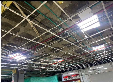
AVANCE INSTALACION DE ESTRUCTURA DE CIELO RASO NUEVO
