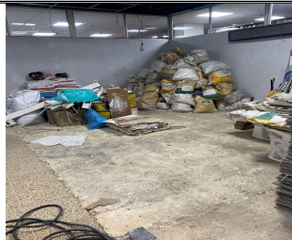
DEMOLICION DE PISO EN ZONA 1 ATENCION AL PUBLICO
