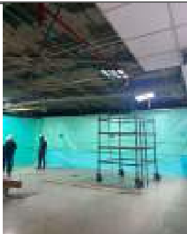
AVANCE DESMONTE DE CIELO RASO EN AMPLIACION DE ZONA 1
