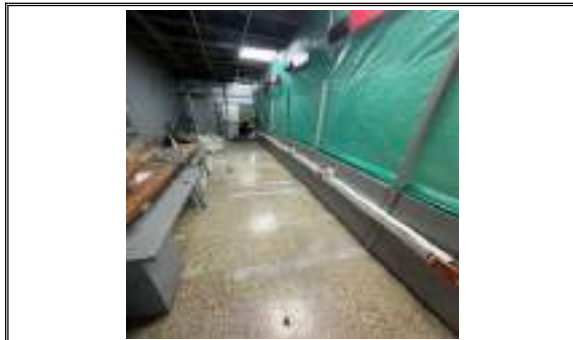
AVANCE DEMOLICION DE DIVISIONES EN PUESTOS DE TRABAJO ZONA 1 ATENCION AL PUBLICO
