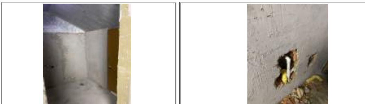
PAÑETE EN BAÑOS ATENCION AL PUBLICO
