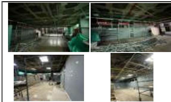
Comentario: DESMONTE DE CIELO RASO CON SU RESPECTIVA ESTRUCTURA EXISTENTE
