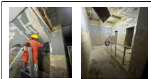
Comentario: DESMNOTE DE CIELO RASO INTERIOR BAÑO ATENCION AL USUARIO Y RESANES GENERALES
