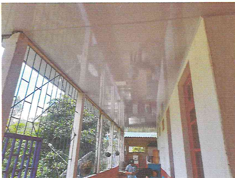
Instalación de Lamina PVC para cielo raso
