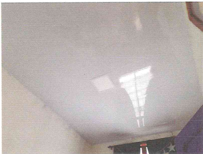
Instalación de Lamina PVC para cielo raso
