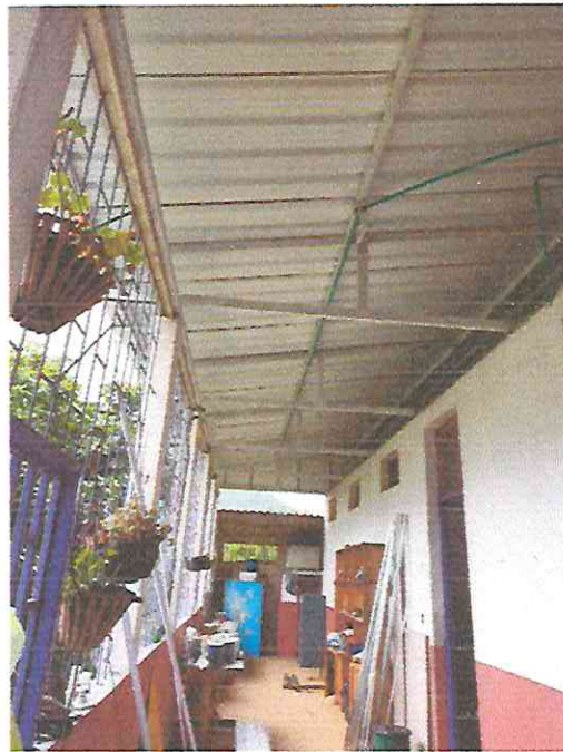
Instalación de tubería Conduit de 1/2" y 1"
