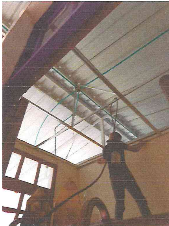
Instalación de estructura galvanizada para cielo raso
