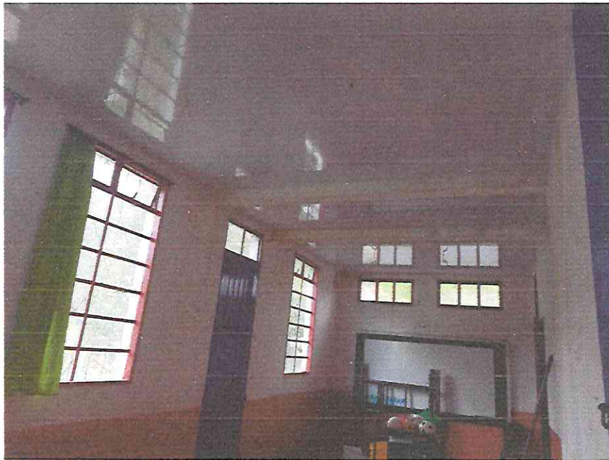
Instalación de Lamina PVC para cielo raso
