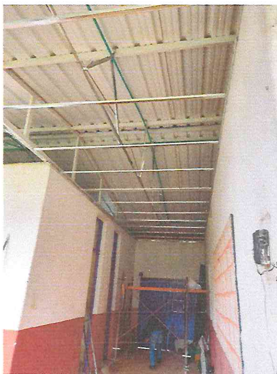
Instalación de estructura galvanizada para cielo raso
