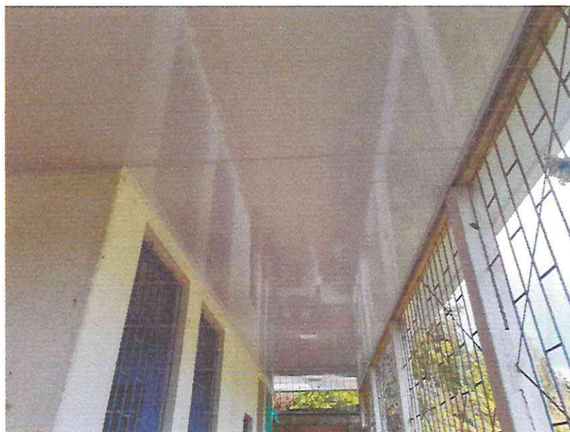
Instalación de Lamina PVC para cielo raso
