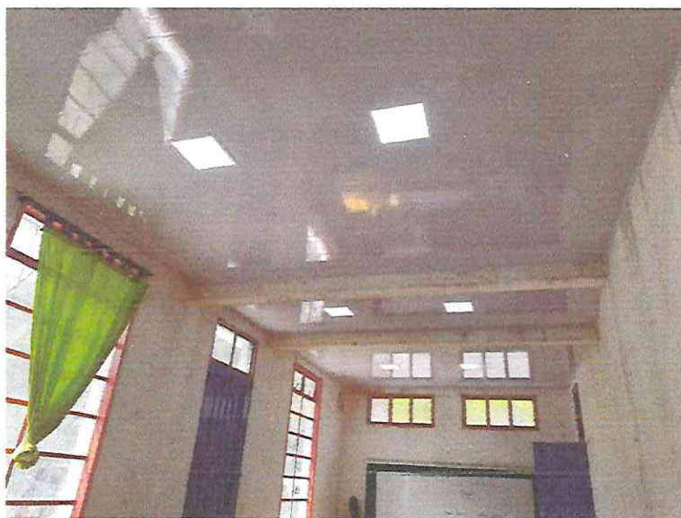
Instalación de Lamina PVC para cielo raso y lámparas LED de 21w
