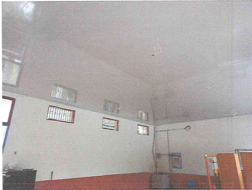
Instalación de Lamina PVC para cielo raso
