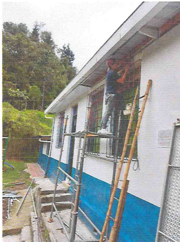
Instalación de lamina PVC, para anchos menores a 0,50 m
