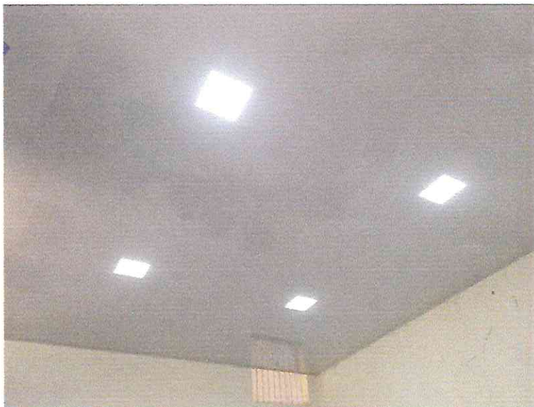
Instalación de lámparas LED de 21W
