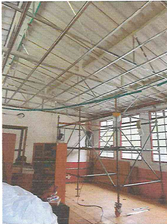
Instalación de estructura galvanizada para cielo raso y tubería conduit
