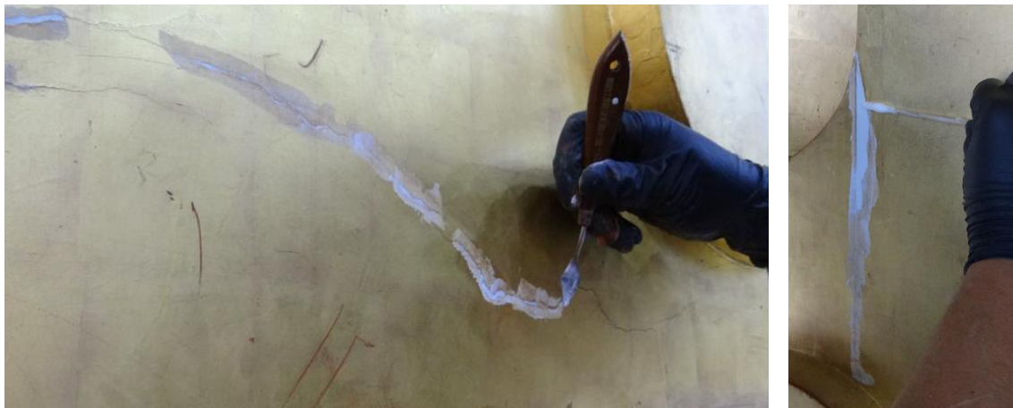
Fotografía 48 y 49 Proceso de resanes de enlucido con estuco y limpieza de bordes mediante hisopado
