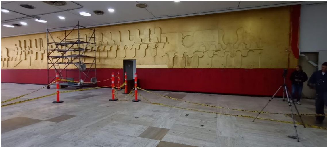
Fotografía 1 Vista cerramiento perimetral de obra primer piso
