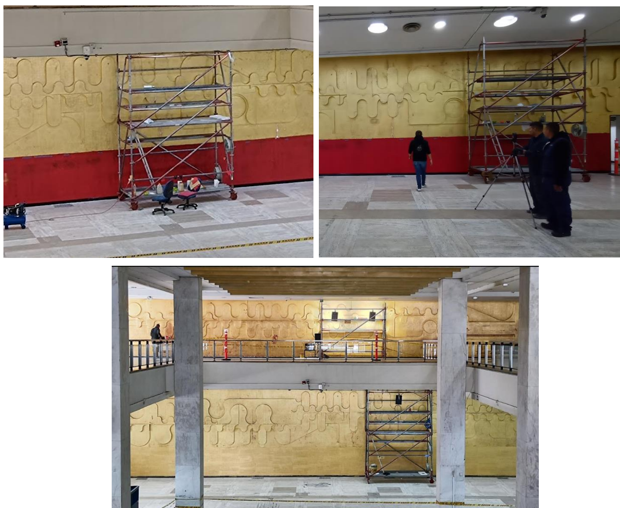
Fotografía 3, 4 y 5 Andamio certificado e instalado para acceder a las zonas de trabajo del primer y segundo piso
