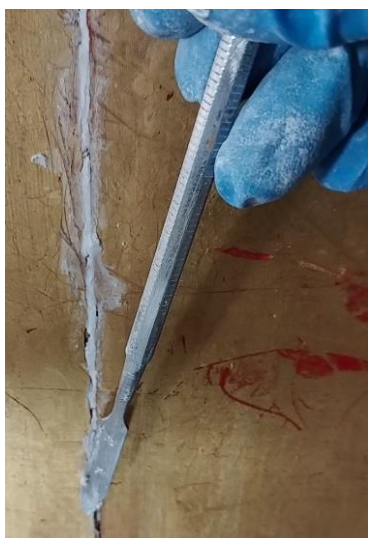
Fotografía 41 Aplicación de masilla
