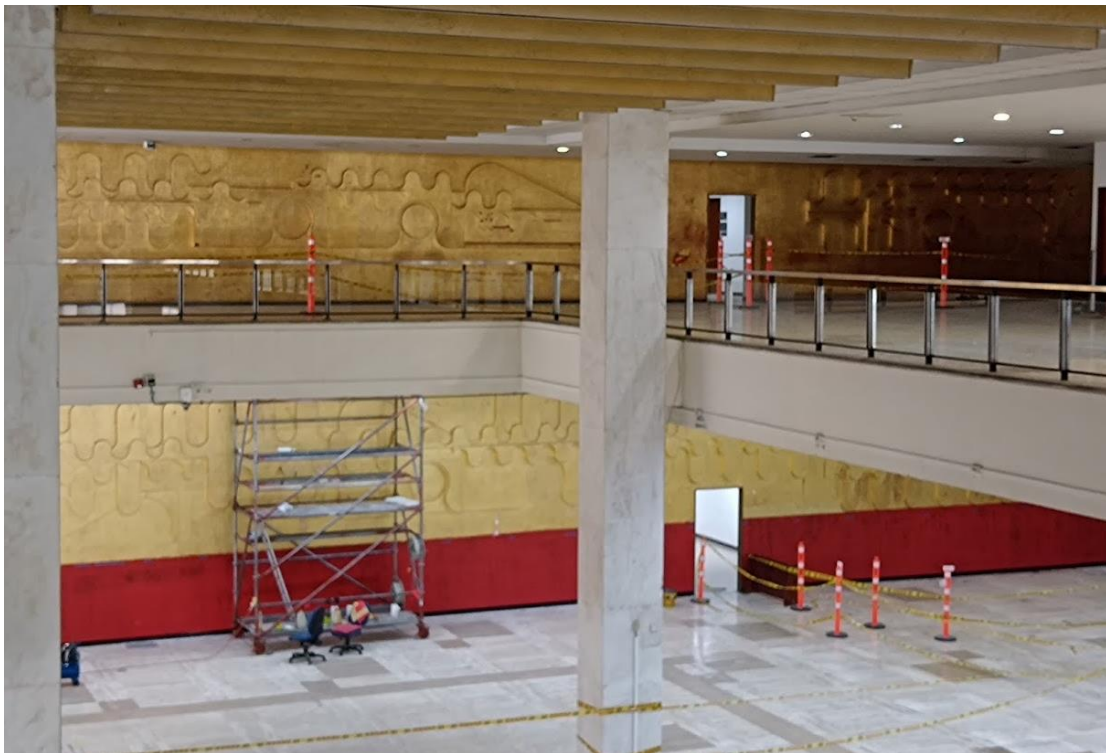
Fotografía 2 Vista cerramiento perimetral de obra primer y segundo piso
