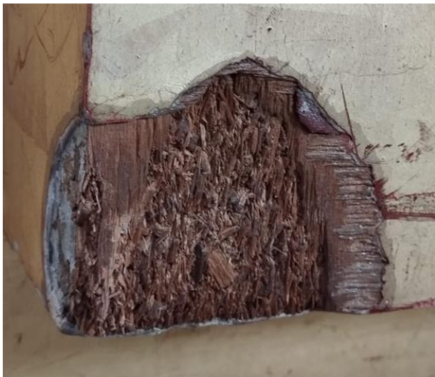
Fotografía 30 Zona de faltante en relieve
