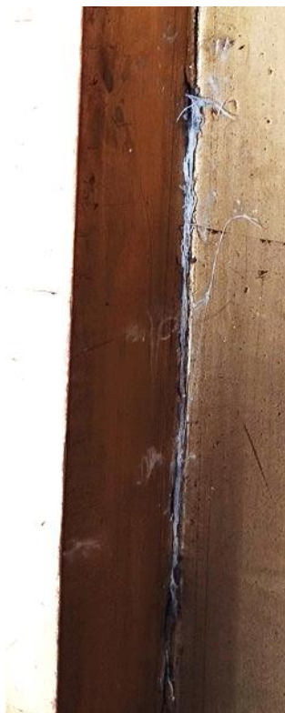
Fotografía 37 Relleno de tela en zona de separación de partes
