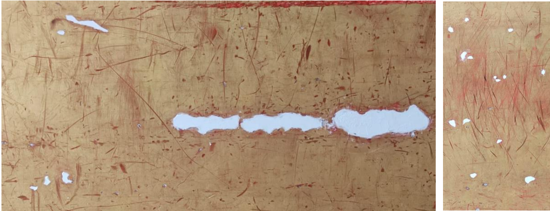
Fotografía 42 y 43 Detalle de resanes elaborados en el mural del segundo nivel
