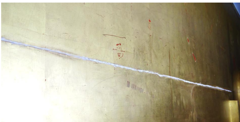
Fotografía 40 Zona tratada con tela y caseína
