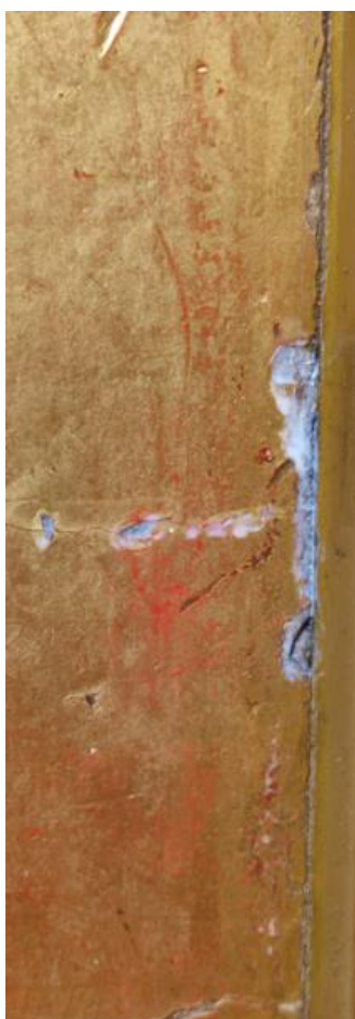
Fotografía 13 Proceso de inyección del adhesivo en grietas en muro. Se observa el primal aun penetrando en la zona
