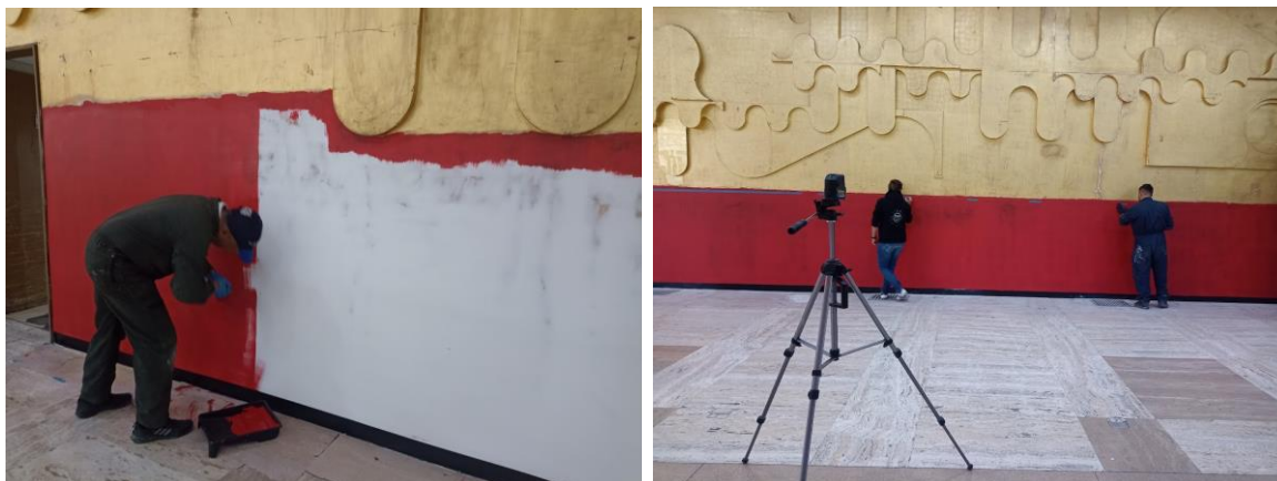
Fotografía 50 y 51 Aplicación de pintura base
