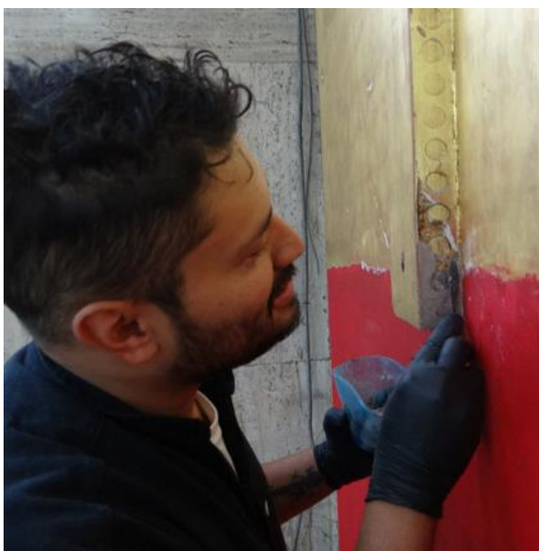
Fotografía 24 Proceso de resane de soporte
