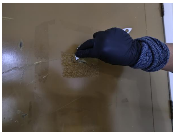
Fotografía 58, 59, 60 y 61 Proceso de restauración de puerta metálica existente
