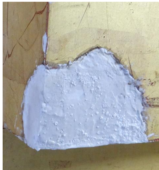
Fotografía 35 Proceso de resane sobre la tela
