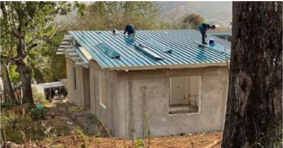
PROFESIONAL SISOMA EN OBRA - MONTAJE DE TEJA DE CUBIERTA SUPERVISADA POR SISOMA
