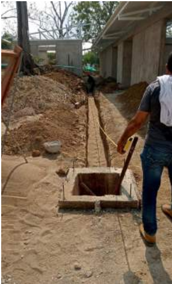
EXCAVACIONES Y CAJAS ELECTRICAS
