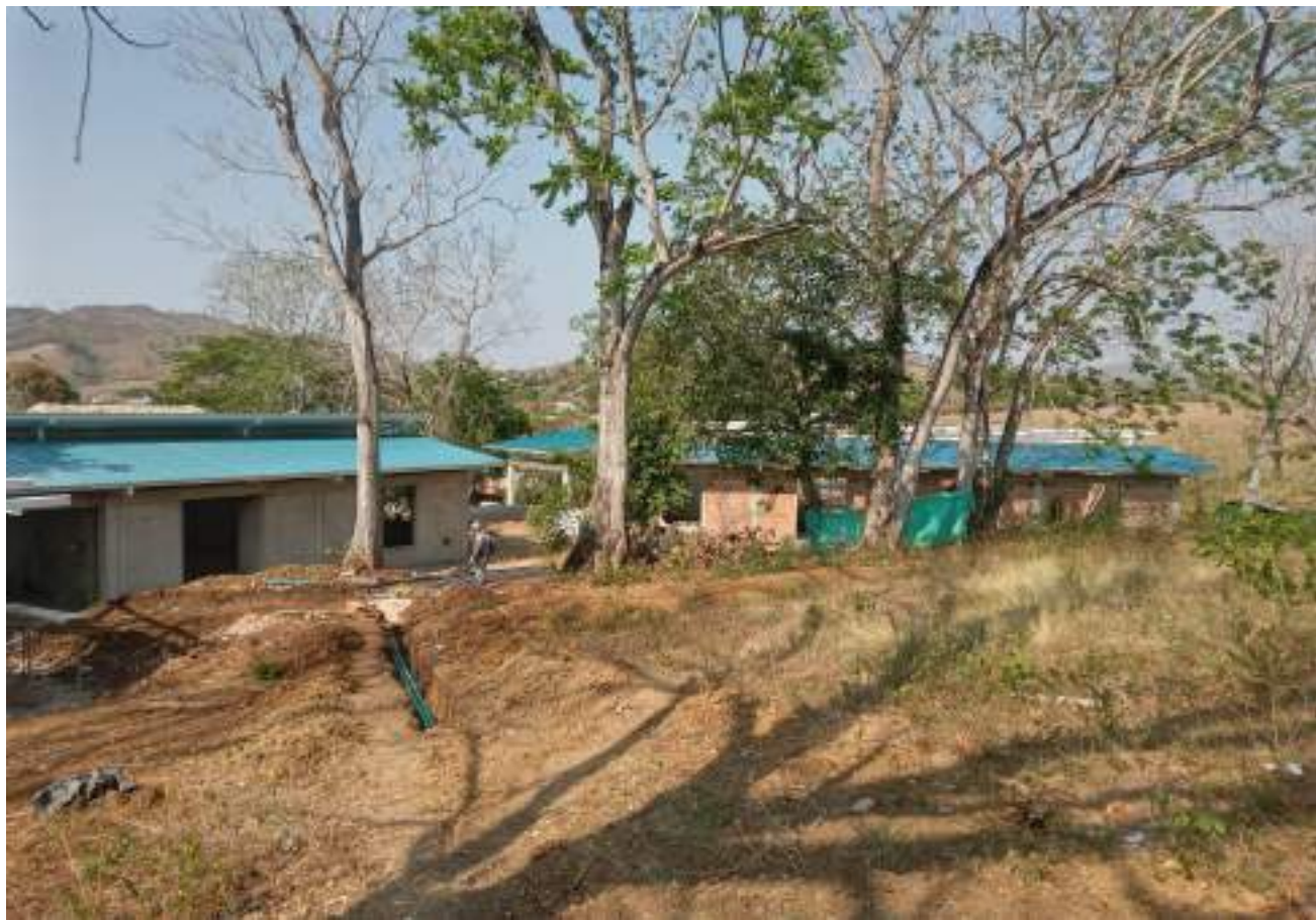
TEJA DE CUBIERTA INSTALADA
