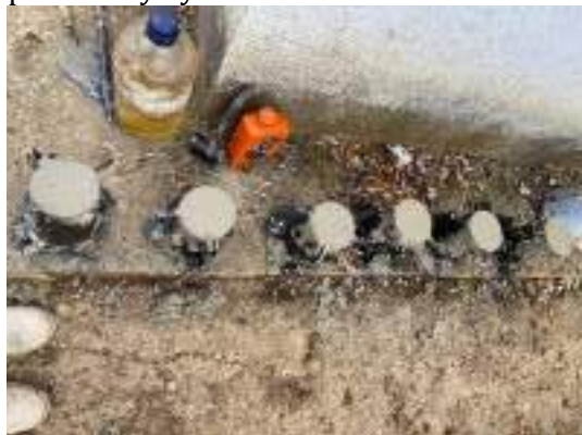
Toma de cilindros en obra
