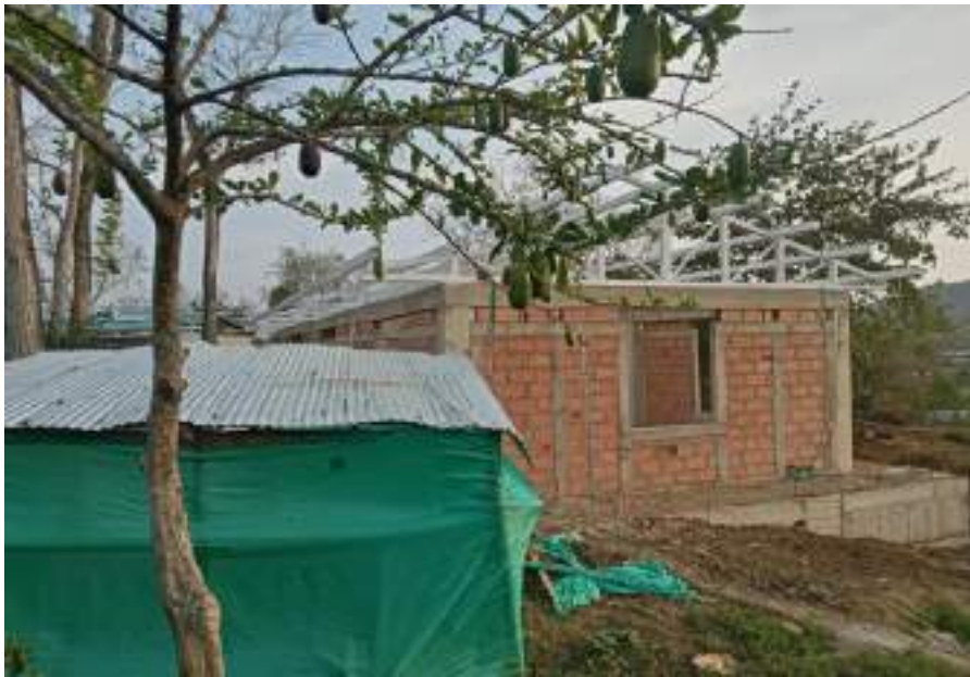
CAMPAMENTO DE OBRA REUBICADO
