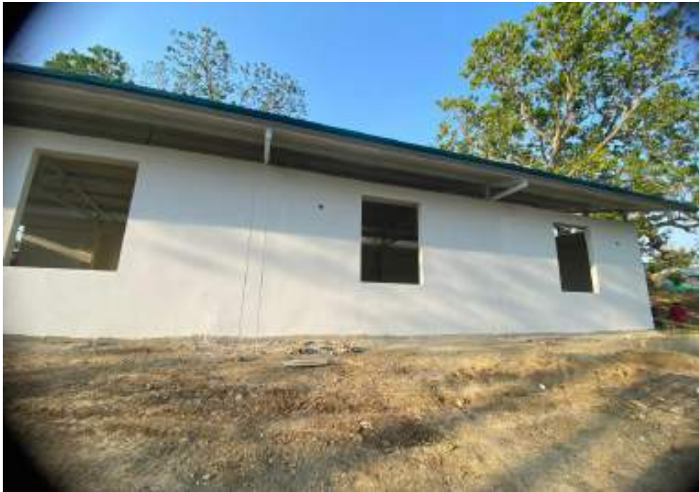
VISTA EXTERIOR BLOQUE D
