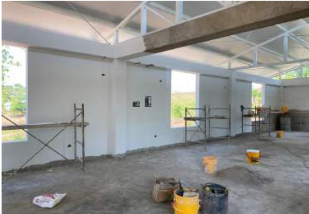
VISTA INTERIOR BLOQUE A
