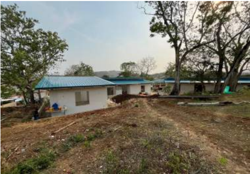
Obra libre de escombros
