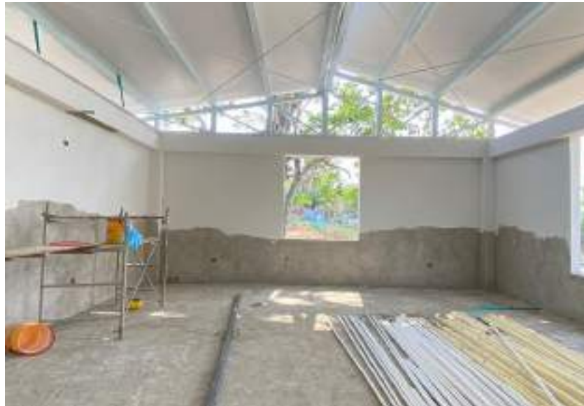
ACOPIO DE MATERIALES
