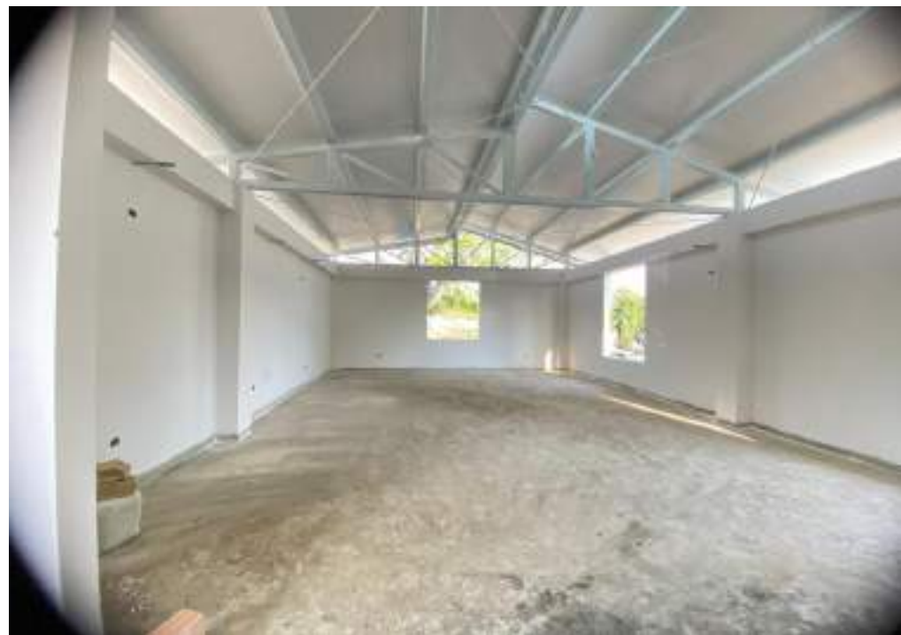
VISTA INTERIOR BLOQUE D
