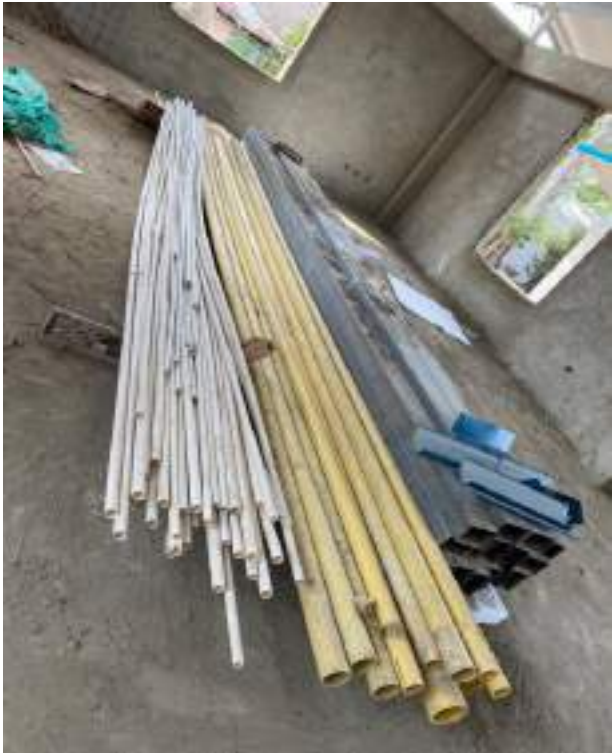
ACOPIO DE MATERIALES
