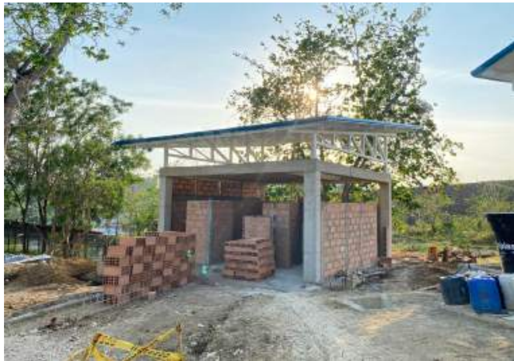
VISTA BLOQUE B
