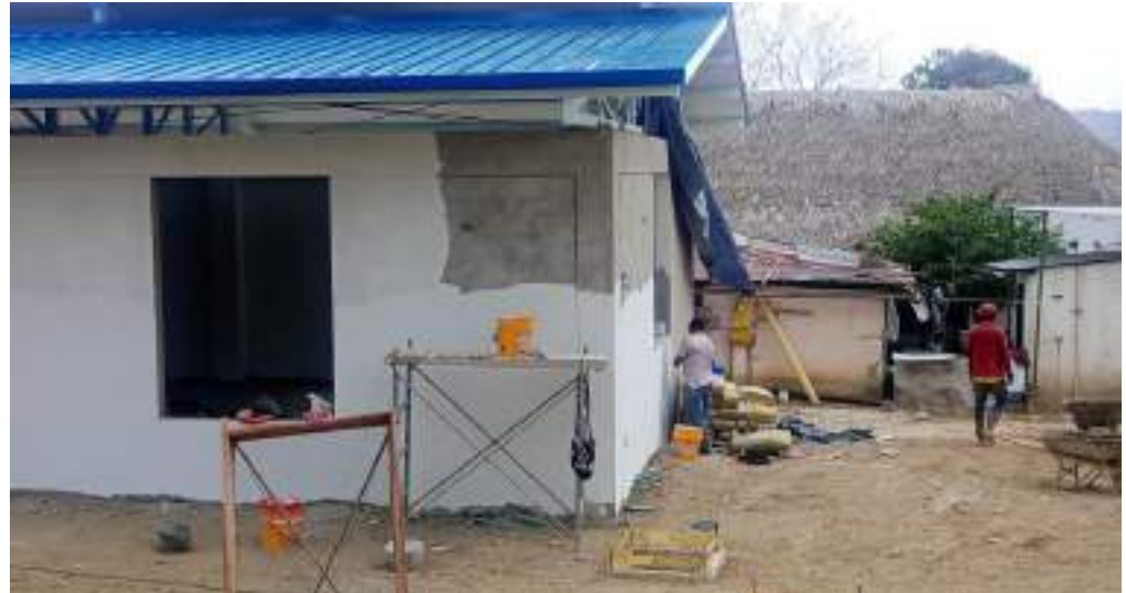
Obra libre de escombros
