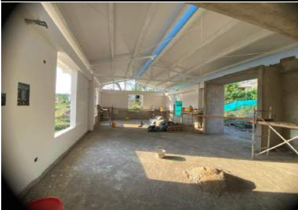
VISTA INTERIOR BLOQUE A
