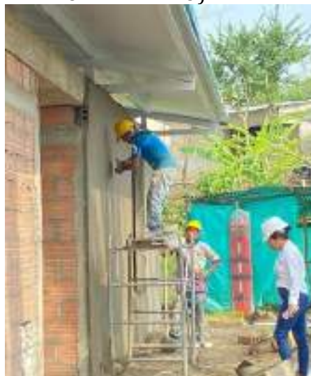
PAÑETE IMPERMEABILIZADO (INTERNO Y EXTERNO)
