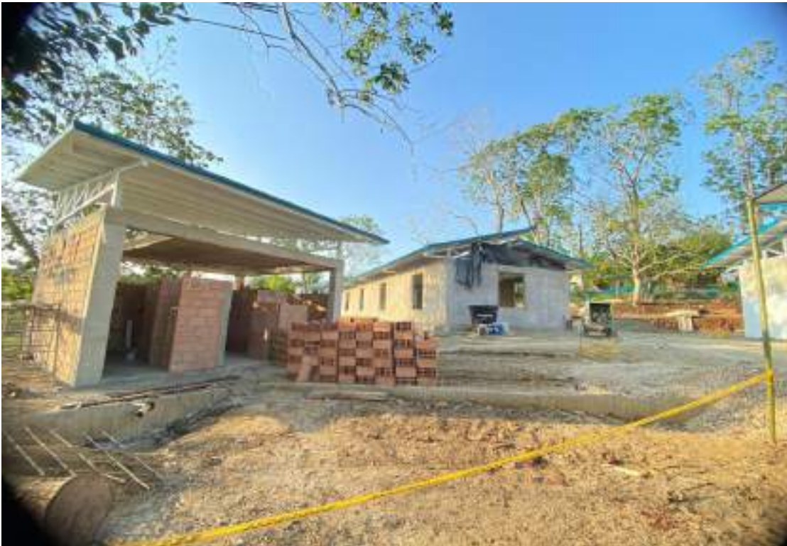
ACOPIO DE MATERIALES
