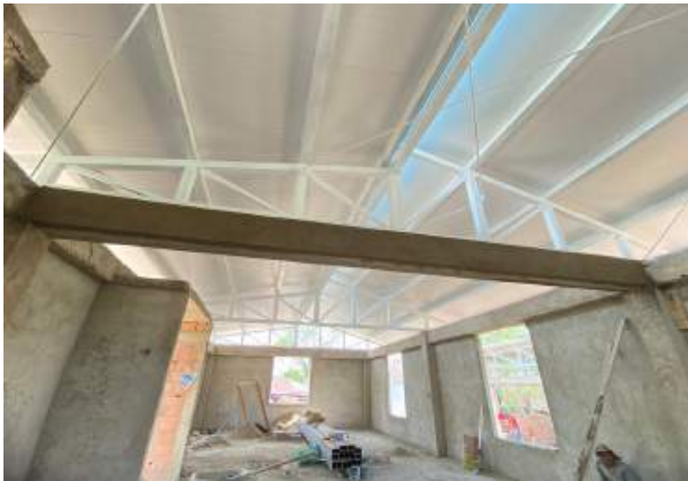
ESTRUCTURA METALICA Y TEJA DE CUBIERTA
