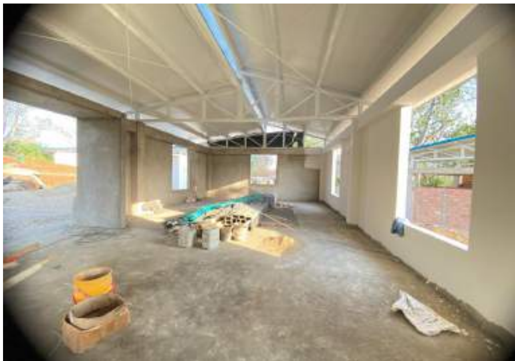
VISTA INTERIOR BLOQUE A
