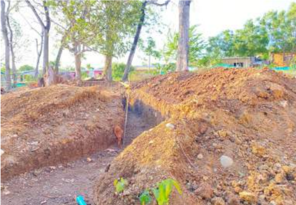
Material resultante de excavaciones
