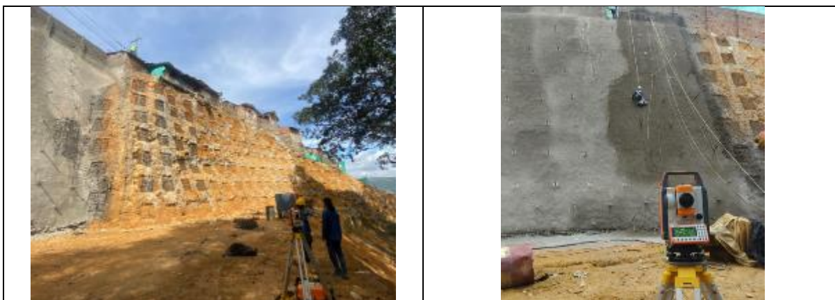
Fotografía 7 – Replanteo, control y medición topográfica – Sector La Gloria
