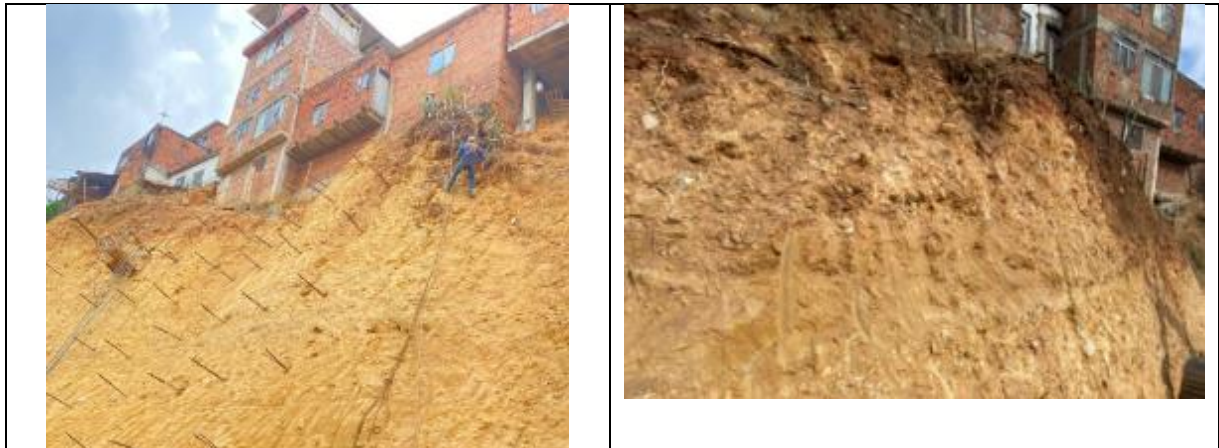
Fotografía 44 - Perfilado a mano descolgado de talud – Sector Pablo VI
