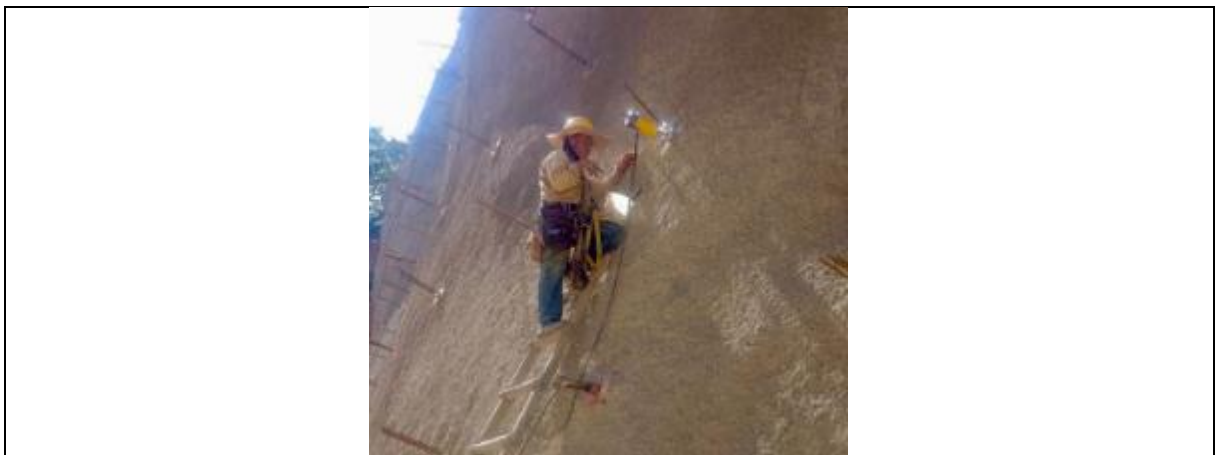
Fotografía 18 - Tensionamiento de anclajes – Sector La Gloria
