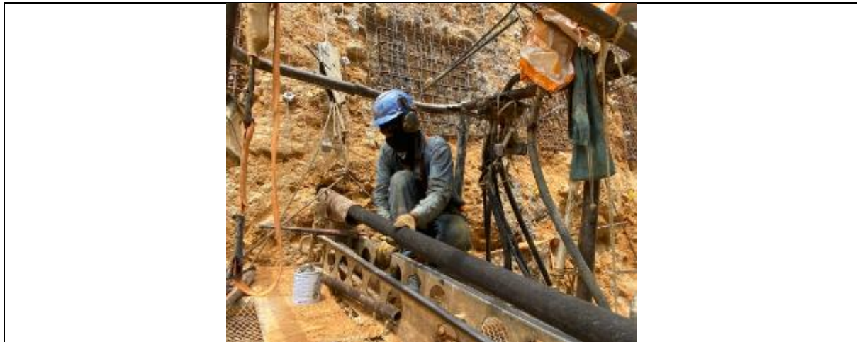
Fotografía 26 - Drenes con tubería P.V.C. ranurada D=2" para drenes de penetración a 15 mts horizontal – Sector La Gloria
