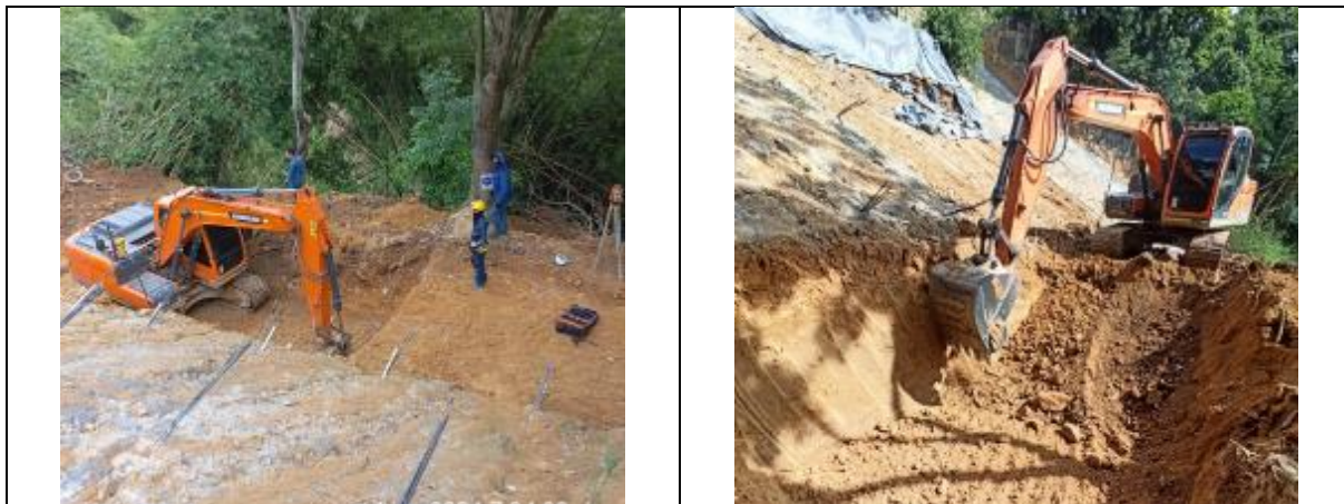
Fotografía 8 - Excavación a tajo abierto en taludes con acarreo libre - Sector La Gloria
