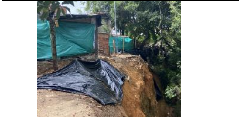
Fotografía 4. Viviendas en La Gloria
