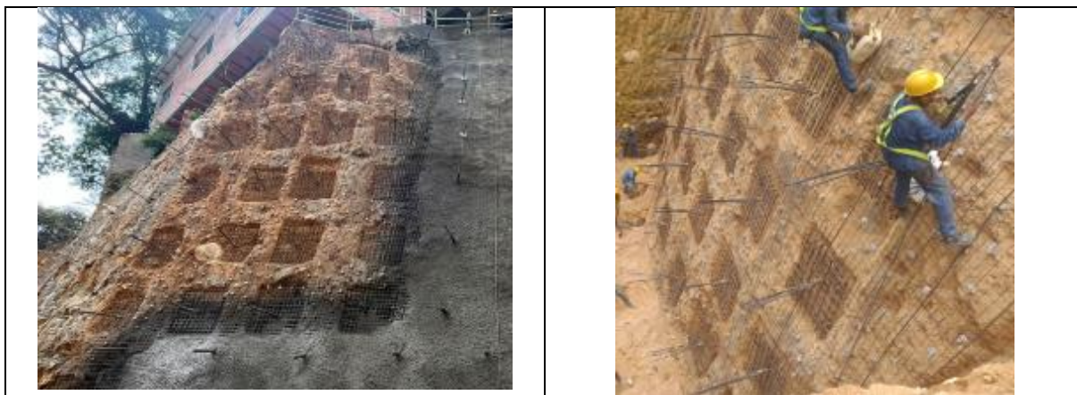
Fotografía 32 - Suministro y colocación malla electrosoldada calibre 10 – Sector Nazareth
