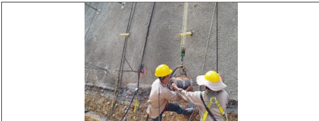
Fotografía 21 - Suministro e instalación de Popora de 3 agujeros conicos para cuña de 1/2" – Sector La Gloria
