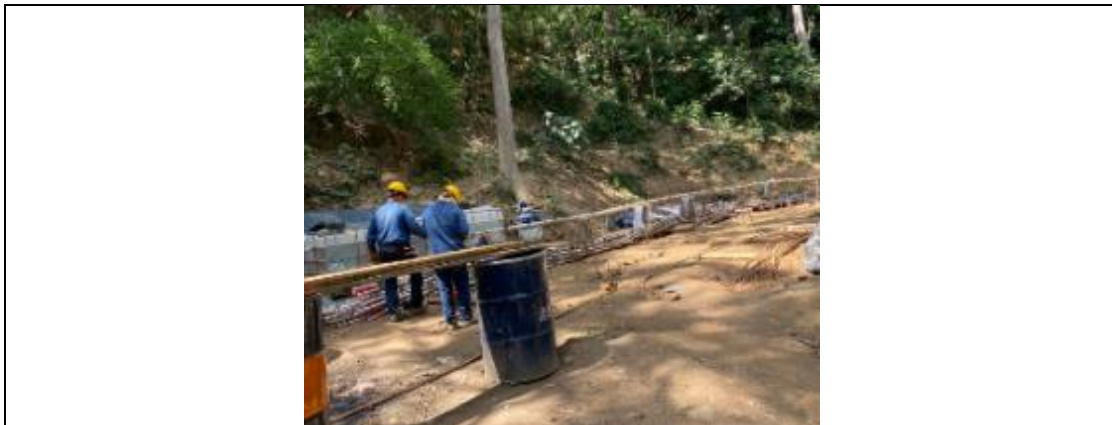
Fotografía 47. Suministro y colocación de anclajes 3 cables D =1/2" L=30 m
