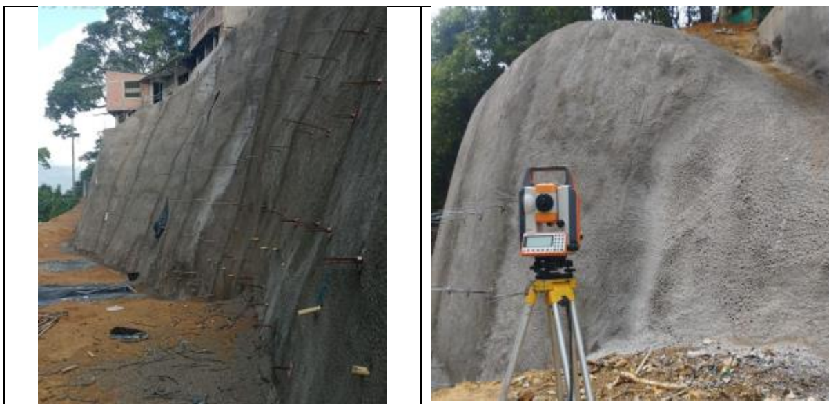
Fotografía 29 - Suministro y colocación de concreto lanzado Con mezcla húmeda De espesor 10 cm – Sector Nazareth
