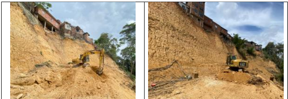
Fotografía 45 - Excavación a tajo abierto en taludes con acarreo libre - Sector Pablo VI
