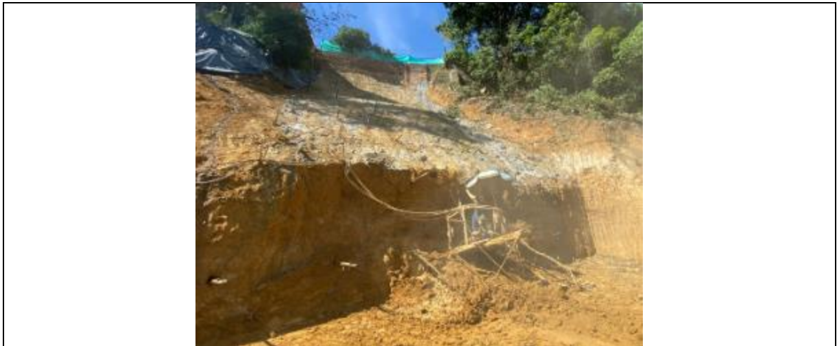
Fotografía 24 - Ejecución de perforaciones horizontales en taludes con pendientes mayores a 1:1 con equipo de perforación descolgado para anclajes mayores a 15.00 m - Sector La Gloria
