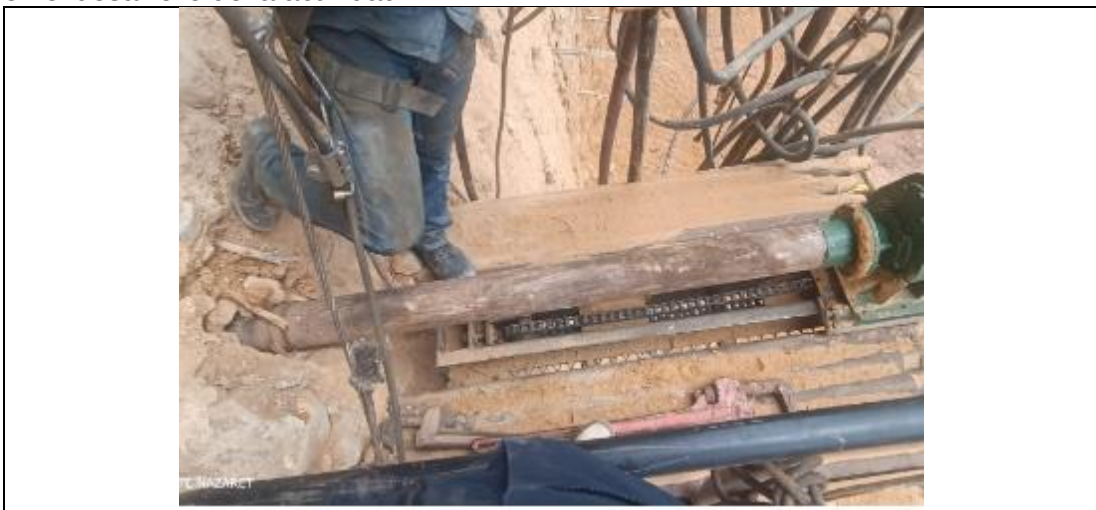
Fotografía 50. Encamisado en perforaciones horizontales para anclajes y drenes de penetración horizontal - Sector Nazareth
