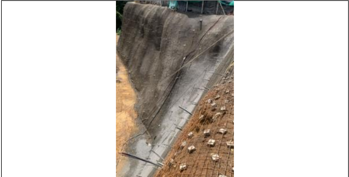
Fotografía 19 - Suministro y colocación malla electrosoldada calibre 10 – Sector La Gloria
