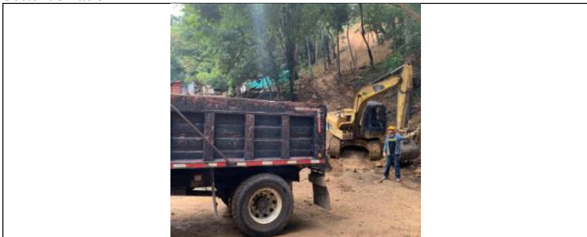
Fotografía 43. Retiro de basuras y escombros – Sector Pablo VI
