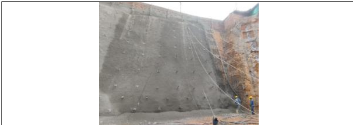
Fotografía 13 - Suministro y Colocación de concreto de 3000 psi con mezcla húmeda para zapatas – Sector La Gloria
