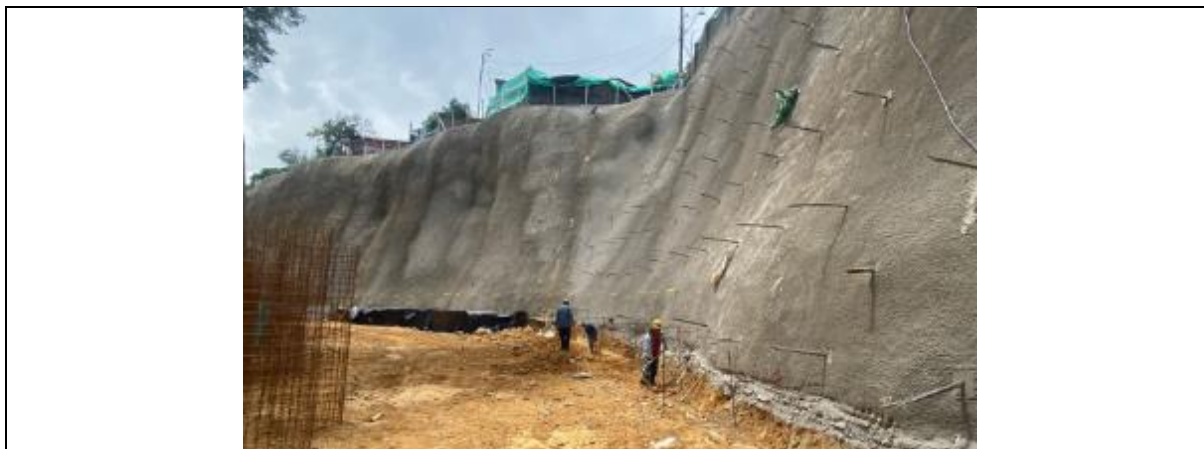
Fotografía 14 - Suministro y colocación de concreto lanzado Con mezcla húmeda De espesor 10 cm – Sector La Gloria
