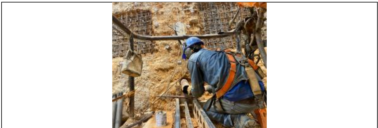
Fotografía 36 - Encamisado en perforaciones horizontales para anclajes y drenes de penetración horizontal – Sector Nazareth
