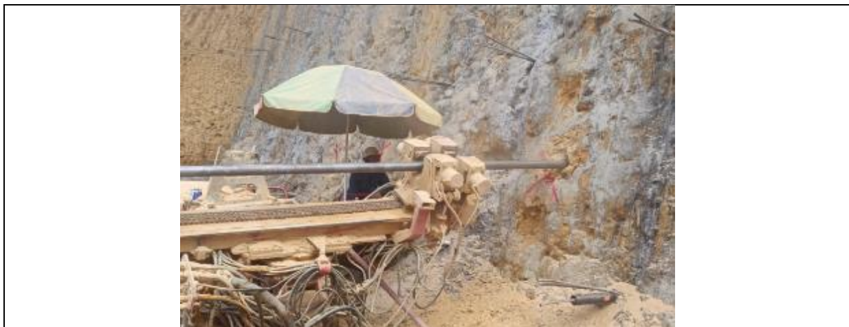
Fotografía 34 - Ejecución de perforaciones horizontales en taludes con pendientes mayores a 1:1 con equipo de perforación descolgado para anclajes de 0.00 a 15.00 – Sector Nazareth
