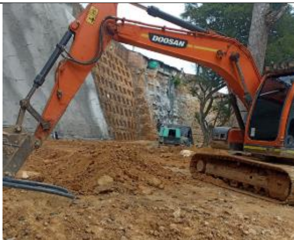
Fotografía 12 - Distribución y conformación de material de corte en el sitio – Sector La Gloria
