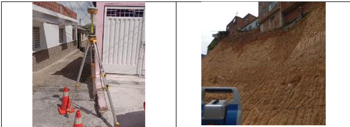
Fotografía 41 – Replanteo, control y medición topográfica – Sector Pablo VI
