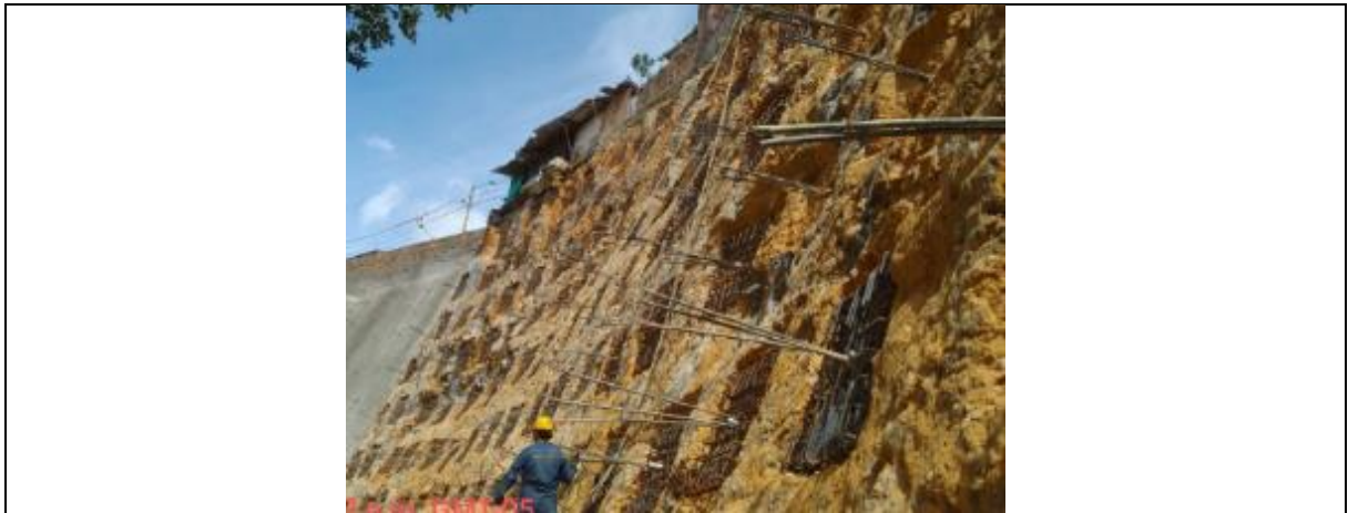
Fotografía 17 - Suministro y colocación de anclajes 3 cables D=1/2" L=30 m - Sector La Gloria
