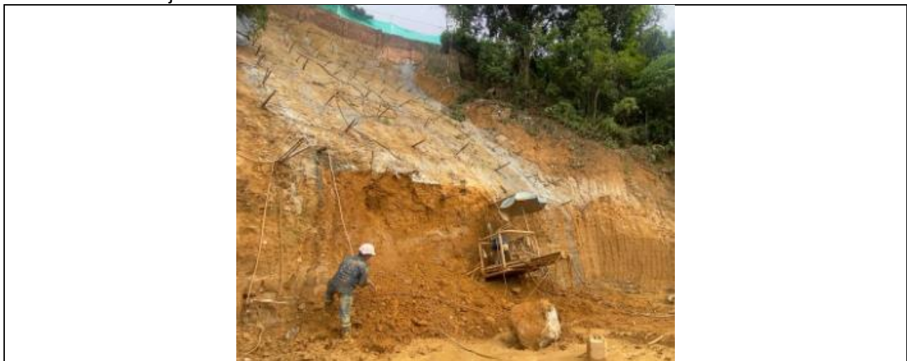
Fotografía 23 - Ejecución de perforaciones horizontales en taludes con pendientes mayores a 1:1 con equipo de perforación descolgado para anclajes de 0.00 a 15.00 m - Sector La Gloria
