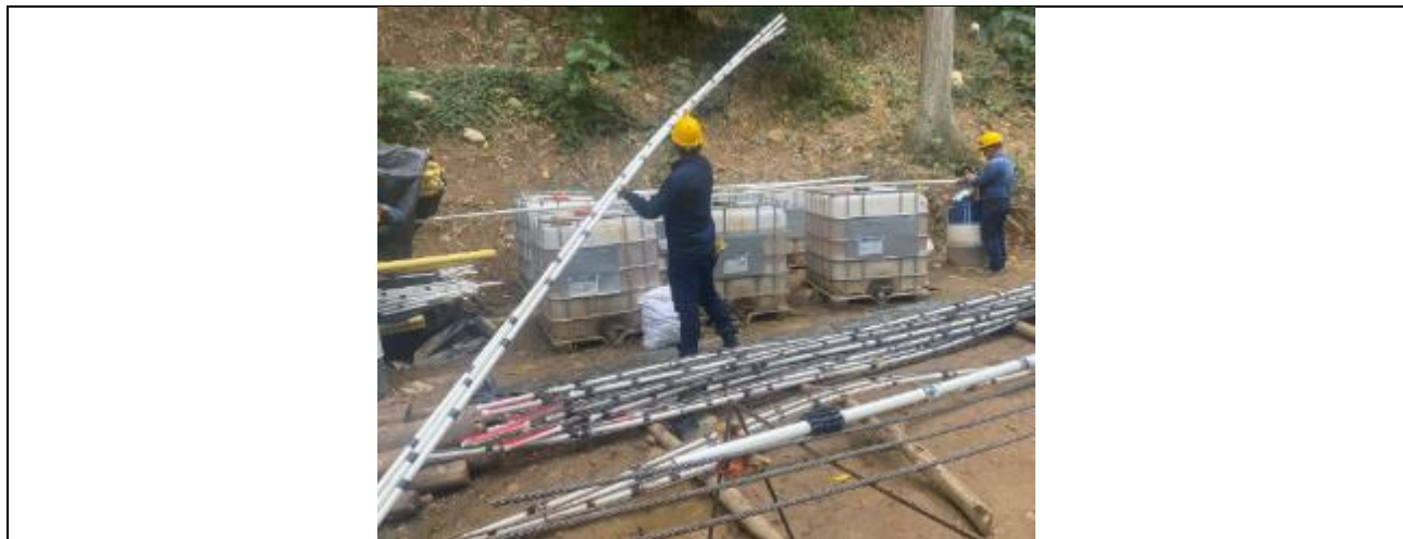
Fotografía 30 - Suministro y colocación de anclajes 3 cables D = 1/2'' L = 25m – Sector Nazareth
