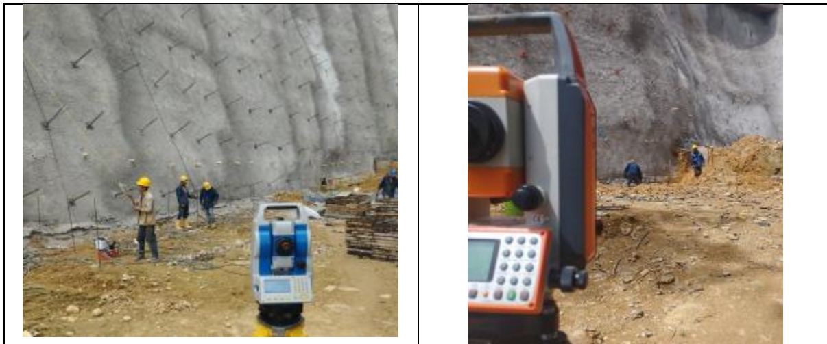
Fotografía 28 - Replanteo, control y medición topográfica – Sector Nazareth
