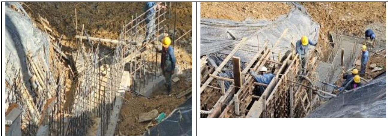
Fotografía 37 - Estructura de disipación de energía – Sector Nazareth
