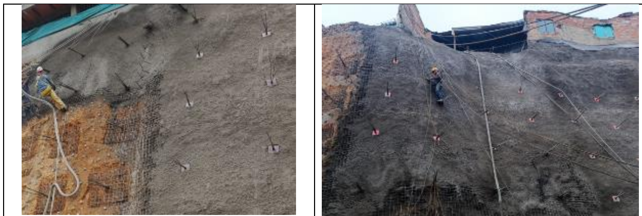
Fotografía 33 - Suministro e instalación de Platina de 200mm X 200mm X 12mm con tres agujeros – Sector Nazareth
