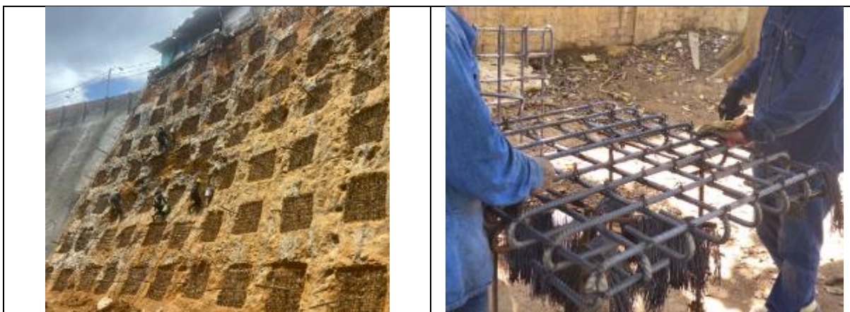
Fotografía 16 - Suministro y colocación Acero de refuerzo fy 4200 kg / cm 2 – Sector La Gloria
