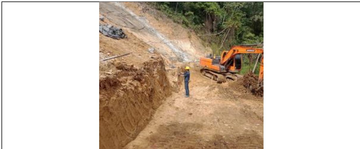
Fotografía 10 - Excavación a tajo abierto en taludes con acarreo libre en roca a cualquier profundidad - Sector La Gloria
