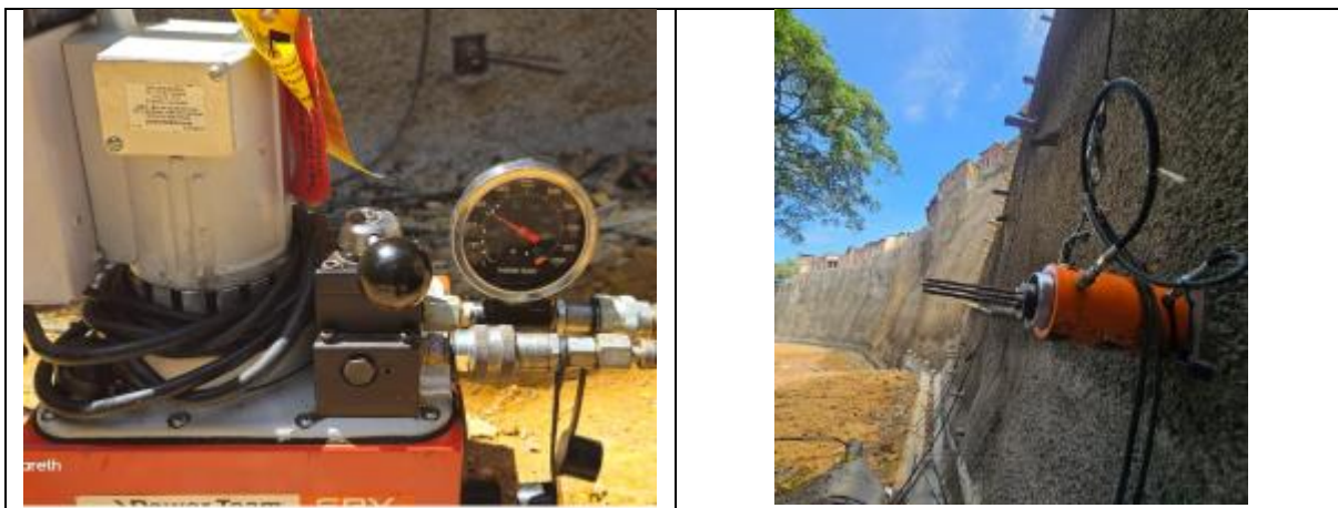
Fotografía 31 - Tensionamiento de anclajes - Sector de Nazareth
