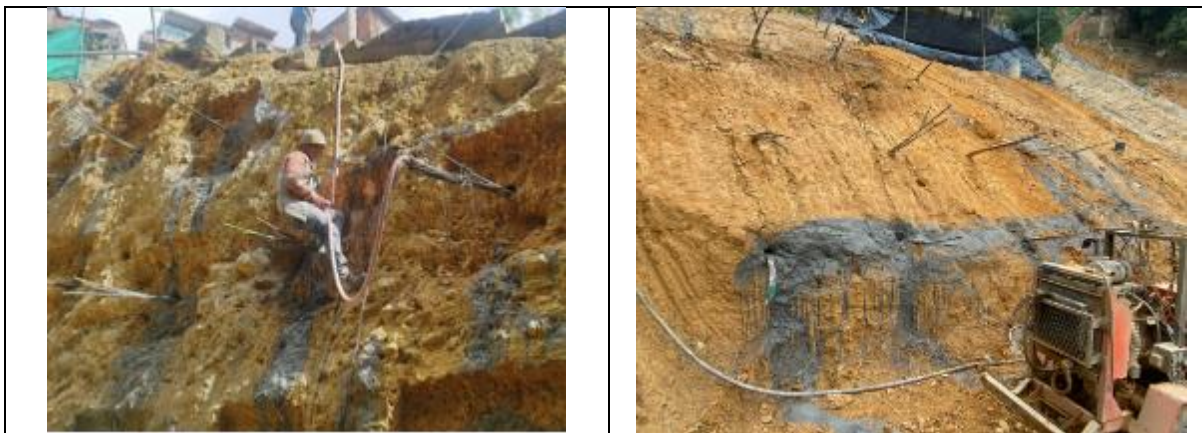
Fotografía 15 - Inyección de lechada para anclajes - Sector La Gloria
