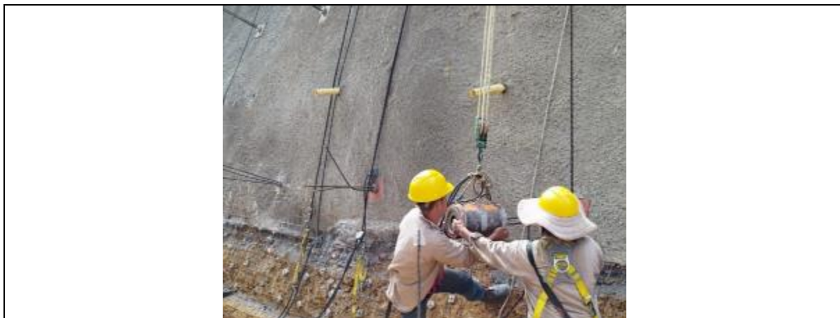
Fotografía 22 - Suministro e instalación Cuña de 1/2" – Sector La Gloria
