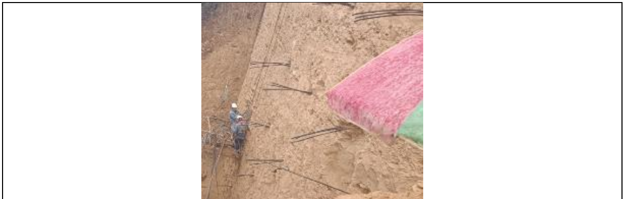
Fotografía 35 - Ejecución de perforaciones horizontales en taludes con pendientes mayores a 1:1 con equipo de perforación descolgado para anclajes mayores a 15.00 m – Sector Nazareth
