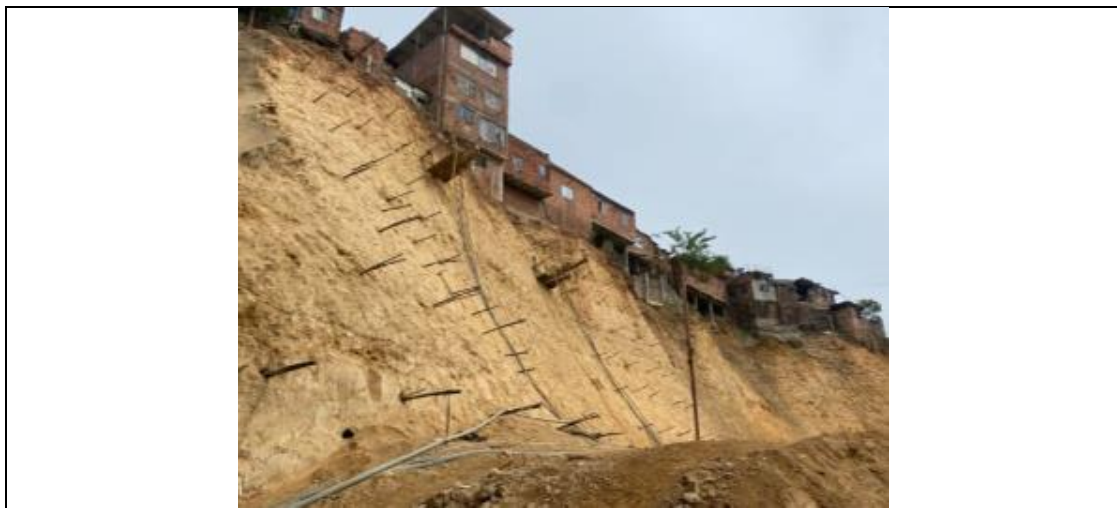
Fotografía 48. Ejecución de perforaciones horizontales en taludes con pendientes mayores a 1:1 con equipo de perforación descolgado para anclajes de 0.00 a 15.00 m - Sector Pablo VI
