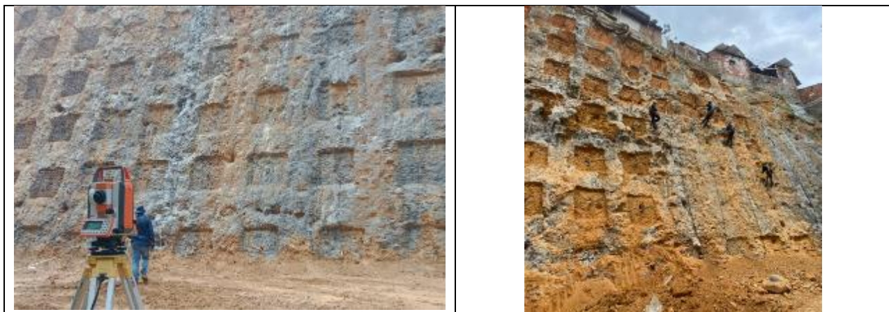
Fotografía 9 - Excavación a tajo abierto en taludes a mano con acarreo libre descolgado para zapatas – Sector La Gloria
