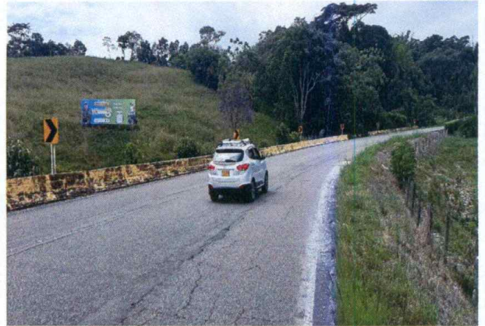
VALLA ALTO BODEGA- VIA MESETAS
