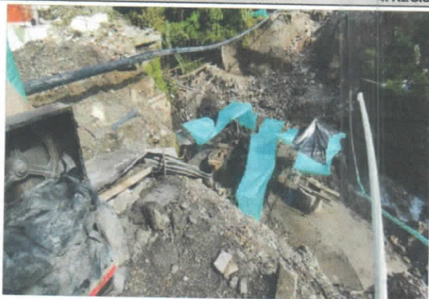
Descripción Foto 1. Avance de las obras
