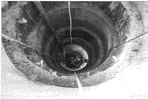
Descripción Foto 1. Actividades anillos de caisson margen izquierda.
