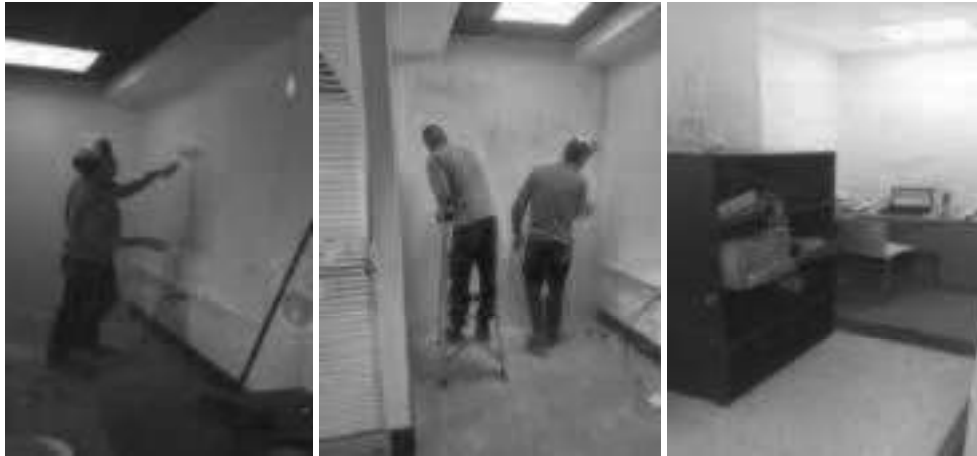
(Resanar, lijar y pintar pared) – PINTURA EDIFICIO (ADECUACION) – Piso N° 5 – Lado oriental – Muro división Planeación y Sindicato
