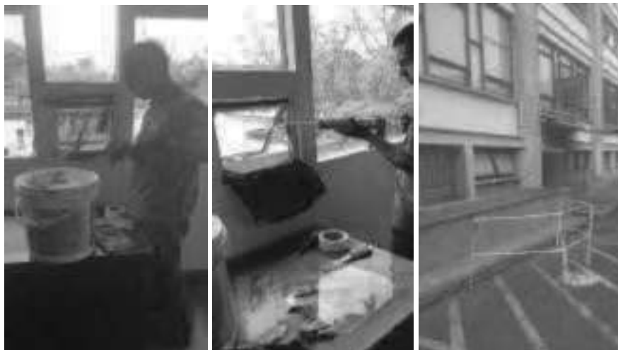
(Otros – Vidrio - Drywall) – Cambiar vidrio partido ventana fachada - 2do piso Secretaría General despacho
