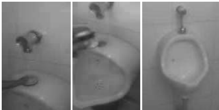
Cambio push orinal – Costado oriental - Piso N° 4 baño damas
