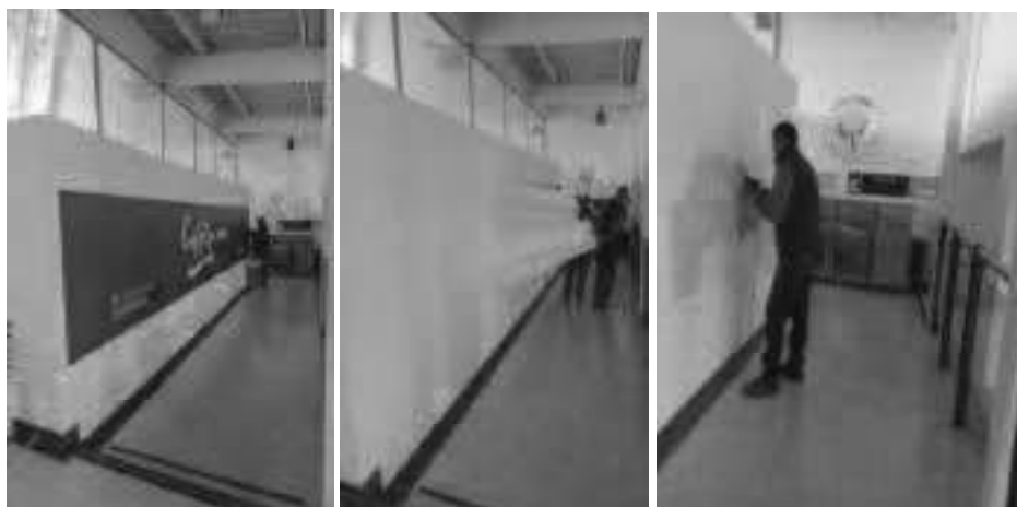
(Pintura - Impermeabilizado) – Edificio – Retirar aviso, impermeabilizar y pintar muro - 6to piso - Fachada exterior cafetería pasillo escalera
