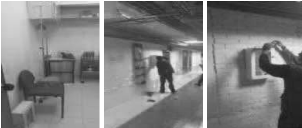
(Mobiliario – Cambio de botiquín primeros auxilio) – Cambiar botiquín de primeros auxilios ubicados en puntos gabinetes contra incendio del edificio piso N° 1 occidente, enfermería y sótano occidente.
