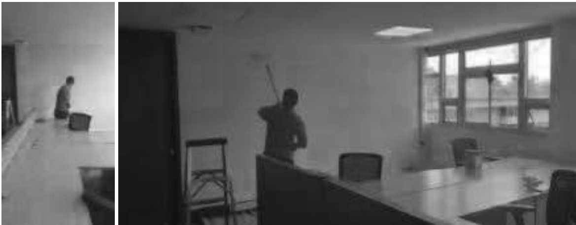
(Resanar, lijar y pintar pared) – PINTURA EDIFICIO – Piso N° 5 - Área grande - Asesores internos – Despacho Ministra.
