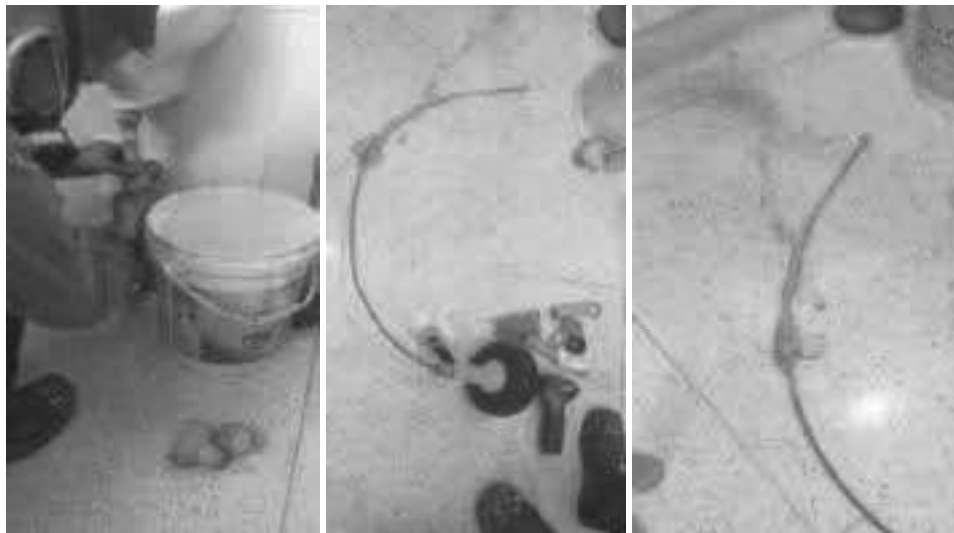
Destapar tubería sanitaria (guaya, kankro y agua a presión) – Oriente - Piso N° 3 – Baño Caballeros (orinal – rejilla)
