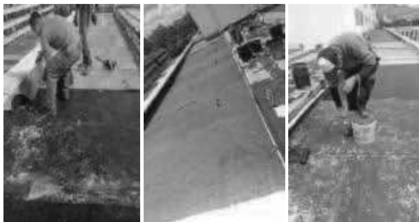
Impermeabilización – Edificio – Cambio de manto asfáltico (foil de aluminio) - Terraza piso 6 área de techo de Cooperación Internacional
