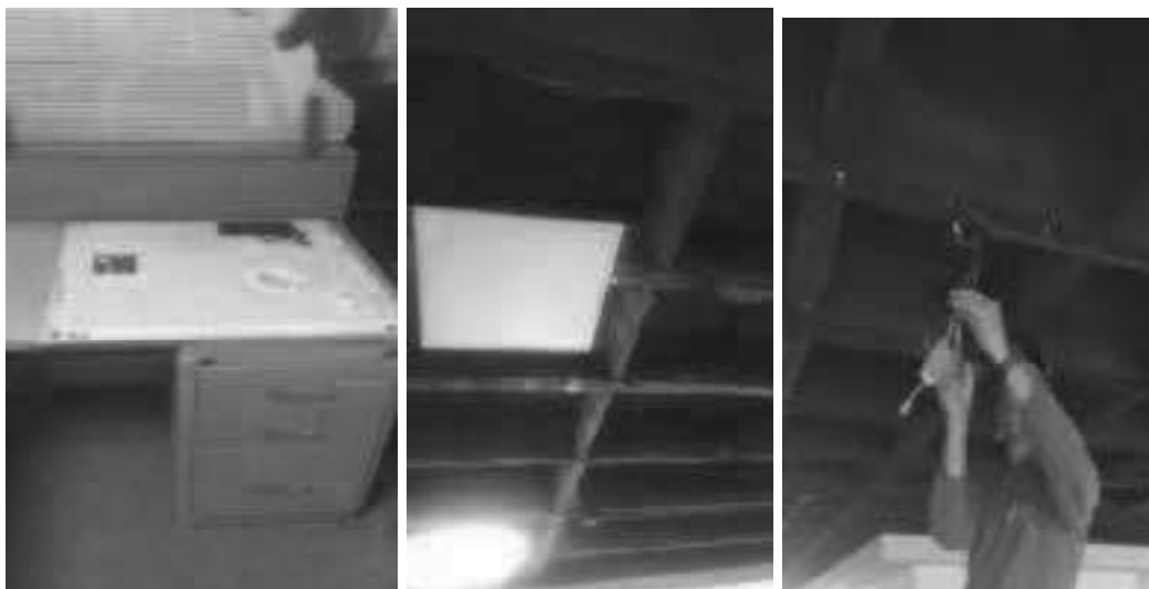
Cambio de luminaria 60x60 quemadas – 5to piso - Cooperación - Recepción
