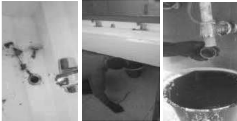
Limpiar desagües lavamanos MEN
