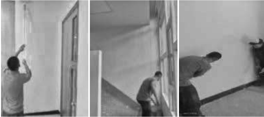
(Resanar, lijar y pintar pared) – PINTURA EDIFICIO – Piso N° 1 – Lado occidental – Sala 1-6.
