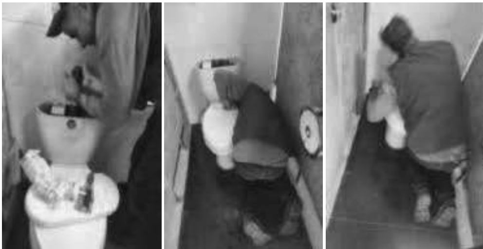
Cambio de cartucho kit flushmate sanitario (dañado) – Lado occidental - Piso N° 1 – Baño damas
