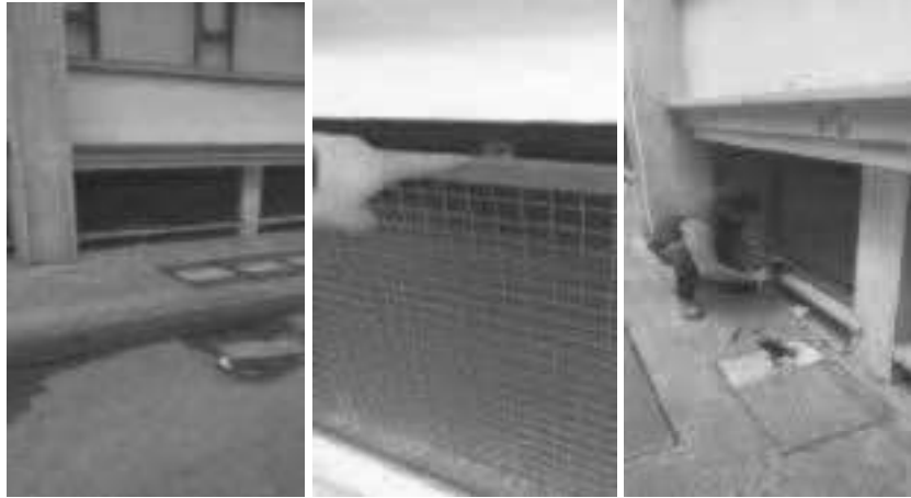
(Reja metálica) – Asegurar reja ventana fachada – Fachada calle N° 43 - Ventana bodega N° 21.
