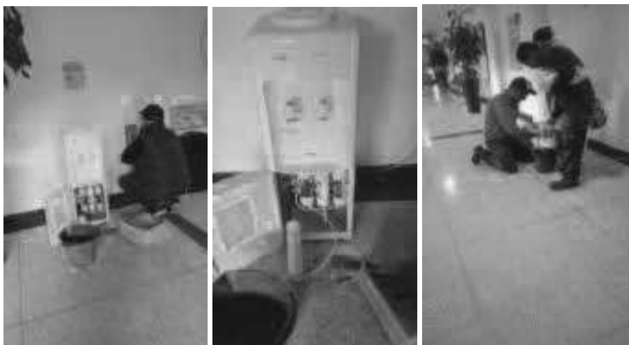
(Otros – Vidrio - Drywall) - Cambio de filtros de tres (3) dispensadores agua – Hall ascensores - Occidente piso N° 2 y piso N° 4 – Oriente piso N° 4.
