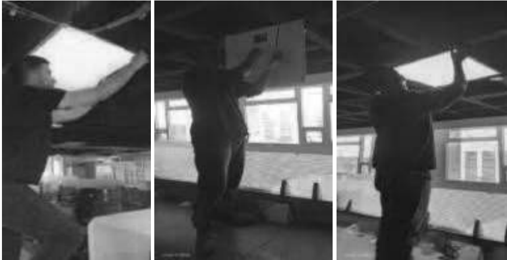
Cambio panel led 60x60 48w (quemado) – Lado oriente - Piso N° 5 – Planeación
