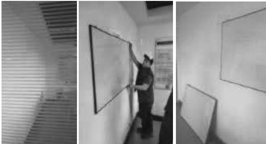
(Resanar y pintura pared) – Pintura edificio – Pintura - Resane y pintura de muro donde se desmonta tablero eléctrico - Piso N° 5 lado oriente - Innovación oficina.
