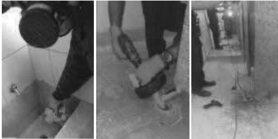
Destapar tubería sanitaria poceta y rejilla piso (guaya, kankro y agua presión) – Oriente - Piso N° 2 – Baño damas
