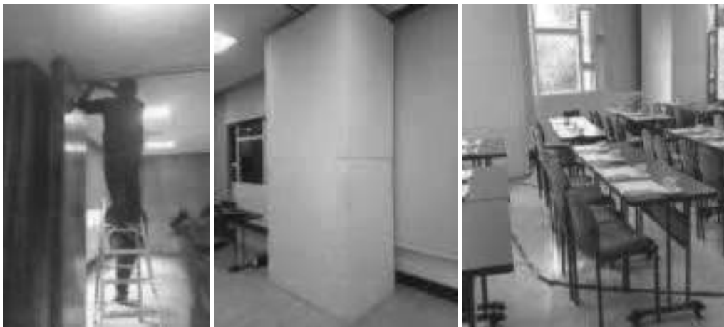
(Puertas madera división) – Abrir división de sala 2, 3, 4 Y 5 (mover biombos tapando las hojas divisiones) – 1er piso - Sala 1 a 5
