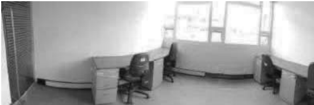
(Mobiliario - Adecuación) – Piso N° 3 – Despacho Vice – Asesores internos – Oficina N° 3, oficina N° 4 y sala de juntas. (Armar puestos y puntos eléctricos)
