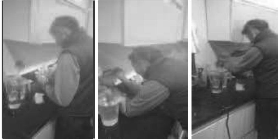
Cambiar toma eléctrica normal (quemada) – Piso N° 5 – occidente Despacho – cocina – punto greca
