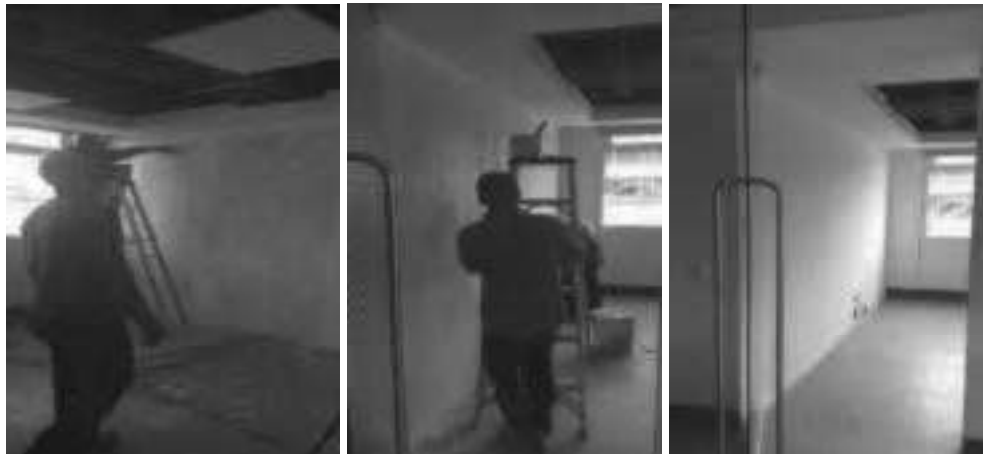
(Resanar, lijar y pintar pared) – PINTURA EDIFICIO (ADECUACION) – Piso N° 3 – Lado occidental – Despacho – Área asesores – Oficina N° 3 y oficina N° 4 - Muro división drywall
