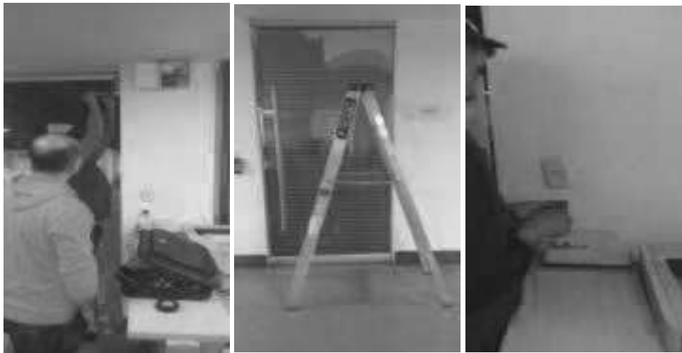
Revisar sistema automatización de puerta tesorería (imán dañado) – Piso N° 2 – Occidente – Tesorería – Puerta acceso (Imán dañado)
