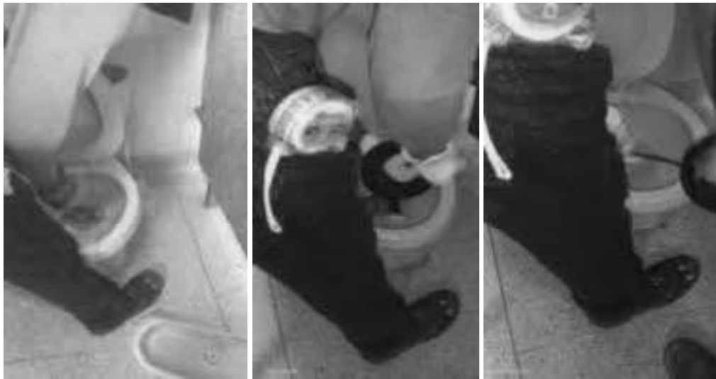
Destapar tubería sanitaria sanitario (guaya, kankro y agua a presión) – Occidente - Piso N° 3 – Baño damas
