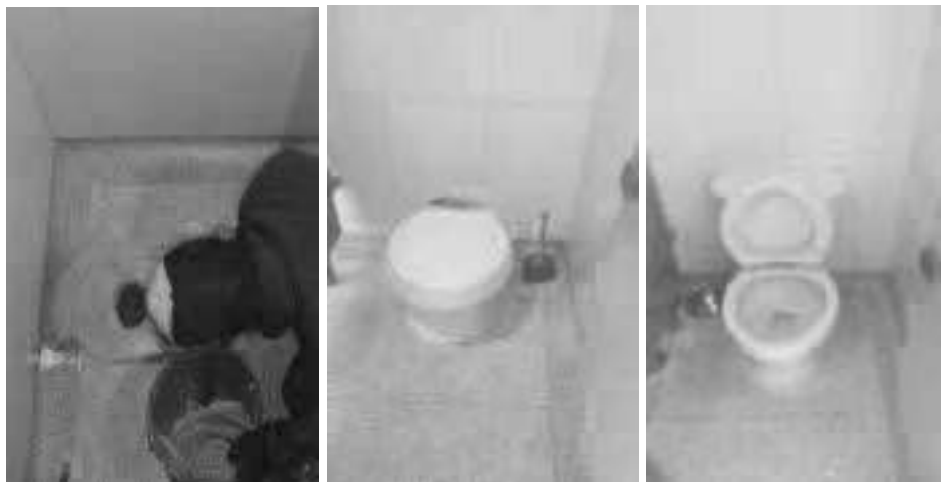
Instalar sanitario - 6to piso - Baños mujeres y hombres (3 sanitarios)
