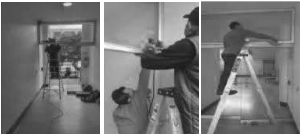
(Puerta vidrio) – Subir puerta y aplomar – Lado occidental – Puerta restringida parqueadero
