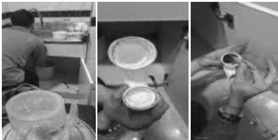
Destapar lavaplatos – lado occidente - piso N° 3 - cocina
