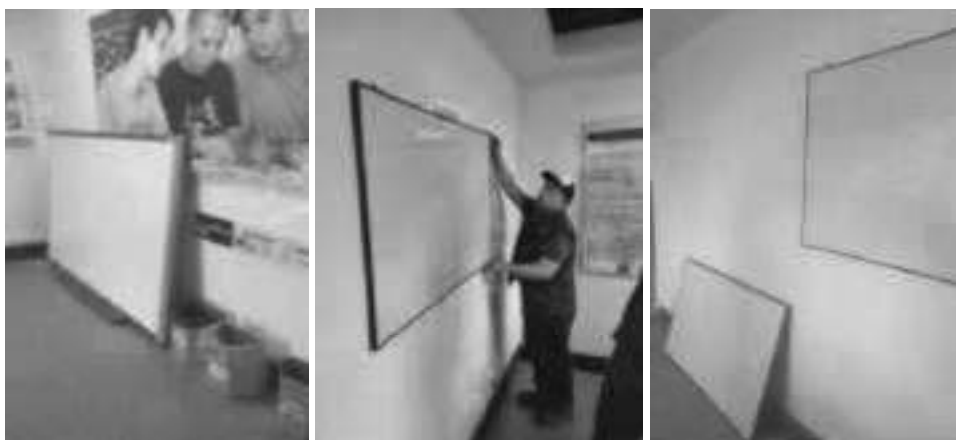
(Mobiliario – Desmontar tablero eléctrico e instalas dos (2) tableros acrílicos) – Piso N° 5 – Innovación – Oficina subdirección.
