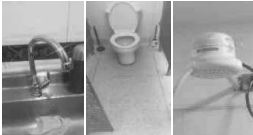
Inspección de todos los baños Ahorro Agua
