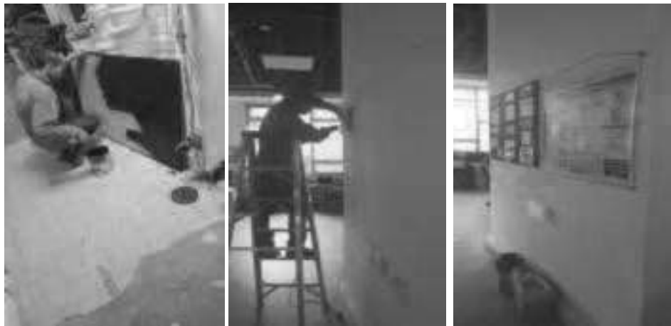
(Mobiliario – Instalar tablero y pintar en negro) – Piso N° 1 – Administrativa – Columna falsa centro
