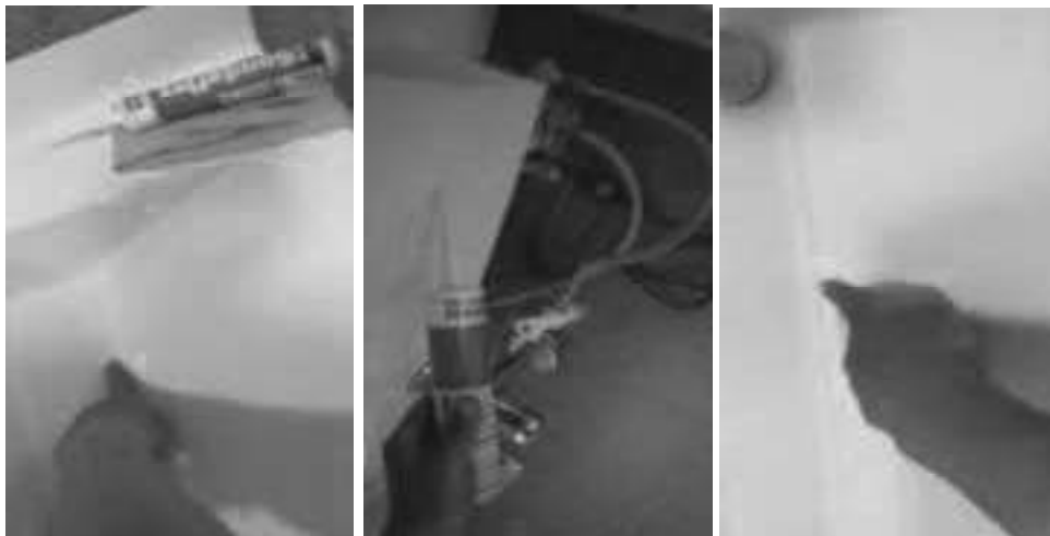
Reparar lavamanos (batería krion) fondo parte posterior aplicar soudaflex - Lado occidental - Piso N° 2 – Baño caballeros.
