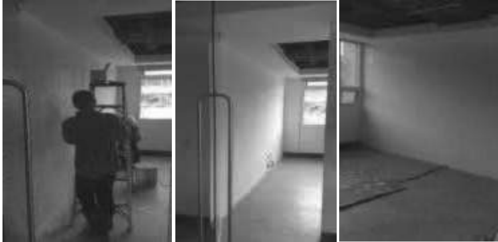
(Mobiliario - Adecuación) – Piso N° 3 – Despacho Vice – Asesores Internos – oficina N° 3, oficina N° 4 y sala de juntas. (pintura general oficinas)
