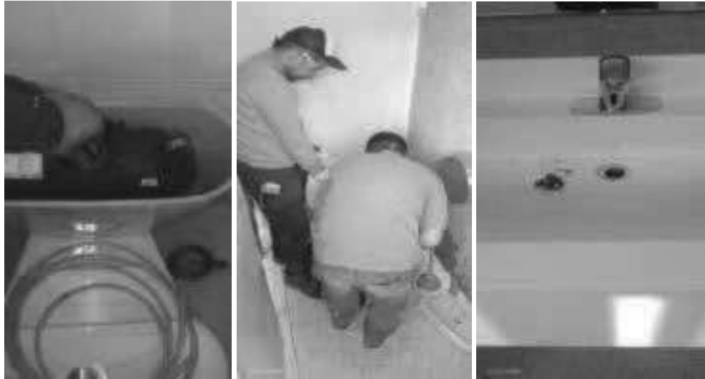
Inspección de todos los baños Ahorro Agua
