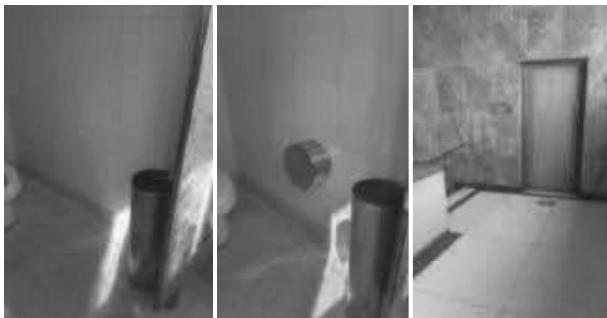
(Mobiliario – Instalar dispensador de papel sanitario) – Piso N° 4 – Occidente – Baño damas.
