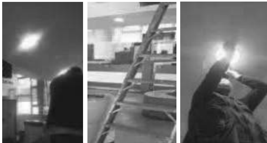
Cambiar panel led 18 W redondo (quemado) - piso N° 1 – Oriente – UAC – Ventanilla 3
