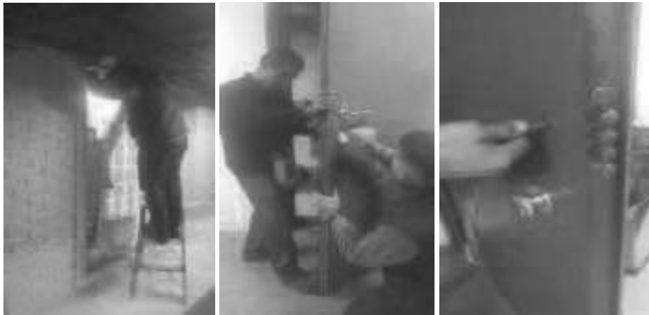
(Puerta metálica) – Abrir puerta metálica bodega N° 27 – Sótano
