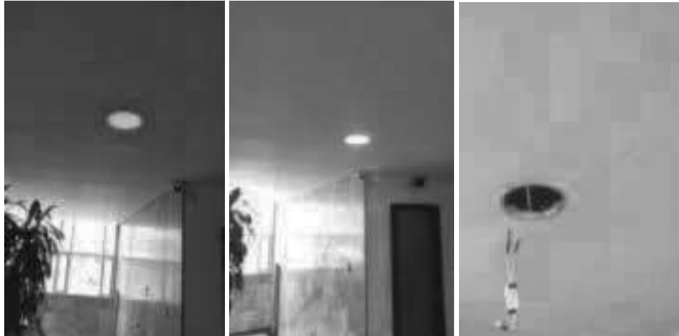
Cambiar panel led 18w redondo (quemado) – Lado occidental piso N°5 – Hall ascensores – Salida escalera
