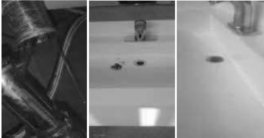
Limpiar desagües lavamanos MEN
