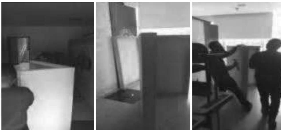
(Reparar Biombos) – Biombos de Salas – Piso N° 1 – Sala N° 6.
