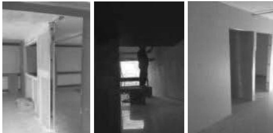
Armar oficinas en drywall, ventanas, puerta de vidrio y división vidrio sala juntas. – Edificio Ángel - piso N° 4 – Av. calle 19 con séptima.
