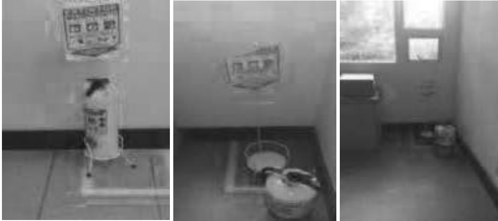
(Otros – Extintores – Señal) Cambio de señal informativa de base extintor – Piso N° 2 – Talento Humano.
