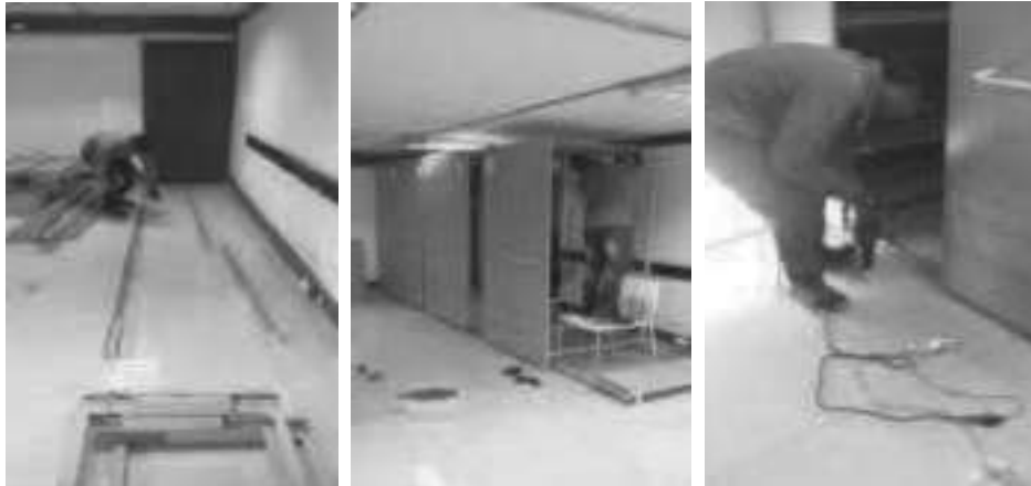
Oficina – armar archivador móvil en oficina CNA - Edificio Ángel - piso N° 4 – Av. calle 19 con séptima
