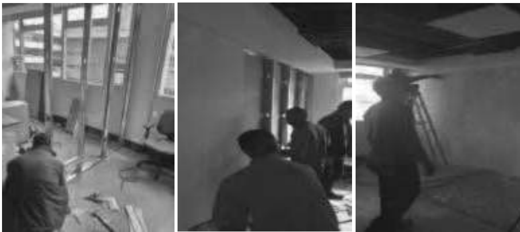
(Mobiliario - Adecuación) – Piso N° 3 – Despacho Vice – Asesores internos – Oficina N° 3, oficina N° 4 y sala de juntas. (Construir muro drywall)
