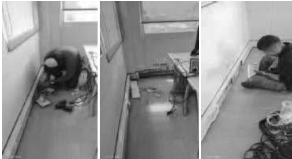
Reubicar puesto de trabajo con sus respectivos puntos eléctricos y eliminar superficie de dos (2), puestos Despacho Ministra - Asesores Internos Oficina 2
