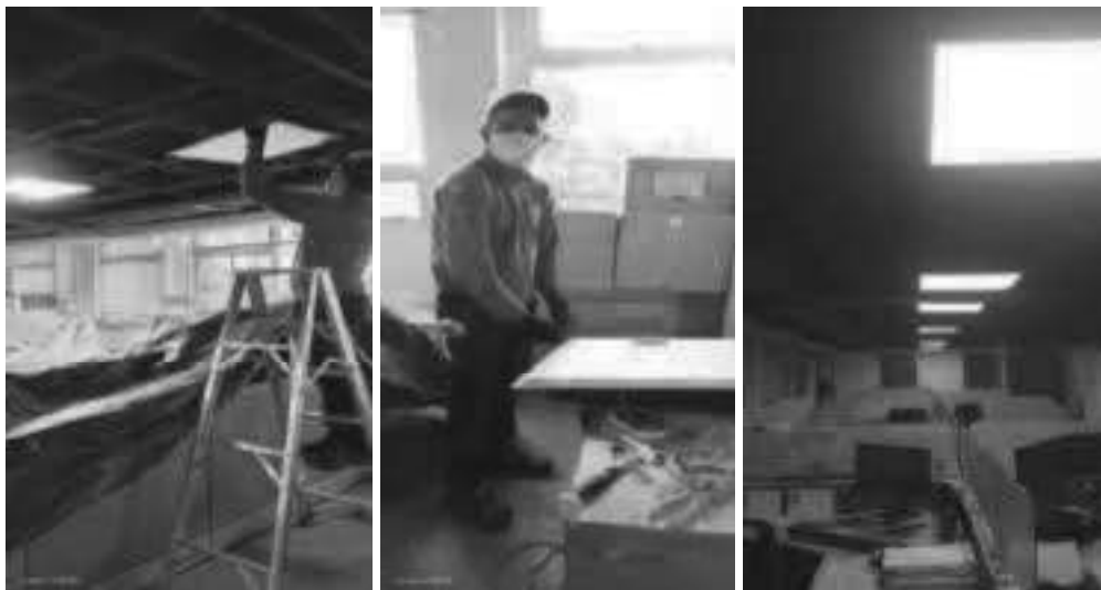
Instalar nueva luminaria panel 60x60 y alinear 5 luminarias existentes 2o piso - Talento Humanó - Lado fachada parqueadero
