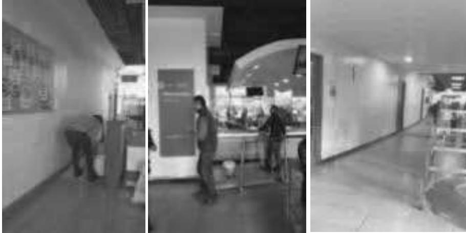
(Pintura) – Edificio – Resanar, lijar y pintar pared - 1er piso - Desde costado oriental UAC al occidental, entrada Administrativa.
