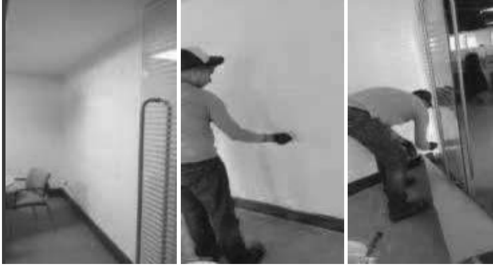
Pintura – Edificio – Resanar, lijar y pintar - 2o piso - Talento Humano - Oficina subdirección (muro tablero)
