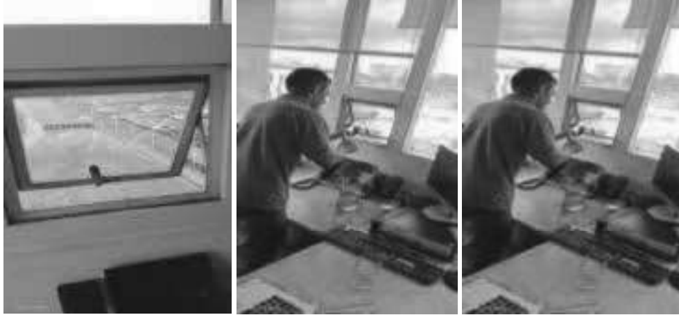
(Otros – Vidrio - Pirlan) Cambio de vidrio en ventana pequeña – Piso N° 5 – Jurídica – Oficina subdirección
