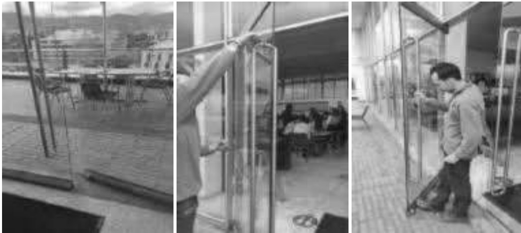
(Puerta vidrio) – Subir puerta, instalar manija y aplomar – Terraza – Cafetería – Acceso terraza carrera 57.
