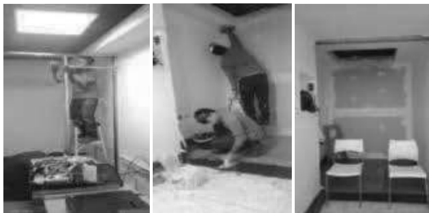
(Mobiliario - Adecuación) – Planeación y sindicato nuevo muro drywall y resane de piso granito
