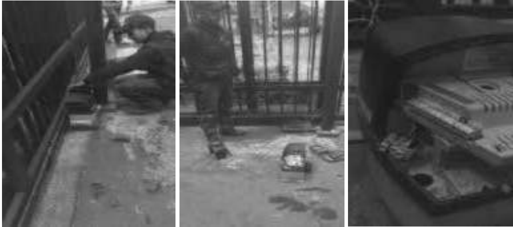
Parqueadero – Portería carrera 57 – Mantenimiento correctivo retiro de motor del sistema automatizado del portón.
