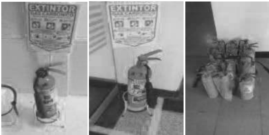
Otros – Vidrio – Cambio de 16 extintores de solkaflam por 16 extintores de gas carbónico CO2
