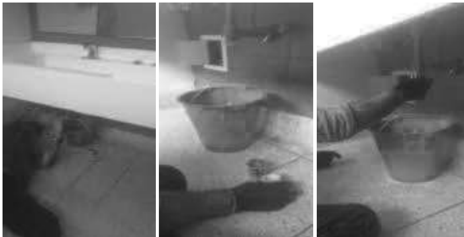
Limpiar desagües lavamanos MEN
