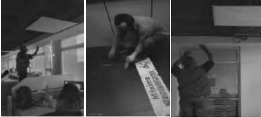
(Otros – Vidrio - Pirlan) - Retirar cintas de techo MEN y cintas amarillas entradas ascensores del piso.
