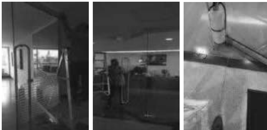
(Reparar puerta entrada) – piso 4- despacho VICE
