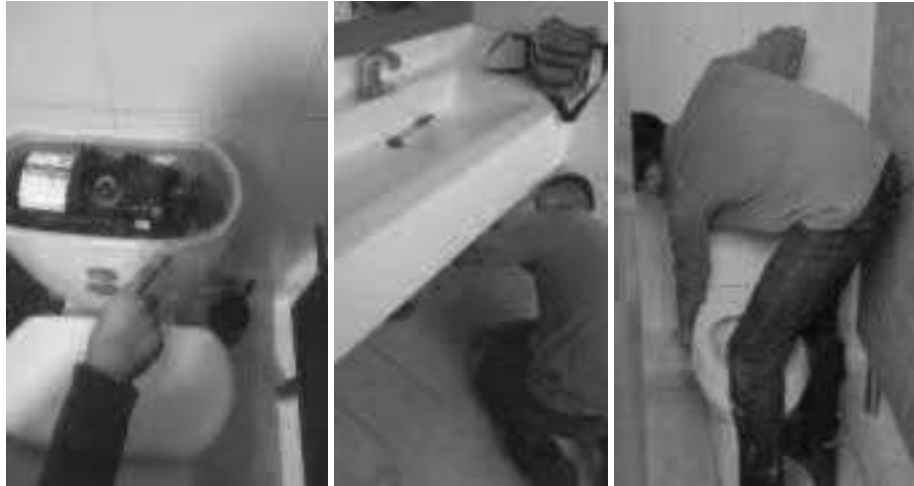
Inspección de todos los baños Ahorro Agua
