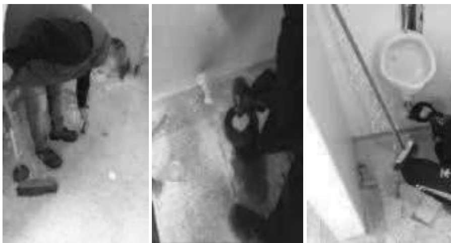
Destapar tubería sanitaria (guaya, kankro y agua a presión) – Terraza – Baño damas y caballeros
