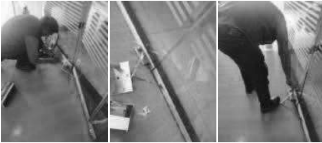
(Puerta vidrio) – Subir puerta y aplomar – Terraza – Puerta gimnasio.
