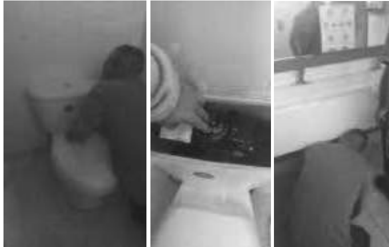
Inspección de todos los baños Ahorro Agua
