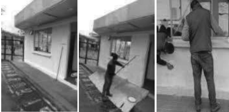
(Pintura) – Edificio – Resanar, lijar y pintar pared - Parqueadero - Portería - Fachada principal.
