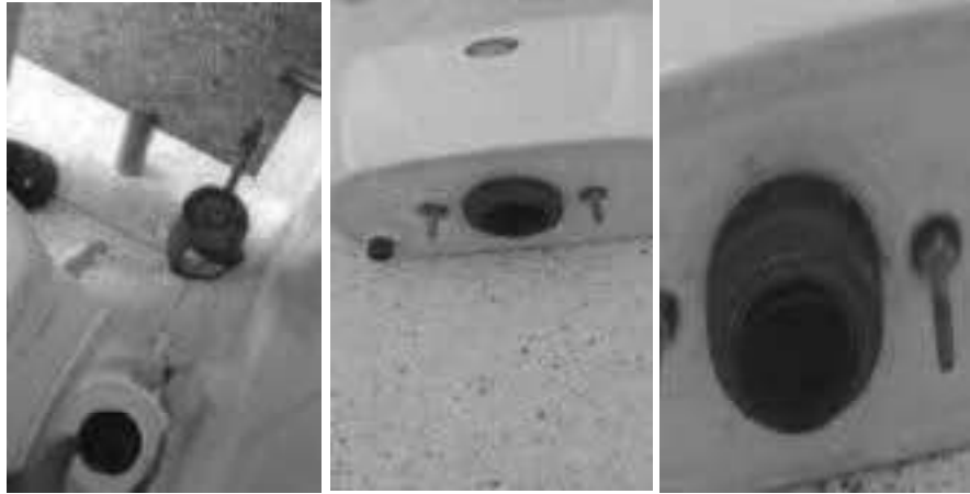
Cambio goma central tanque sanitario – Costado oriental - Piso N° 4 baño damas
