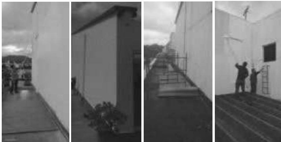
(Pintura) – Edificio – Resanar, lijar y pintar - Instalar guarda escoba muro exterior cafetería - 6to piso - Fachada exterior cafetería – Parqueadero, carrera 57 y calle 43
