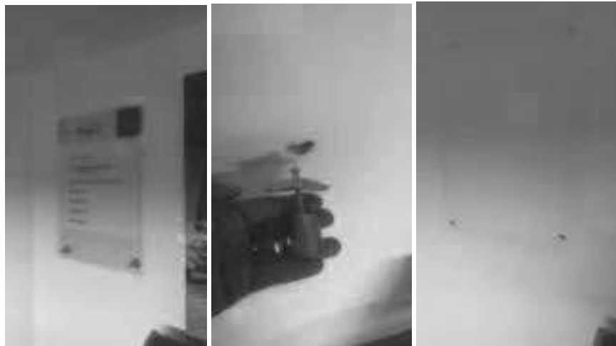
(Otros – Vidrio - Drywall) - Instalar tablero informativo vidrio hall ascensores – 2do piso hall ascensores costado oriental.
