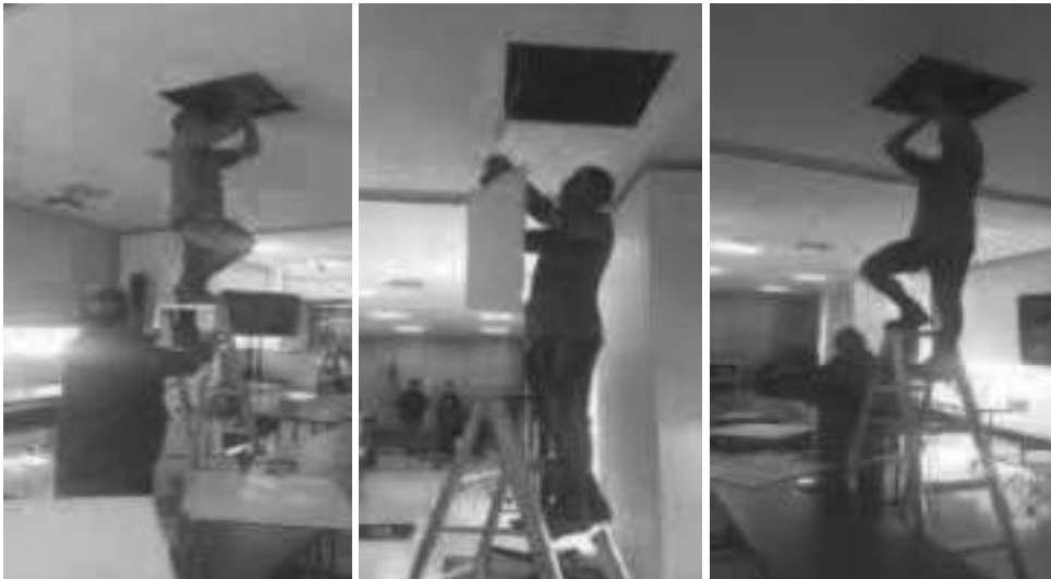
Cambio de 4 luminarias 60x60 quemadas -1er piso - Sala N° 2 y Sala N° 3
