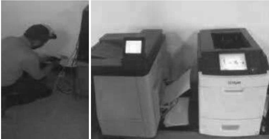
No funciona circuito de impresoras (cambio de tomacorriente circuito normal) – 4to piso - Occidental - Fomento para la educación superior (área impresora)
