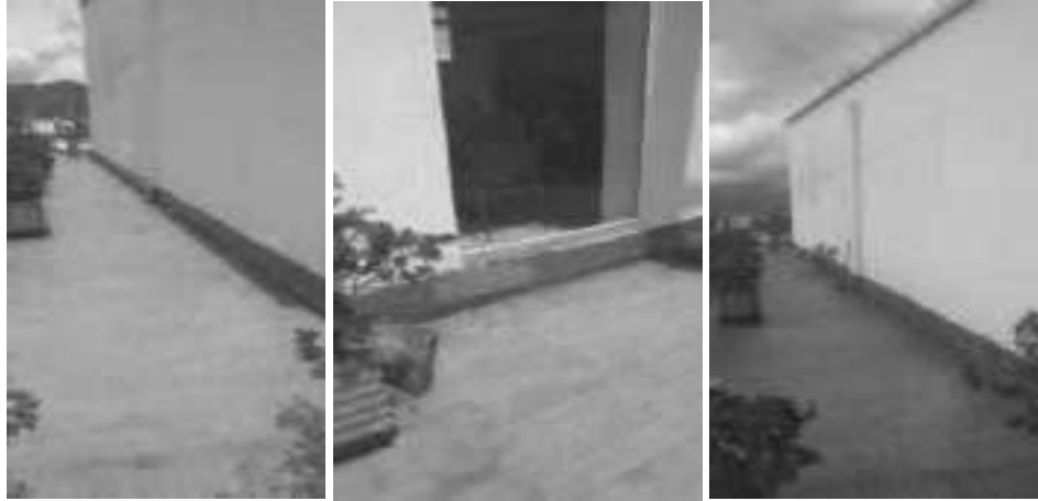
(ALBAÑILERIA) – Edificio – Instalar guarda escoba muro exterior cafetería - Piso N° 6 – Terraza – Fachada parqueadero.
