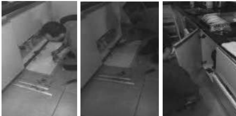
Reparar puerta de mesón lavaplatos – piso 5 - despacho Ministra - cocina
