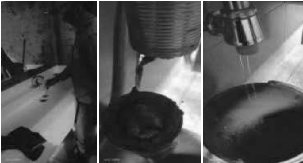
Limpiar desagües lavamanos MEN
