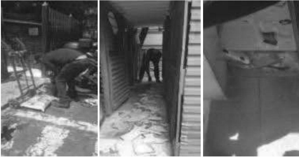
Albañilería – Edificio – Remover pegacor viejo en baldosa piso e instalar baldosa piso - Parqueadero - Portería - Área caninos
