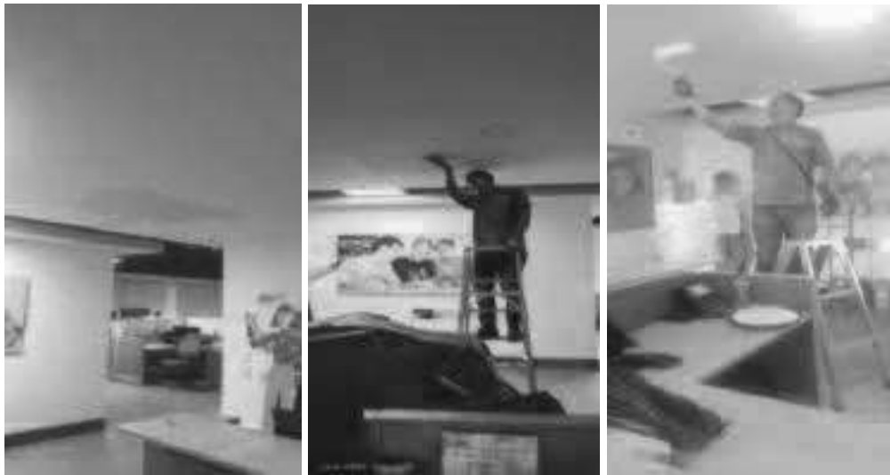
Pintura – Edificio – Resanar, lijar y pintar - Techo falso - 5to piso - Innovación - Recepción
