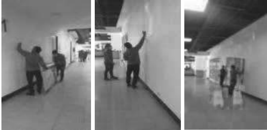
Montar cuadros y avisos informativos pasillo piso 1 – pasillo occidente
