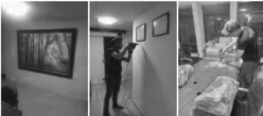
(Mobiliario) – Instalar cuadros y realizar perforaciones a superficie de puesto trabajo – Edificio ángel - Piso 4 - Área grande.
