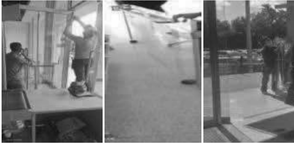
Puerta vidrio – Pega puerta al piso – Subir puerta vidrio – 1er Piso - Entrada principal recepción.
