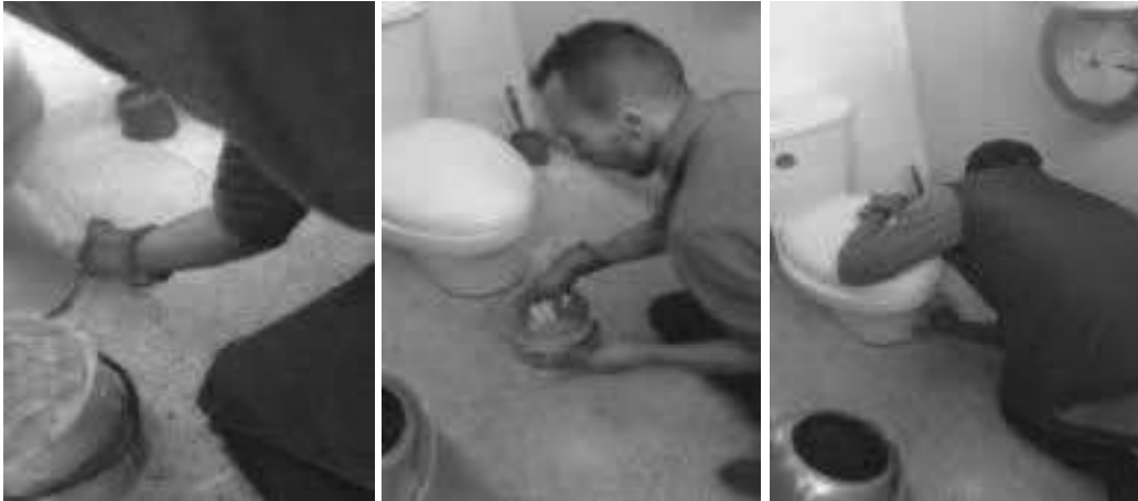
(ALBAÑILERIA) – Edificio – Filtra base sanitario (emboquillar sanitario) - Piso N° 2 - Oriente - Baño damas.
