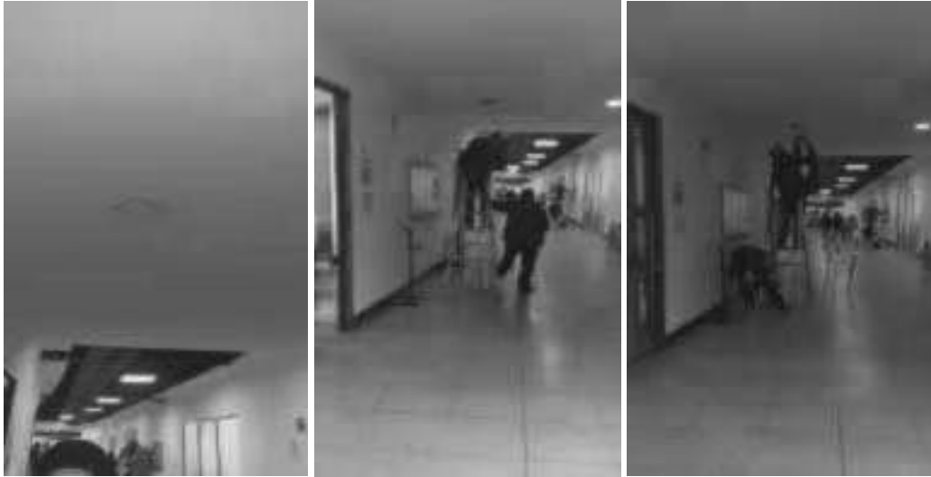
Cambiar panel led 12w redondo (quemado) – Piso N° 1 – Occidente y oriente – Hall ascensor – Pasillo
