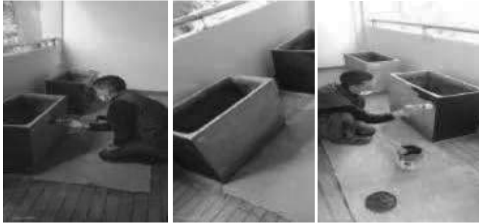
(Resanar, lijar y pintar materas) – PINTURA EDIFICIO – Pintar tres (3) materas – Piso N° 2 – Secretaría General - Terraza.
