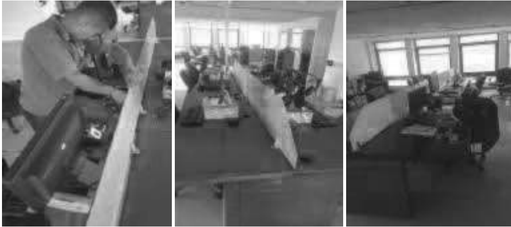
Mobiliario – instalar 7 vidrios división puesto trabajo – edificio ángel - piso 4 - área grande.
