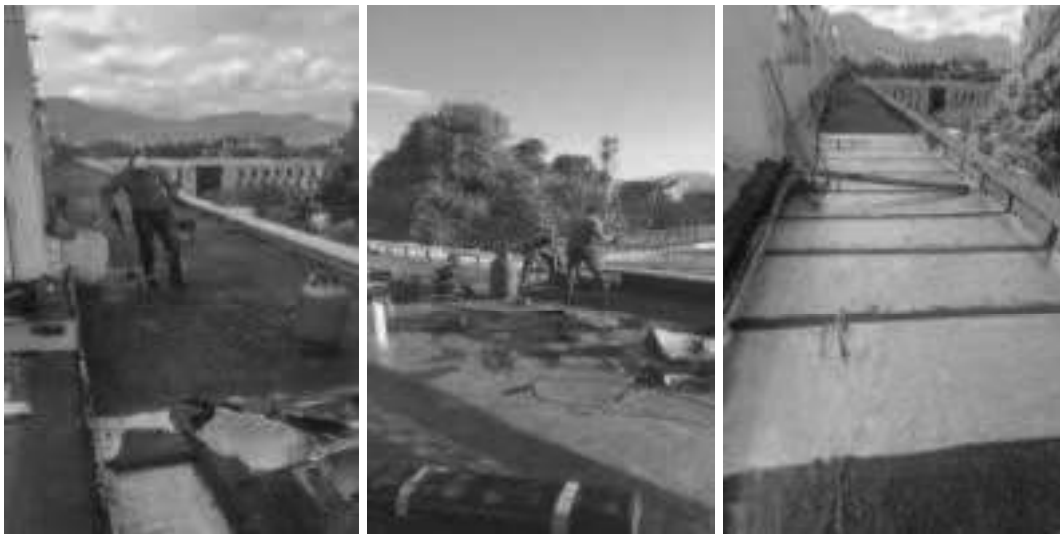
Impermeabilización – Edificio – Cambio de manto asfáltico (foil de aluminio) - Terraza piso 6 área de techo de Cooperación Internacional
