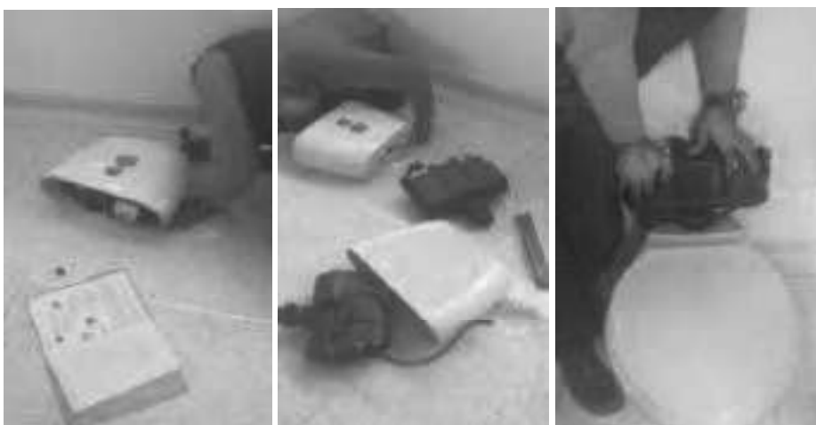
Reparar FLUSHMATE sanitario - Lado occidental - Piso N° 1 – Baño damas – Lado oriental – Piso N° 5 – Baño damas
