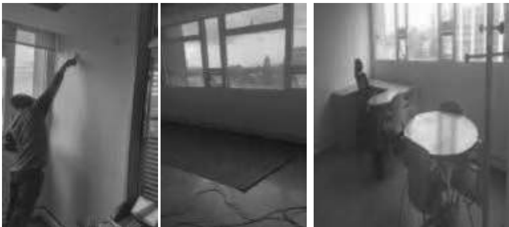
(Resanar, lijar y pintar pared) – PINTURA EDIFICIO (ADECUACION) – Piso N° 5 – Lado occidental – Comunicaciones – Oficina Dirección
