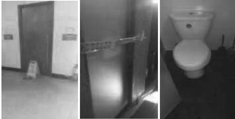
Cambio de goma central tanque sanitario – Lado occidental - Piso N° 1 – Baño damas
