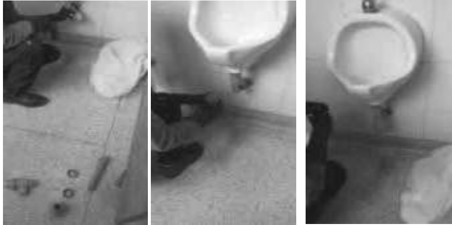
Cambio desagüe de orinal (rosca dañada) – lado oriental - piso N° 2 – baño caballeros
