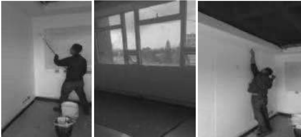
(resanar, lijar y pintar pared) – Pintura edificio – Piso N° 4 – Lado oriental – Primera Infancia – Oficina Dirección
