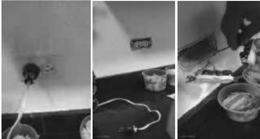
Cambio de toma eléctrica normal – Piso N°5 – Despacho Ministra – Cocina
