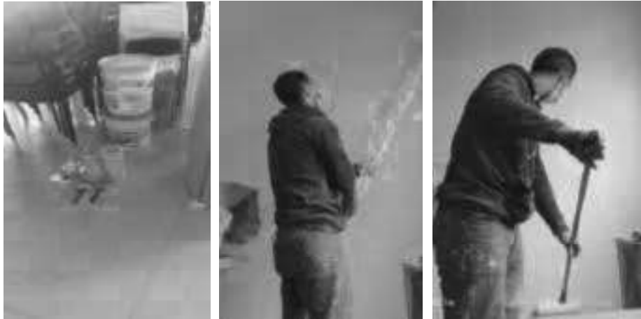
Resanar, lijar y pintar pared – pintura edificio – Edificio Ángel - piso N° 4 – muros y paredes existentes.
