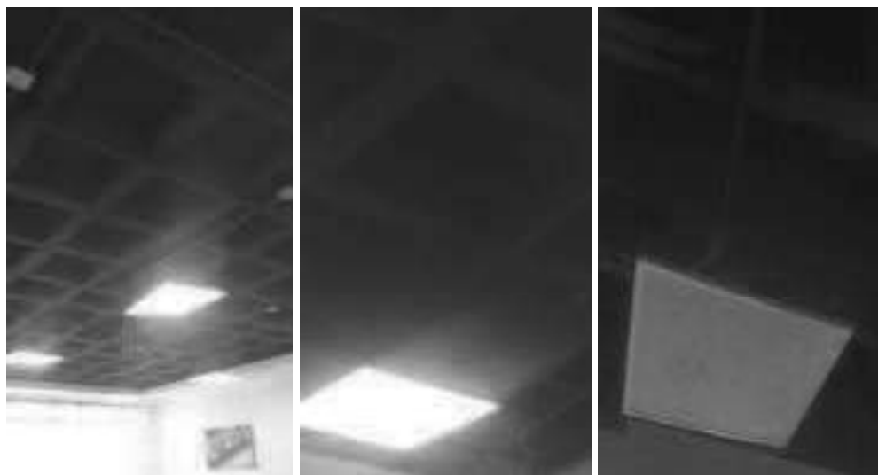
Cambio de chazos a dos (2) luminaria 60x60 sueltas – 1er piso - administrativa
