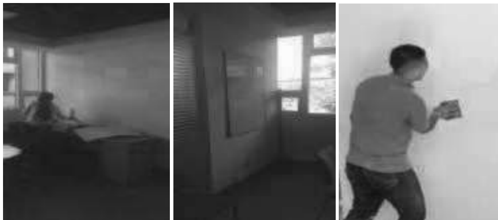
(Resanar, lijar y pintar pared) – PINTURA EDIFICIO – Talento Humano – Oficina dirección - Piso N° 2 – Lado oriental.
