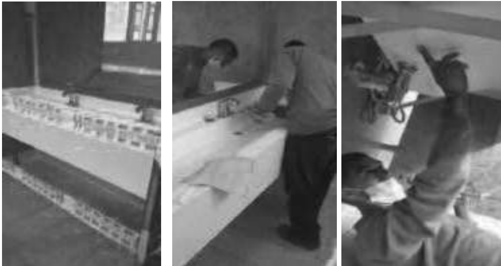
Reparar lavamanos (batería krion) fondo parte posterior Aplicar soudaflex - Lado occidental - Piso N° 3 – Baño damas
