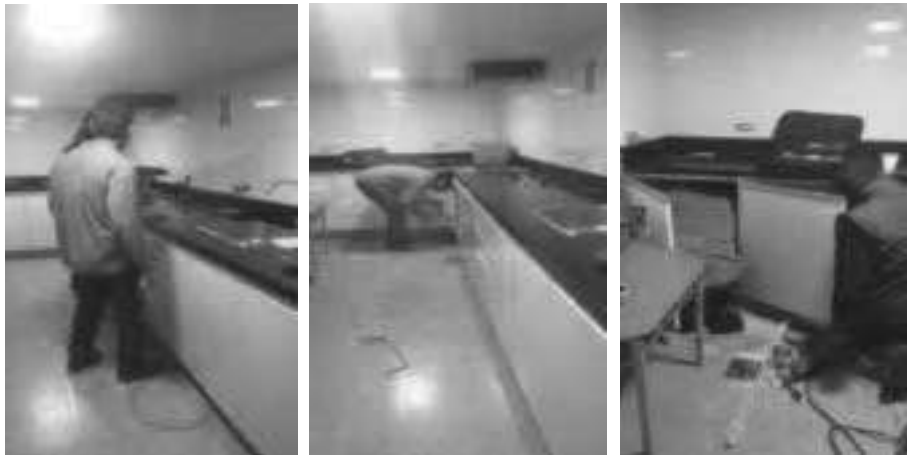
Circuito eléctrico nuevo desde tablero hasta punto eléctrico – Piso N° 1 – Occidental – Cocina – Punto greca doble
