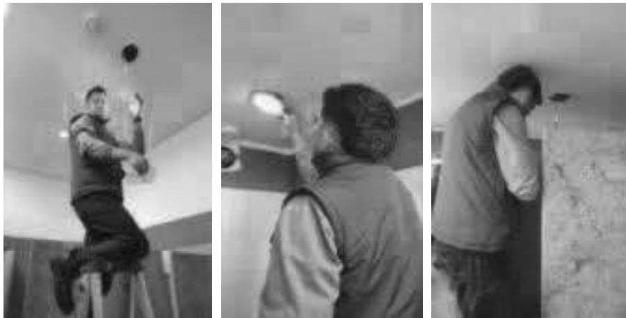
Cambio panel led 12 W redonda baños – Lado oriente (piso N° 2 damas 2 und + piso N° 3 damas y caballeros 4 und + piso N° 4 damas y caballeros 4 und) – lado occidental (piso N° 2 damas 1 und + piso N° 3 baño damas 1 und)
