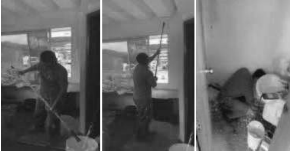
Pintura – Edificio – Resanar, lijar y pintar - Parqueadero - Portería - Área interna (oficina y baño)
