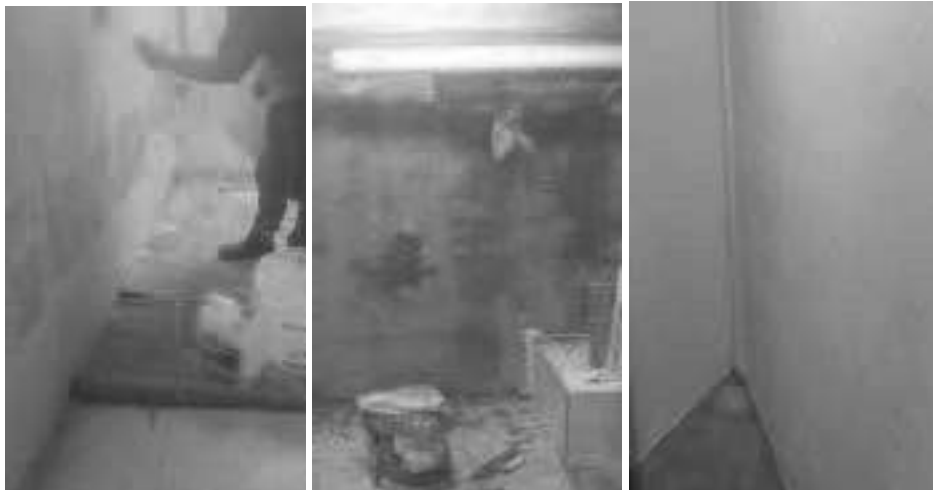
(ALBAÑILERIA) – Pintura, albañilería e impermeabilización pintura edificio – Aplicar mortero reforzado, resane, estuco y pintura - Sótano occidente - Bodega N° 4 (deposito).
