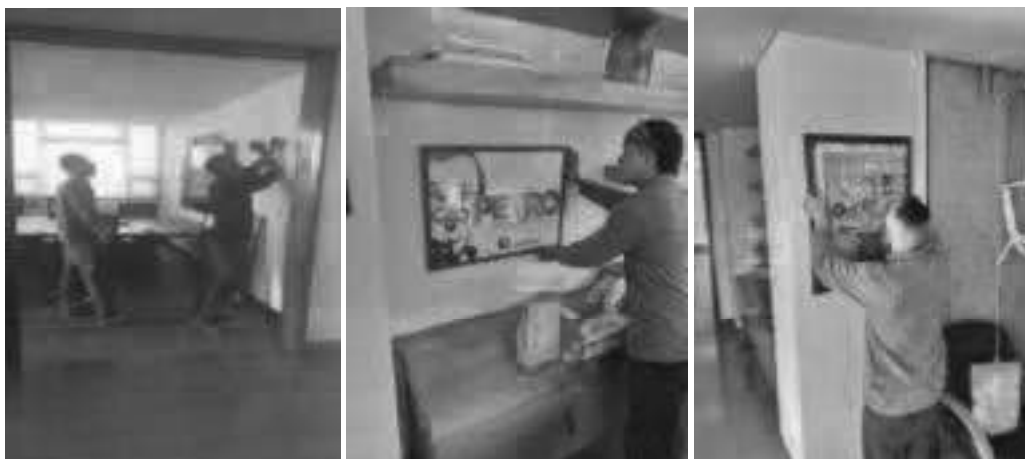
(Mobiliario) – Instalar cuadros despacho vice - Piso N° 3.
