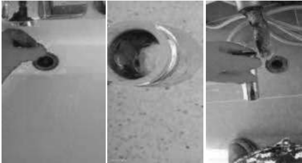
Limpiar desagües lavamanos MEN
