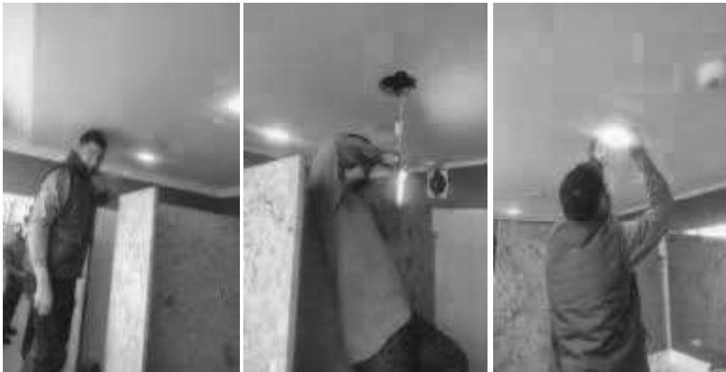
Cambio panel led 12w redonda baños – Lado oriente (piso N° 2 damas 1 y caballeros 1 + piso N° 3 damas 1) – Lado occidental (piso N° 2 damas 4 y caballeros 2)
