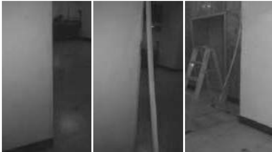
(Albañilería) – Edificio – Cambio de esquinero PVC - 1er piso - Esquina ascensor oriental.
