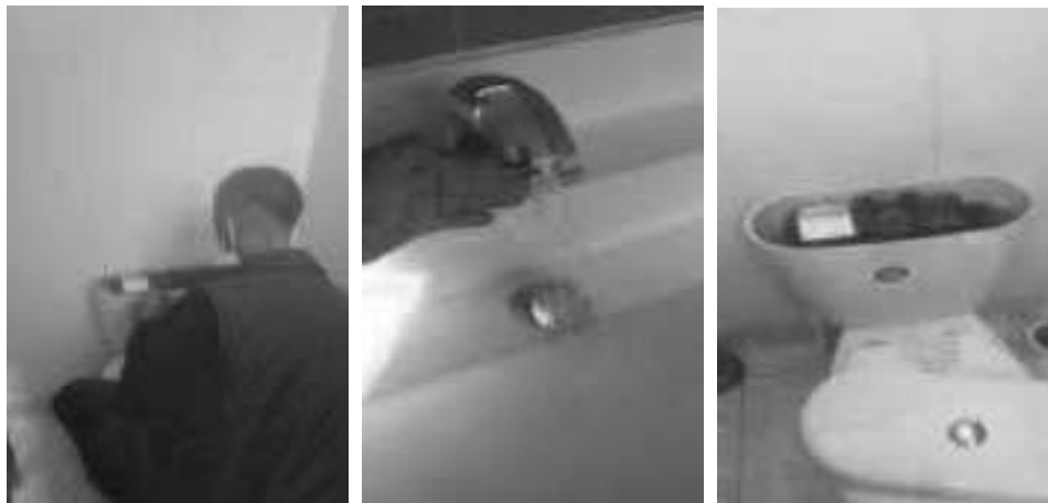
Inspección de todos los baños ahorro agua
