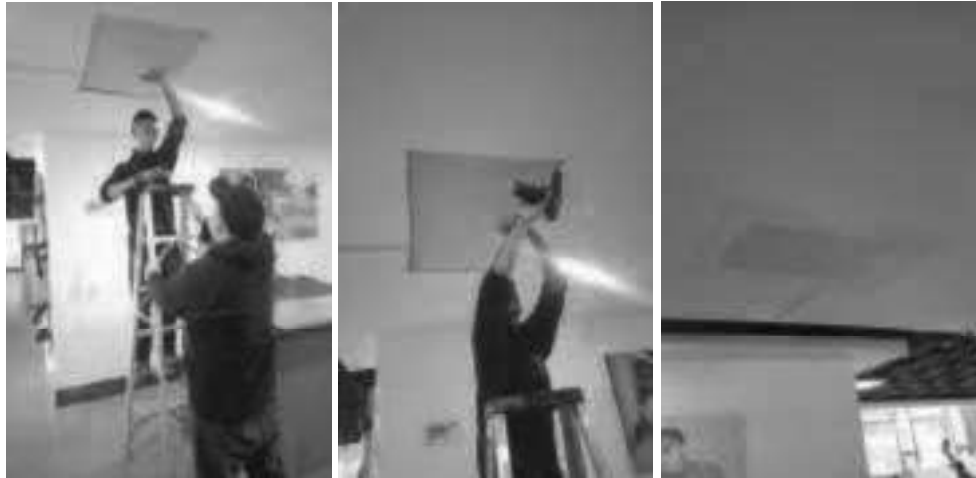
(Otros – Vidrio - Drywall) - Realizar caja de inspección - 5to piso - Innovación.
