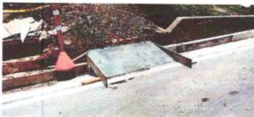
Rampa de acceso
