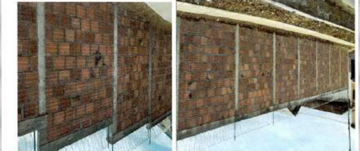
Mampostería en ladrillo H15, (incluye anclajes)
