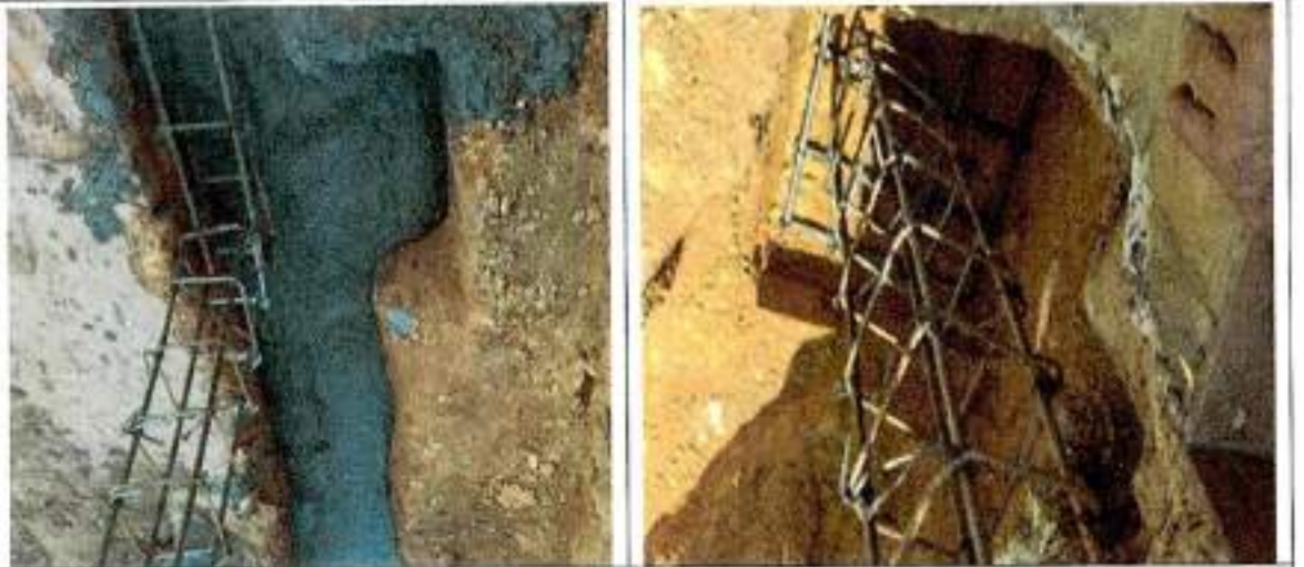
Zapata en concreto (0,3x0,4x0,4) de 3000 psi, incluye acero pdr 60 y excavacion
