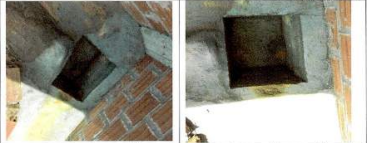
Caja de inspección de aguas lluvias, ladrillo temosa (1.00x0.80), profundidad 0.70m
