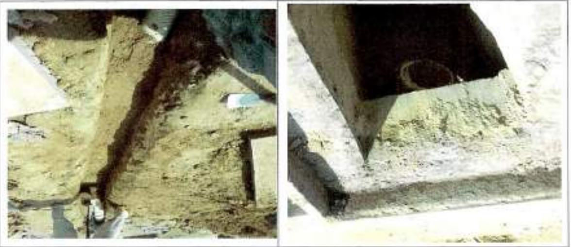
Suministro e instalación de tubería de 8" Novafort, para conexión a sumidero, incluye (excavación y relleno)
