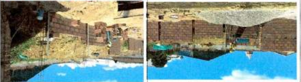
Mampostería en ladrillo H15, (incluye anclajes)
