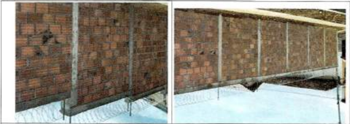
Suministro e instalación Concertina en acero galvanizado 30 cm de diámetro (incluye soportes y accesorios)
