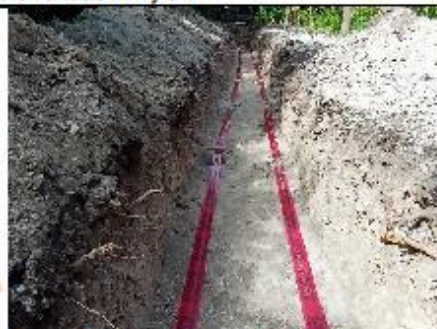
Canalización de redes subterráneas MT y BT
