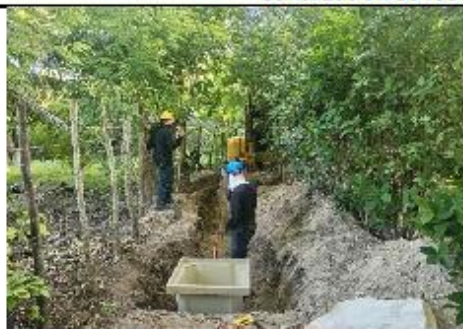
Canalización de redes subterráneas MT y BT
