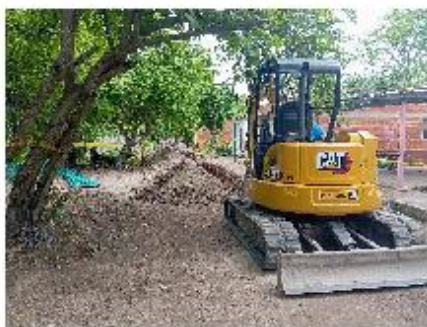
Canalización de redes subterráneas MT y BT
