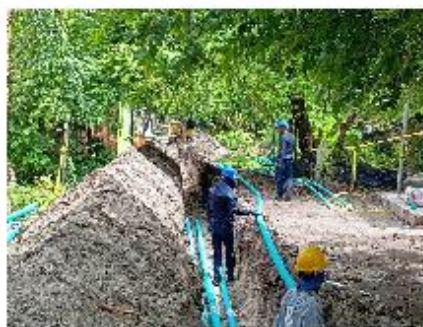
Canalización de redes subterráneas MT y BT
