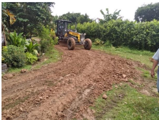
Conformación de calles con material de roca muerta
