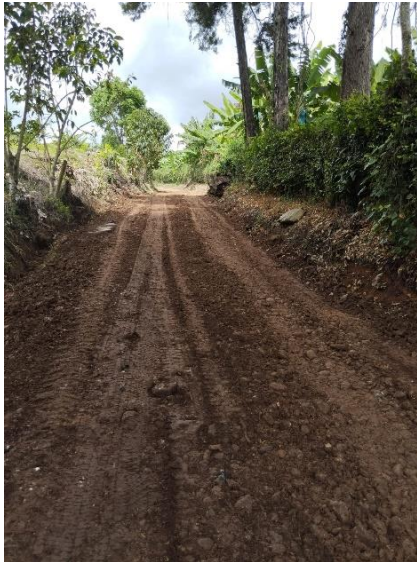
Conformación una cuadra con material de roca muerta, Villas del Café
