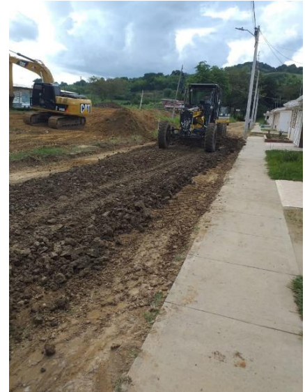
Conformación una cuadra con material de roca muerta, Villas del Café
