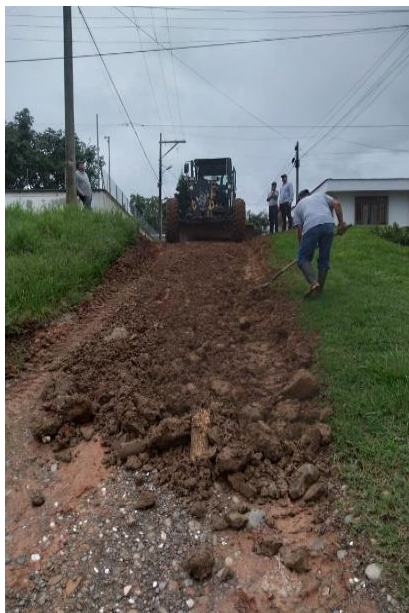
Conformación con roca muerta calle detrás del hospital
