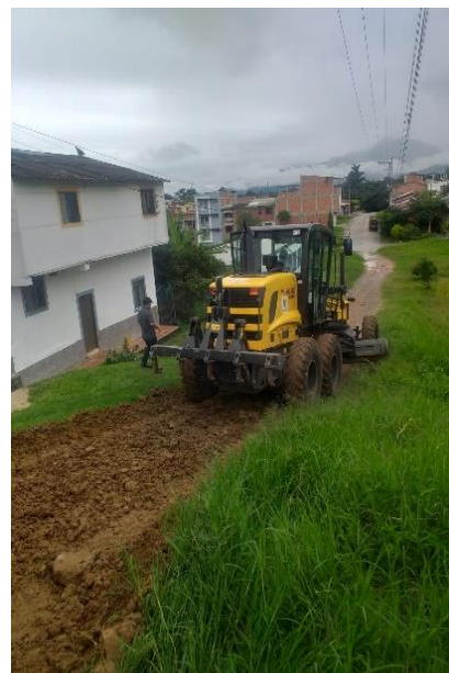
Conformación con roca muerta calle detrás del hospital
