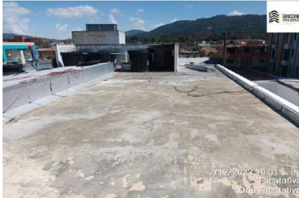
Re nivelación placa de terraza con mortero
