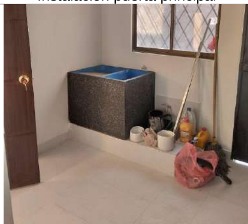
Instalacion de lavadero prefabricado
