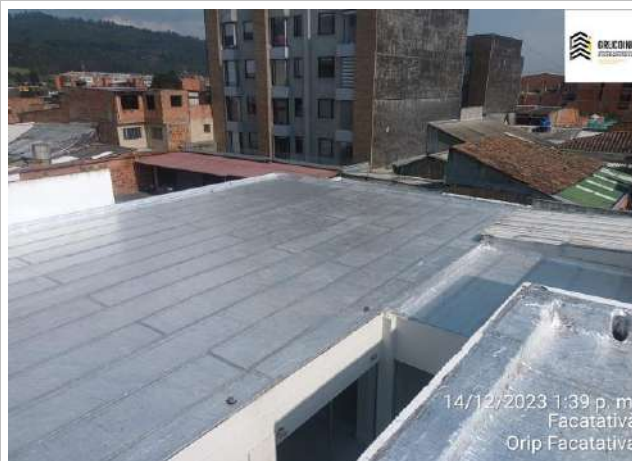
Aplicación de manto asfáltico
