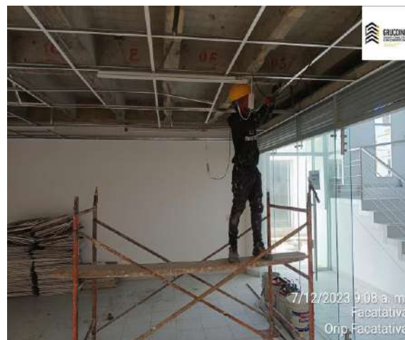
instalacion de cielo raso en area de atencion al publico
