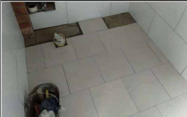
INSTALACIÓN DE BALDOSÍN PISO Y ENBOQUILLADO BAÑO DISCAPACITADOS
