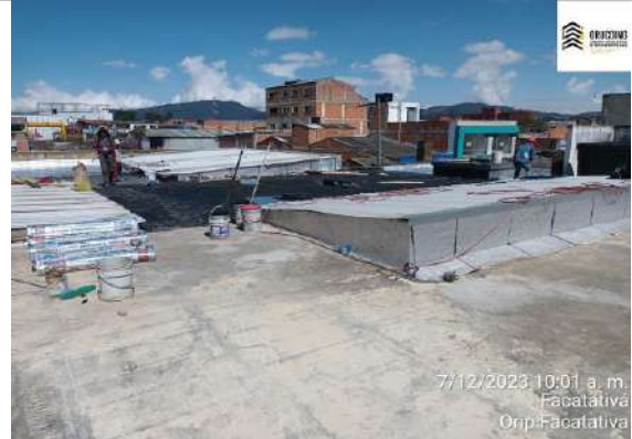
Re nivelacion placa de terraza con mortero
