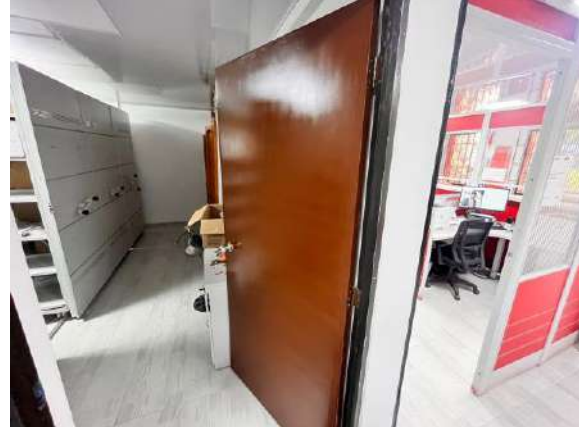
Mantenimiento puerta de acceso a archivo rodante
