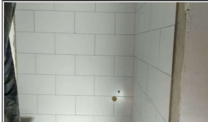
INSTALACIÓN DE BALDOSÍN MUROS Y ENBOQUILLADO BAÑO DISCAPACITADOS
