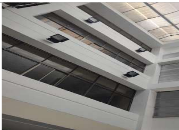
Pintura – área de atención al cliente
