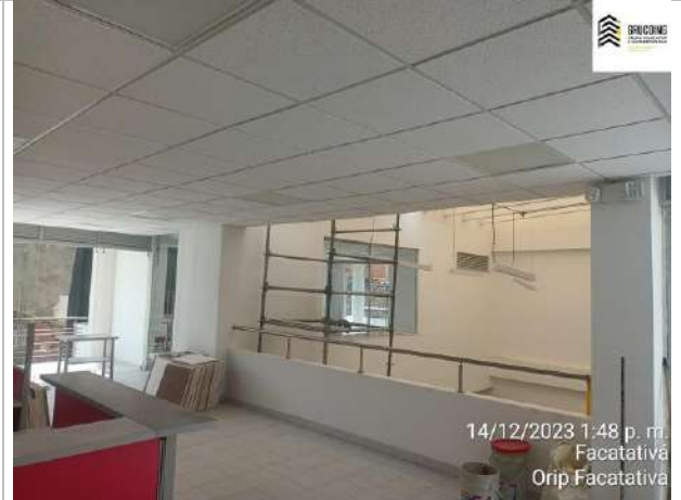
Finalización de instalación cielo raso en 2do piso
