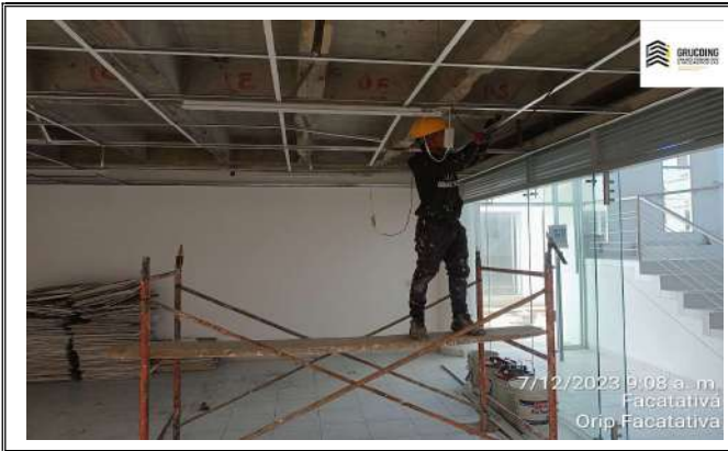
instalacion de cielo raso en area deatencion al publico
