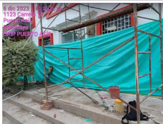
Instalación de polisombra verde – acceso principal
