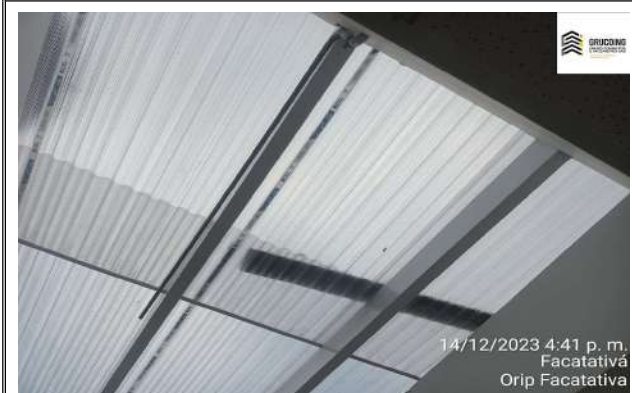
instalacion de cubierta traslucida
