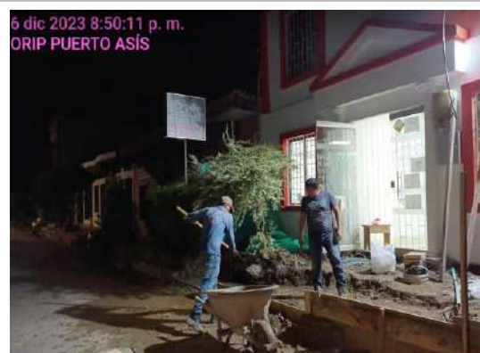
Proceso de armado rampa de acceso – acceso principal
