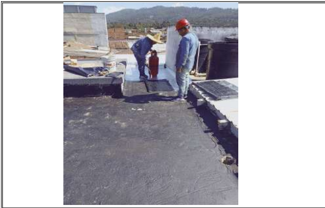
aplicacion de manto asfaltico
