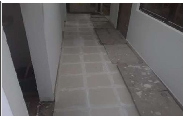
INSTALACIÓN DE BALDOSÍN Y ENBOQUILLADO
