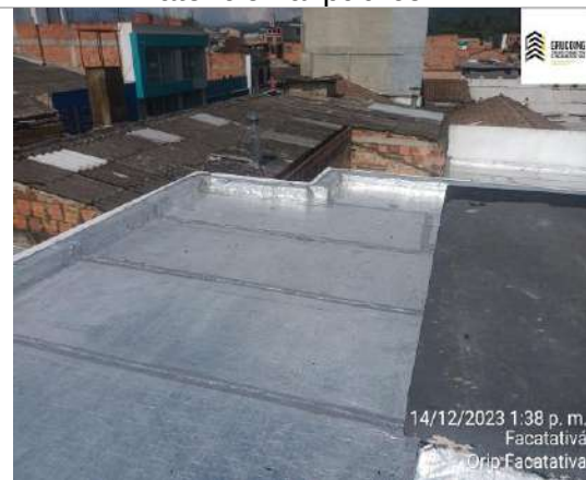
Aplicación de manto asfaltico
