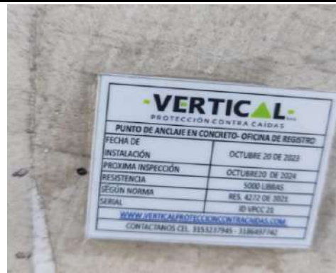
señalización de anclajes
