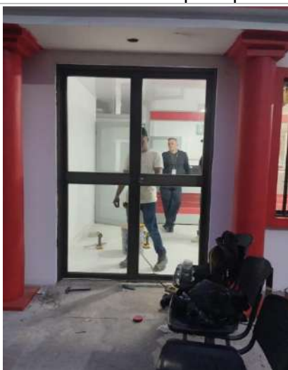
Instalacion puerta principal
