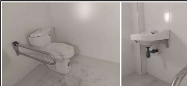
Instalacion de enchape e instalacion accesorios del baño para Discapacitados
