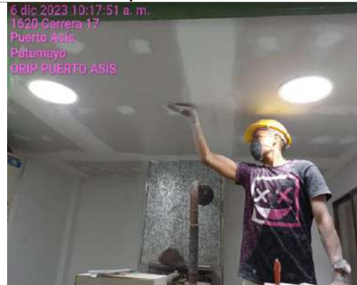
Instalación de cielo raso en drywall
