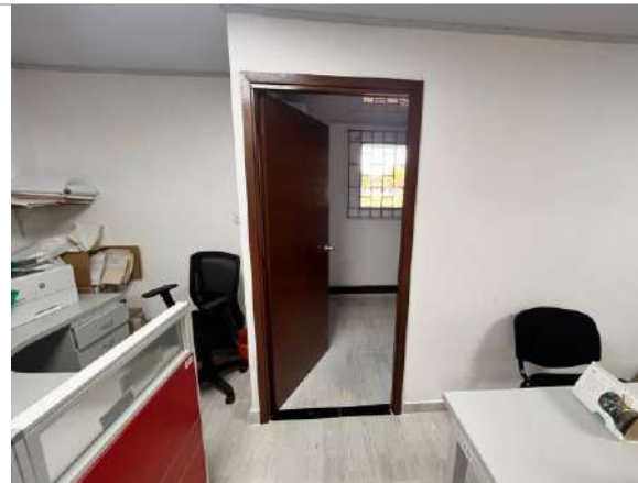
Mantenimiento de puerta cuarto rack
