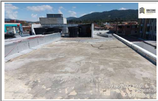
Renivelacion placa de terraza con mortero
