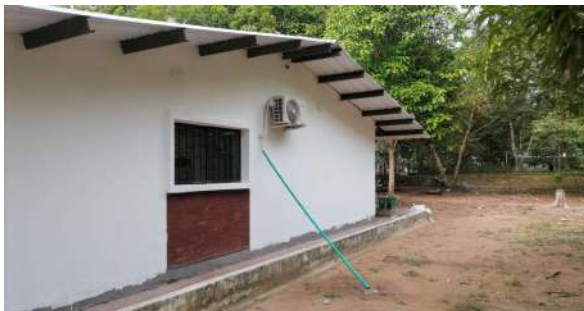
instalacion de cubierta
