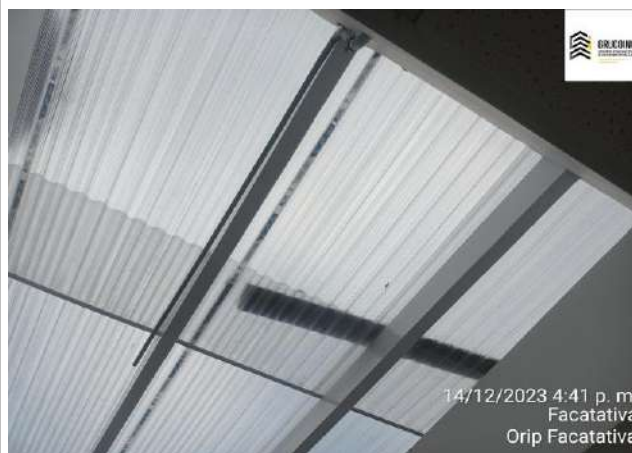
Instalación de cubierta traslúcida
