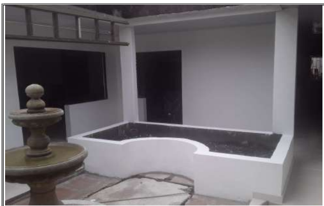
TERMINADOS AREA CENTRAL DE OFICINA SNR
