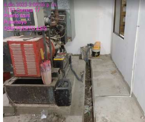
Retiro de material sobrante en cuarto de planta eléctrica
