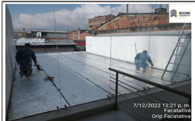
aplicación de pintura bituminosa
