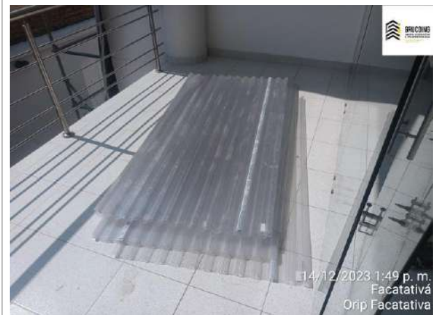
cubierta traslúcida sin instalar
