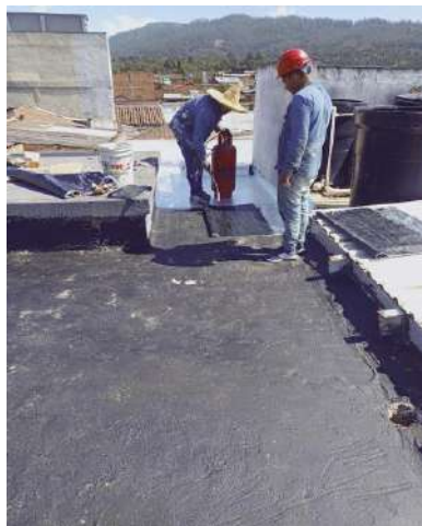
Aplicación de manto asfaltico
