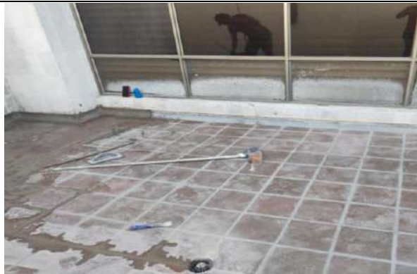
enchape de terraza 3 piso.
