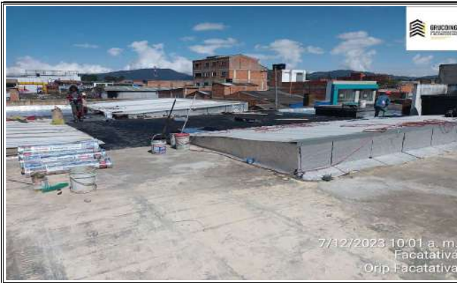
Renivelacion placa de terraza con mortero
