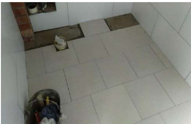
Instalación de baldosín piso y emboquillado baño discapacitados
