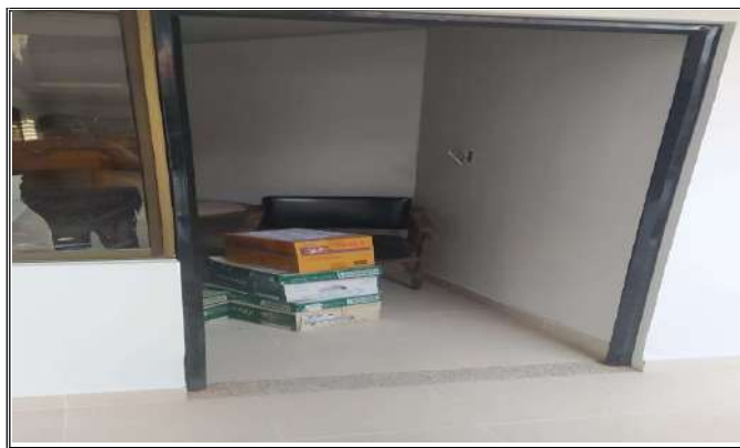
INSTALACIÓN MARCOS PARA PUERTAS
