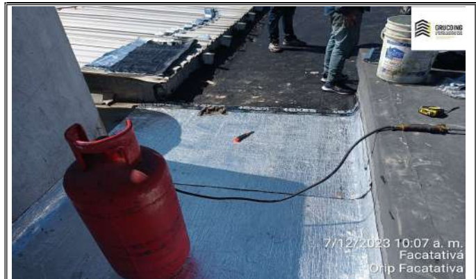
instalación de manto asfáltico
