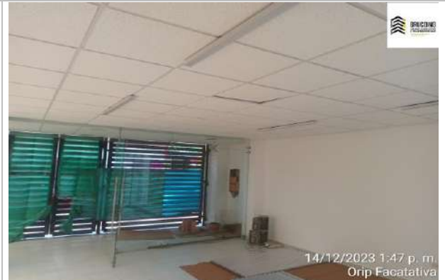
Culminación de cielo raso en área de atención al público
