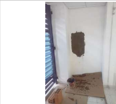
Colocación de pañete en nicho donde se encontraban contadores eléctricos
