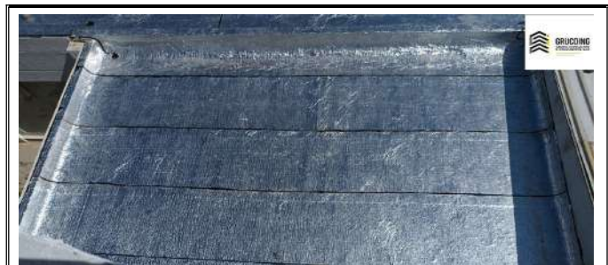
instalación de manto asfáltico
