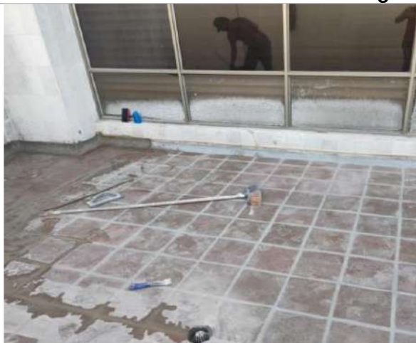
Enchape de terraza 3 piso.
