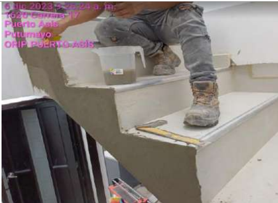
Instalación de enchape escalera
