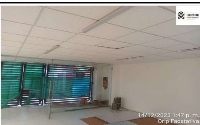
culminacion de cielo raso en area de atencion al publico
