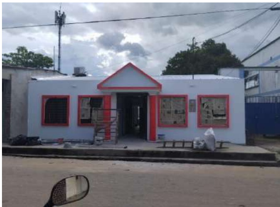
Pintura fachada principal
