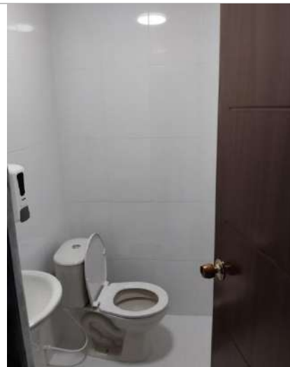
Instalacion de puerta de baño
