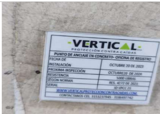
Señalización de anclajes
