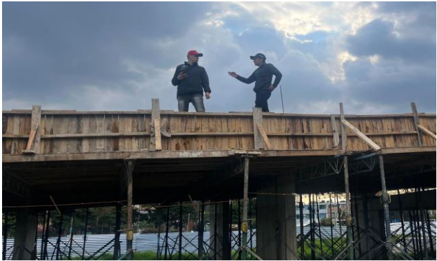
SUPERVISION DE LA CONCRETERA PARA EL COMPORTAMIENTO DEL CONCRETO
