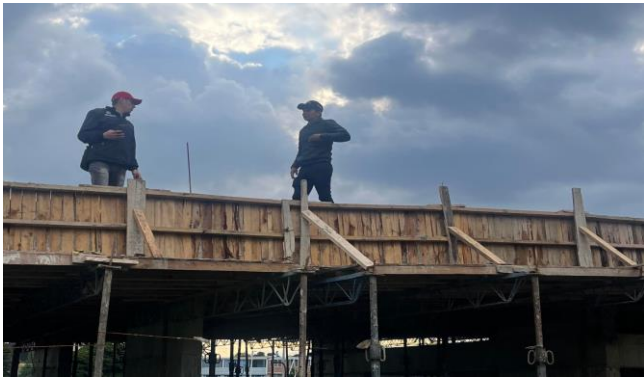
SUPERVISION DE LA CONCRETERA PARA EL COMPORTAMIENTO DEL CONCRETO
