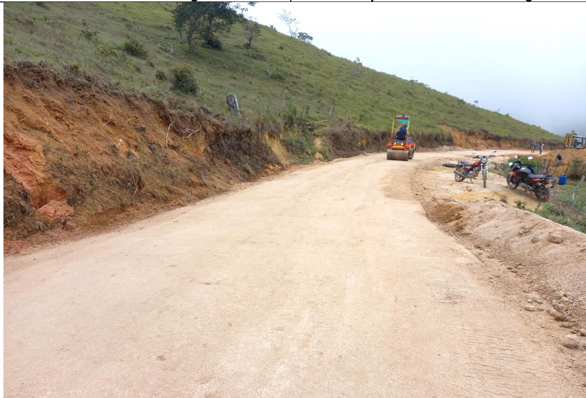
Compactación de subbase granular
