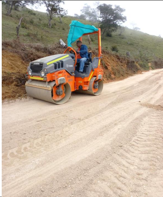
Compactación de subbase granular
