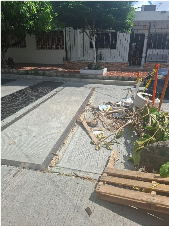
Recorrido para análisis de afectación Calle 56 #27 – 1117
