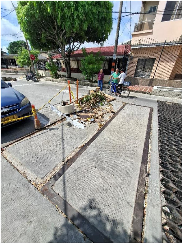
Recorrido para análisis de afectación Calle 56 #27 – 1117
