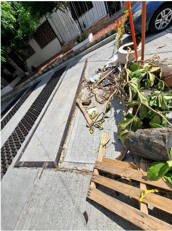
Recorrido para análisis de afectación Calle 56 #27 – 1117
