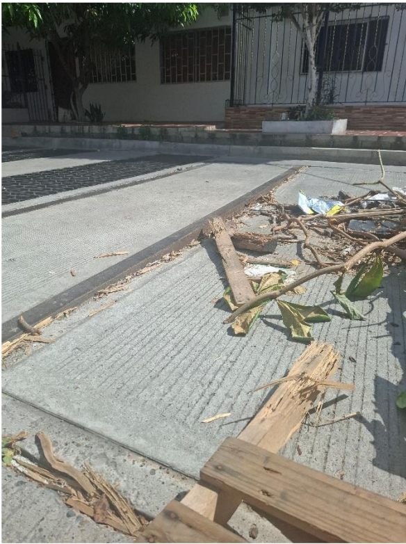
Recorrido para análisis de afectación Calle 56 #27 – 1117
