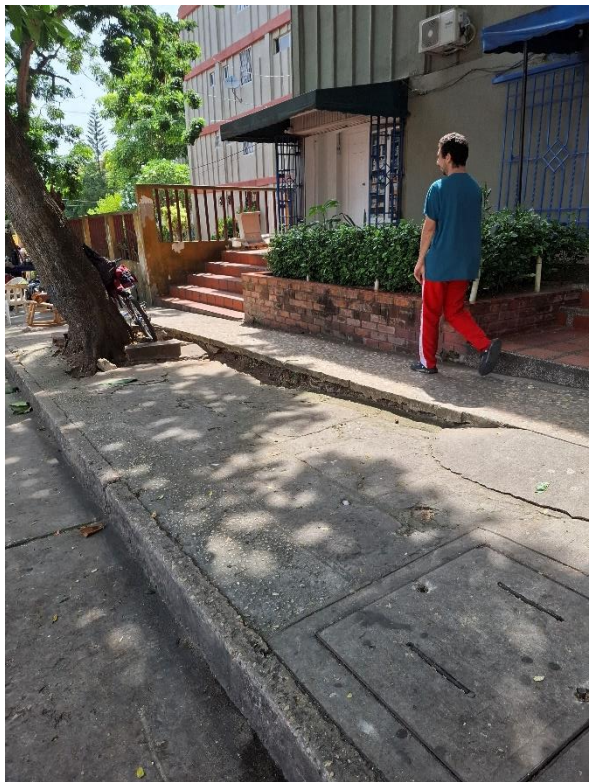
Recorrido para análisis de afectación (anden) Calle 75 entre carreras 26b y 26c2
