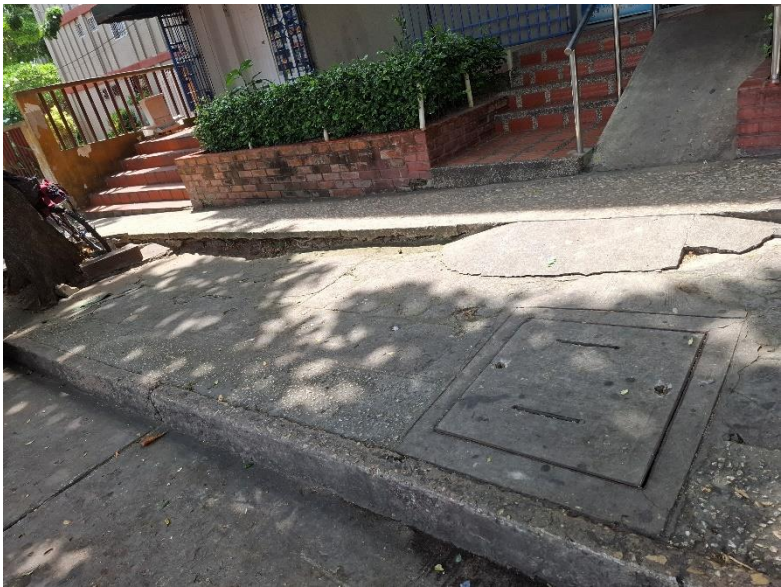
Recorrido para análisis de afectación (anden) Calle 75 entre carreras 26b y 26c2
