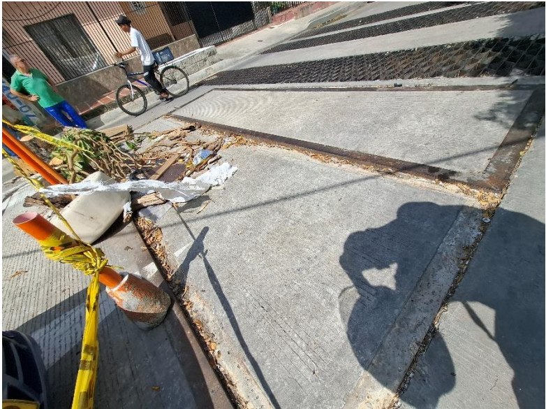
Recorrido para análisis de afectación Calle 56 #27 – 1117
