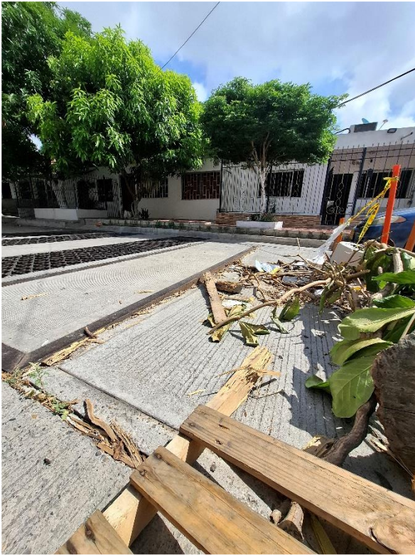
Recorrido para análisis de afectación Calle 56 #27 – 1117
