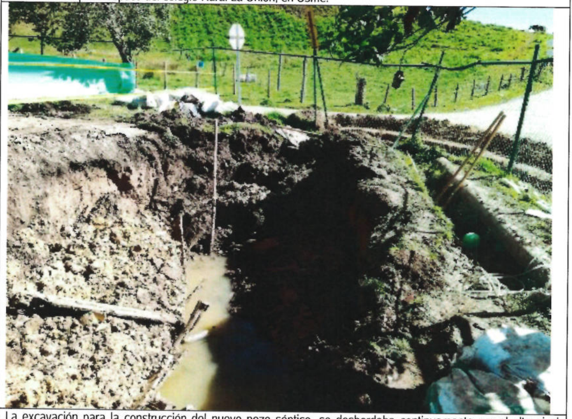
La excavación para la construcción del nuevo pozo séptico, se desbordaba continuamente por el alto nivel freático, provocando un aumento considerable en esta actividad.
