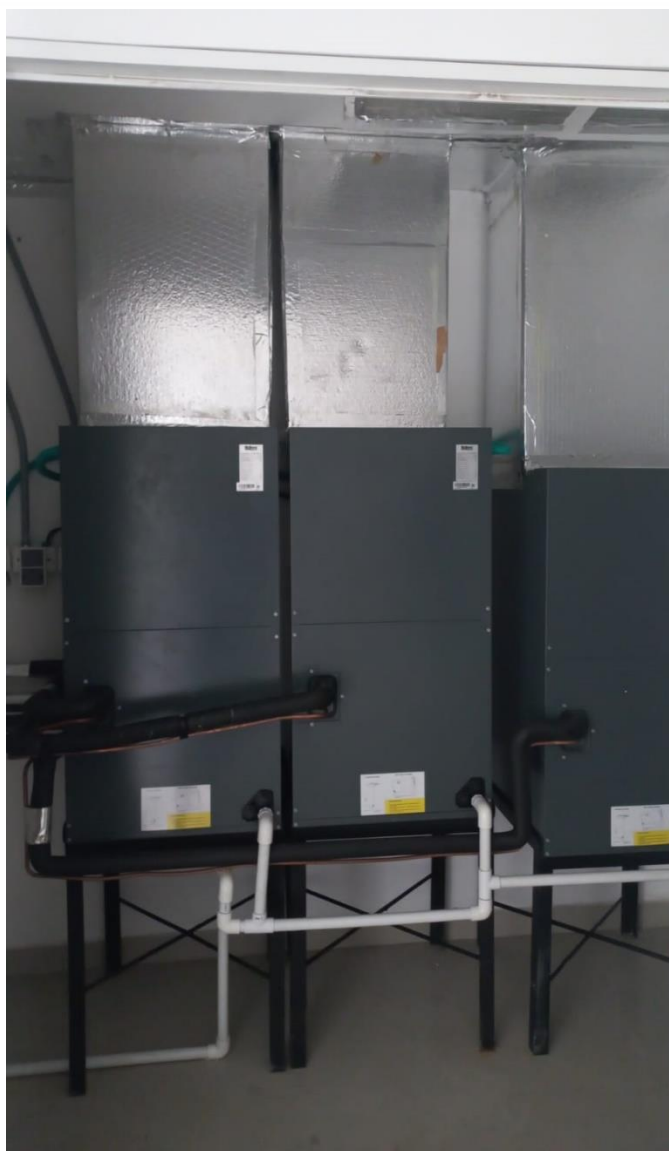
INSTALACION DE LAS (3) MANEJADORAS
