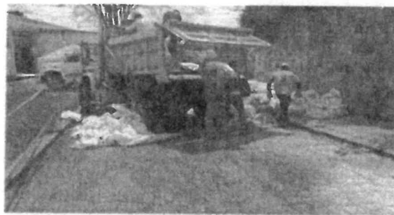
Foto NO. 6. Se revisó y verificó el retiro de los residuos de construcción y demolición, frente de trabajo IMPRENTA DISTRITAL
