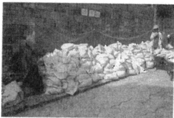
Foto NO. 1. Centro de acopio de residuos de construcción y demolición, frente de trabajo IMPRENTA DISTRITAL
