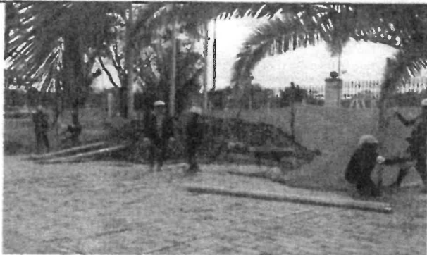
Foto NO. 3. Centro de acopio de residuos de construcción y demolición, frente de trabajo CENTRO MEMORIA PAZ Y RECONCILIACIÓN
