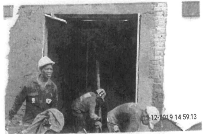
FOTO No 20: La interventoría ARQUITECTURA URBANA LTDA revisa y verifica que el contratista CONSORCIO PRUNI SEDES D4 realice el pañete con mortero de relación 1:4 "una (1) cantidad de cemento por cuatro (4) de arena" en muros ubicados en área de archivo.
