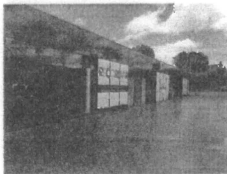
FACHADA EN VIDRIO COSTADO OCCIDENTAL CRA. 198 ✓
