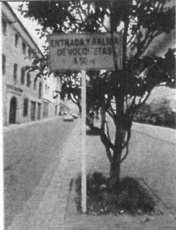
Foto No. 5: Se revisó y verificó la instalación de la señalización de la SEDE MANZANA LIÉVAND de acuerdo al plan de manejo de tráfico ubicada en la carrera 9 No. 10-50.
