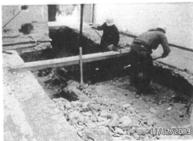
FOTO No 5: La interventoría ARQUITECTURA URBANA LTDA revisa y verifica que el contratista CONSORCIO PRUNI SEDES 04 realice la excavación manual incluye retiro en la zapata tipo Z-5.
