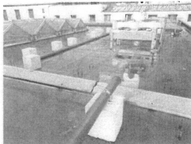
FOTO No 28: La interventoria ARQUITECTURA URBANA LTDA revisa y verifica la instalacion de junta antisísmica de tubería de cuatro pulgadas (4") en cubierta que conecta Edificio Bicentenario II y Edificio Bicentenario I de SECRETARIA DE GOBIERNO costado norte
