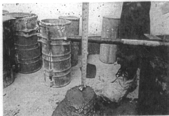
Foto No. 2: La interventoría ARQUITECTURA URBANA LTDA realiza el ensayo de asentamiento con el cono de slump al concreto dosificado y elaborado en obra lo cual dio un asentamiento del 6" lo cual está dentro de los parámetros establecidos por el diseño de mezcla entregado por el contratista.
