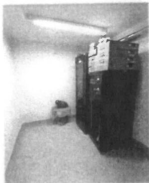
CIELO RASO EN DRY WALL Y PISO EN GRANITO PULIDO EN BUEN ESTADO EN SOTANO 2
