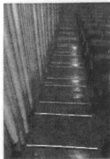
ESCALERA AUDITORIO COSTADO NORTE
