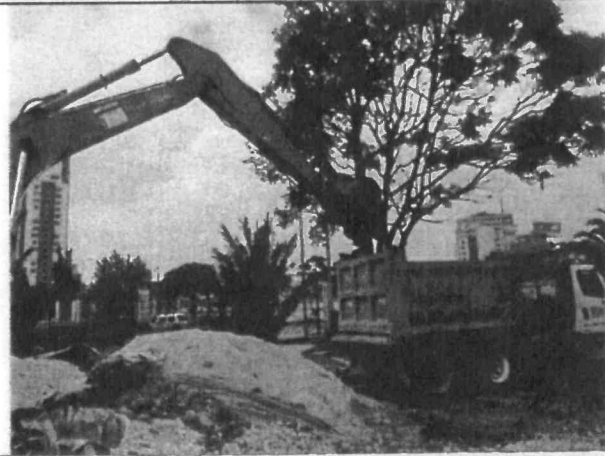
Foto No. 42. Se revisa y verifica la actividad de disposición final de residuos de construcción y demolición, sede CENTRO MEMORIA PAZ Y RECONCILIACIÓN
