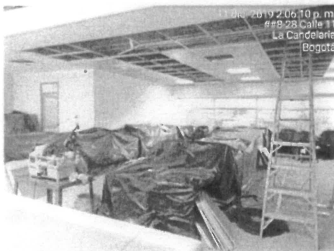
FOTO No 27: La interventoria ARQUITECTURA URBANA LTDA revisa y verifica el cubrimiento de piso, mobiliario, replanteo de redes y desmonte de cielo raso modular en piso tres (3) oficinas de Edificio Bicentenario I de SECRETARIA DE GOBIERNO.
