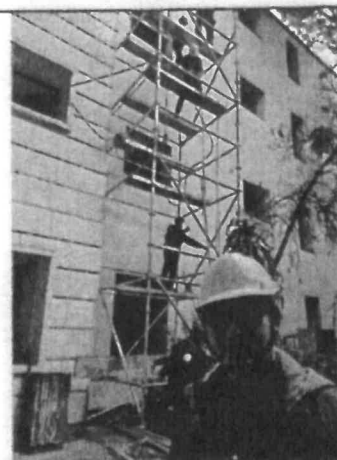
Foto No. 44. Se revisa y verifica la actividad de armado andamio multidireccional, sede MANZANA LIÉVANO, para la instalación de las red contra incendio.
