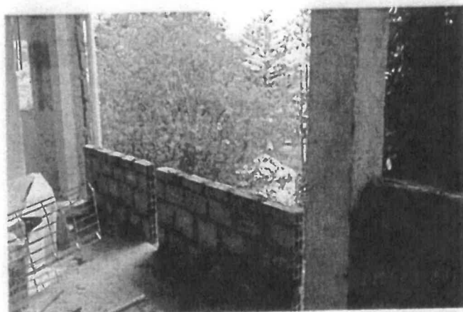
FOTO No 16: La interventoría ARQUITECTURA URBANA LTDA revisa y verifica que el contratista CONSORCIO PRUNI SEDE 04 ejecute la construcción de muro en mampostería (bloque No 5) para antepecho de ventana ubicado en el Eje A entre Ejes 2'-3' -planta segundo nivel, se verifico la verticalidad y altura del antepecho garantizando el vano de la ventana a instalar.
