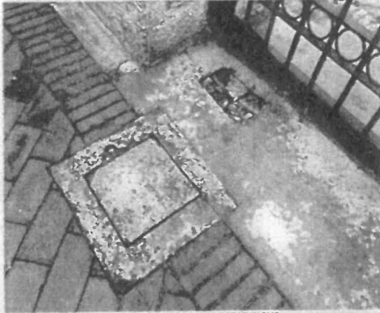
CAJA DE PASO FRENTE A PORTERIA COSTADO SUR
