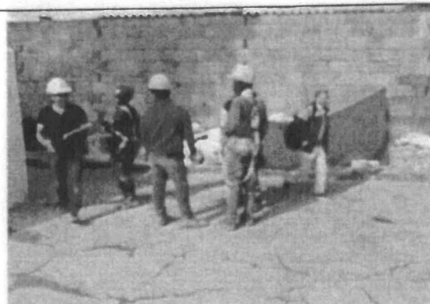
Foto No. 36: Se revisa y verifica los permisos de trabajo en alturas de personal, que está realizando trabajo aborde de placa
