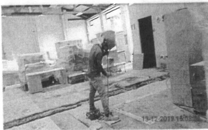
FOTO No 15: La interventoría ARQUITECTURA URBANA LTDA revisa y verifica que el contratista CONSORCIO PRUNI SEDES 04 realice el orden y aseo en área de ejecución de las diferentes actividades de obra.
