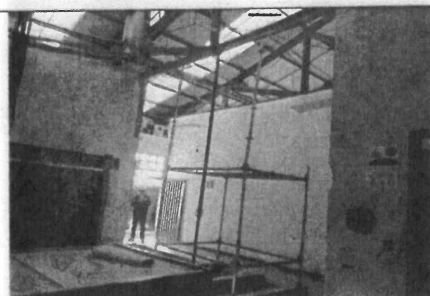
Foto No. 38: Se revisa y verifica, el cumplimiento del requerimiento de reforzamiento con paraleles a la cercha
