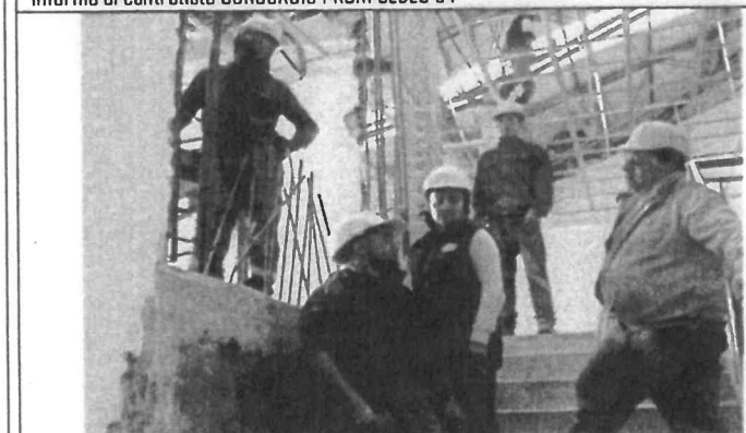
Foto No. 39: Se realiza recorrido de obra con la nueva residente de interventoría ARQUITECTURA URBANA LTDA arquitecta Nancy Rocío Ayala Gómez
