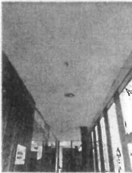
TECHO CIRCULACION FRENTE A AULAS 1, 2, 3
