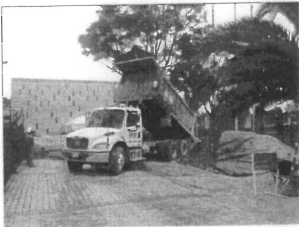
FOTO No 41: La interventoría ARQUITECTURA URBANA LTDA revisa y verifica la llegada de material filtrante MF-150 a obra.
