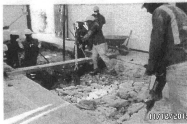
FOTO No 4: La interventoría ARQUITECTURA URBANA LTDA revisa y verifica que el contratista CONSORCIO PRUNI SEDES 04 realice la demolición de piso y placa de contrapiso para ejecutar la actividad de excavación para la zapata tipo Z-5.
