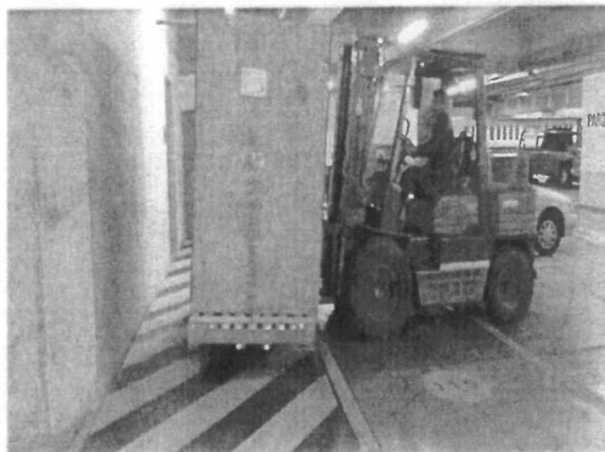
FOTO No 33: La interventoria ARQUITECTURA URBANA LTDA revisa y verifica el descargue y traslado a sótano dos (2) de la bomba para la red contra incendio de la ALCALDÍA MAYOR DE BOGOTÁ D.C".
