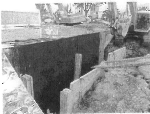
FOTO No 39: La interventoría ARQUITECTURA URBANA LTDA revisa y verifica la instalación de Geotextil NT 2500 en segundo módulo para construcción de filtro perimetral al auditorio a una profundidad de nueve (9) ML.
