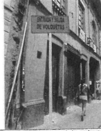
Foto No. 6: Se revisó y verificó la instalación de la señalización de la SEDE MANZANA LIÉVAND de acuerdo al plan de manejo de tráfico ubicada en la carrera 9 No. 10-50.
