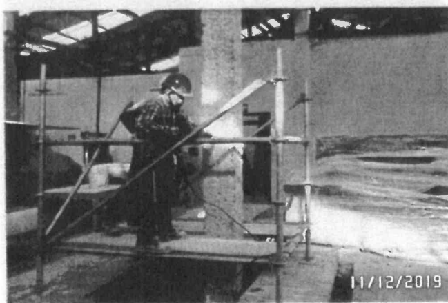
FOTO No 3: La interventoría ARQUITECTURA URBANA LTDA revisa y verifica que el contratista CONSORCIO PRUNI SEDES 04 realice la perforación para anclajes en columnas tipo CII y CI eje 7 entre Ejes M-S, se verifico el tipo de anclaje y la profundidad de la perforación lo cual son anclajes No 3 (3/8") cada 0.15 intercalados en caras alternas de profundidad de 0.15
