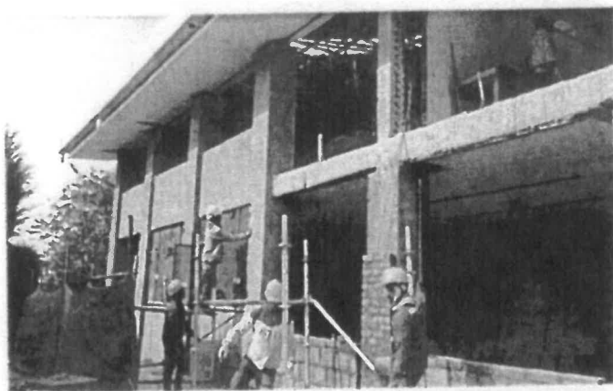
FOTO No 13: La interventoría ARQUITECTURA URBANA LTDA revisa y verifica que el contratista CONSORCIO PRUNI SEDES 04 realice la construcción de muros de antepecho de ventana ubicados en el Eje 1' entre los Ejes E-F.
