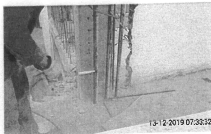
FOTO No 10: La interventoría ARQUITECTURA URBANA LTDA revisa y verifica que el contratista CONSORCIO PRUNI SEDE 04 realice la limpieza de las perforaciones antes de realizar el anclaje con resina epóxica Sika Anchorfix 300I en columnas tipo C3, C5 y C6 ubicada entre los Ejes I' - 2' y Ejes E- F.
