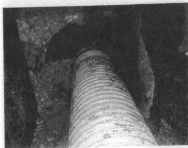
FOTO No 38: La interventoría ARQUITECTURA URBANA LTDA revisa y verifica la conexión de tubería de 8" Novafort perforada del primer al segundo módulo, para la construcción de filtro perimetral a una profundidad de nueve (9) ML.
