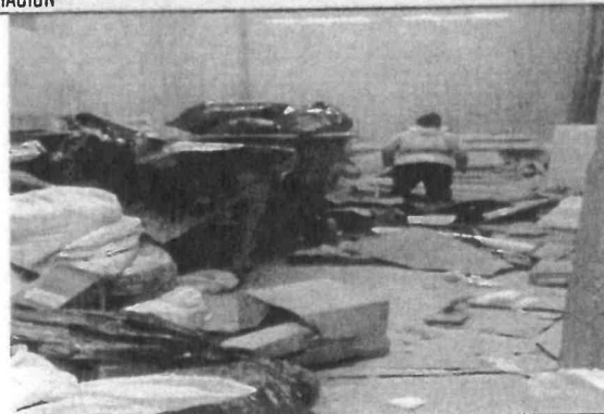
Foto No. 12: Centro de acopio de residuos de construcción y demolición, en actividad de disposición final de residuos reciclables, frente de trabajo MANZANA LIÉVANO.
