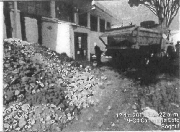
Foto No. 14: Punto de acopio de residuos de construcción y demolición, actividad de recolección de residuos para disposición final, frente de trabajo IMPRENTA DISTRITAL
