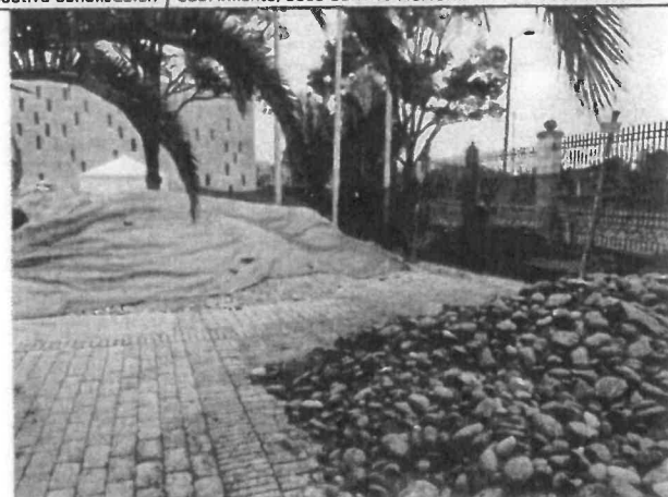
Foto No. 41. Se revisa y verifica el estado final del acopio temporal de material pétreo, sede CENTRO MEMORIA PAZ Y RECONCILIACIÓN
