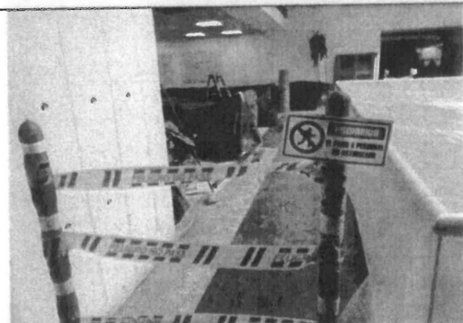
Foto No. 23: Se revisa y verifica que se cumpla con el programa de señalización sede MANZANA LIEVANO.
