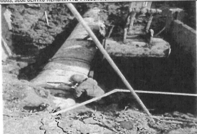
Foto No. 29: Se revisa y verifica la actividad de traslape y movimiento de material para acomodación de tubería, sede CENTRO MEMORIA PAZ Y RECONCILIACIÓN.
