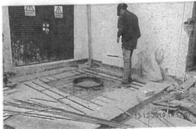
FOTO No 14: La interventoría ARQUITECTURA URBANA LTDA revisa y verifica que el contratista CONSORCIO PRUNI SEDE 04 realice el encofrado y refuerzo de la tapa para la caja de inspección eléctrica tipo CS 276 de referencia Codensa
