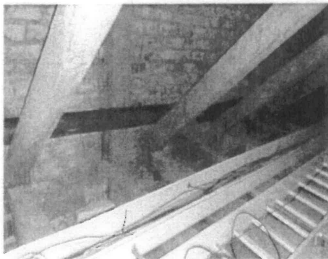
FOTO No 25: La interventoria ARQUITECTURA URBANA LTDA revisa y verifica el traslado de tubería por cubierta del EDIFICIO MUNICIPAL, para conexión con el sistema de red contra incendio del Edificio Bicentenario I de SECRETARIA GENERAL.
