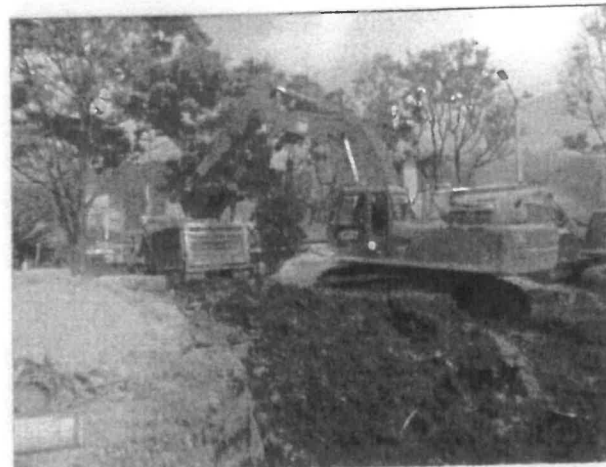
FOTO No 42: La interventoría ARQUITECTURA URBANA LTDA revisa y verifica el cargue y retiro de material de excavación a sitio autorizado.
