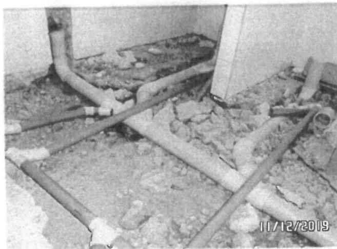
FOTO No 7: La interventoría ARQUITECTURA URBANA LTDA revisa y verifica que el contratista CONSORCIO PRUNI SEDES 04 realice la instalación de tuberías para la red sanitaria de baños para mujeres en la planta del primer nivel, se verifico diámetros de tubería y ubicación de los sistemas sanitarios, lo cuales son tubería de diámetro de 4" y lavamanos de 2".
