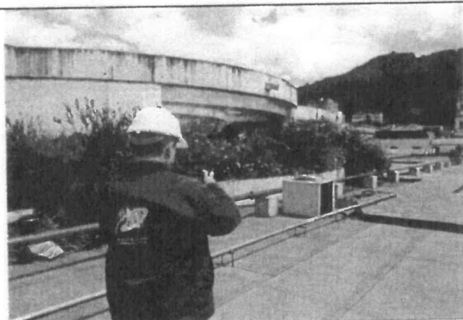
Foto No. 19: Se revisa y verifica las medidas de seguridad en la instalación de la tubería de la red contra incendio, en la cubierta en compañía del ingeniero Carlos Giovanni Wilches Montaña y el inspector Juan Carlos Briceño
