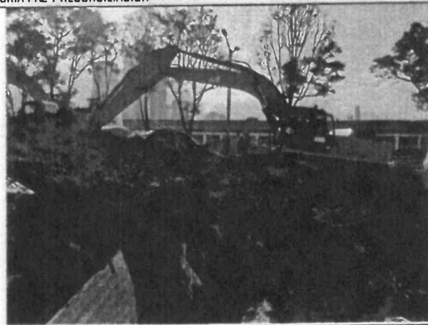
Foto No. 34: Se revisa y verifica la actividad de movimiento de tierras, sede CENTRO MEMORIA PAZ Y RECONCILIACIÓN
