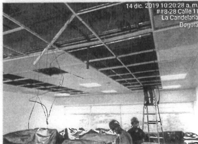
FOTO No 36: La interventoria ARQUITECTURA URBANA LTDA revisa y verifica la instalacion de tubería de red contra incendio en tercer (3) piso de Edificio Bicentenario I SECRETARIA DE GOBIERNO.
