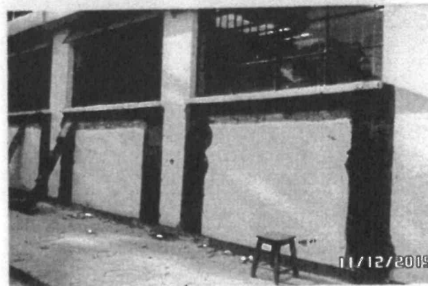
FOTO No 2: La interventoría ARQUITECTURA URBANA LTDA revisa y verifica que el contratista CONSORCIO PRUNI SEDES 04 realice el vaciado de concreto de columnetas ubicadas en los antepechos de ventana Eje R-U, se verifico recubrimiento de concreto el cual es de 0.045 y dosificación del concreto de 3000 PSI.
