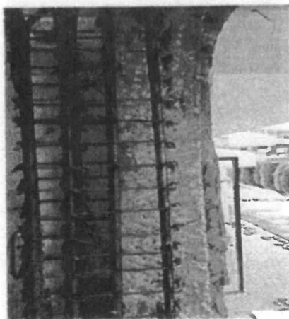
FOTO No 11: La interventoría ARQUITECTURA URBANA LTDA revisa y verifica que el contratista CONSORCIO PRUNI SEDE 04 realice el amarre de acero de refuerzo en columnas tipo C3, C5 y C6 ubicada entre los Ejes I' - 2' y Ejes E- F. se verifico diámetros de varillas y cantidad de flejes, para lo cual la columna tipo C3 presenta diez (10) varillas No 6 (3/4") y treinta y dos (32) flejes No 3 (3/8") cada 0.15, las columnas tipo C5 presenta diez (10) varillas de refuerzo No 7 (3/4") y treinta y dos (32) flejes cada 0.15, y la columna tipo C6 presenta siete (7) varillas No 7 (7/8") y treinta y dos (32) flejes cada 0.15.
