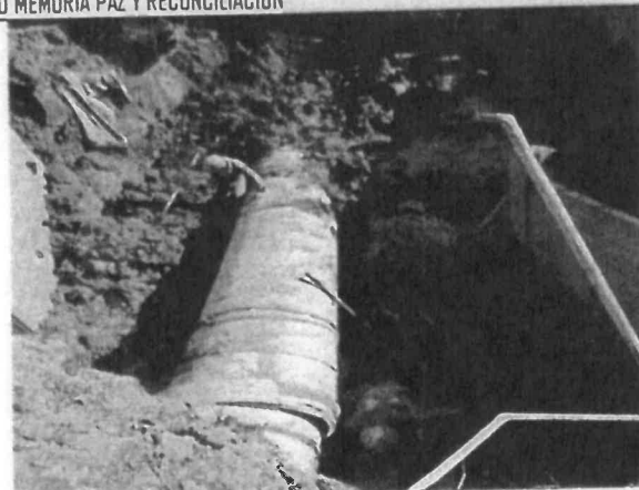
Foto No. 30: Se revisa y verifica la actividad de traslape y movimiento de material para acomodación de tubería, sede CENTRO MEMORIA PAZ Y RECONCILIACIÓN.
