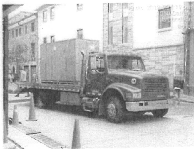
FOTO No 32: La interventoria ARQUITECTURA URBANA LTDA revisa y verifica la llegada de la bomba para la red contra incendio de la ALCALDÍA MAYOR DE BOGOTÁ D.C".
