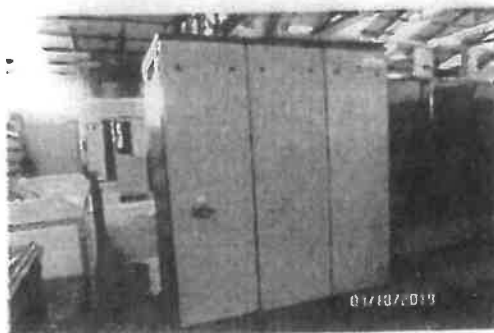
Impresora Speedmaster, planta eléctrica
