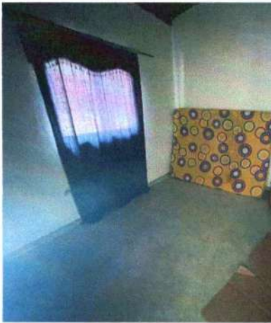
HABITACION ACABADOS DE PISO –(DESPUÉS)
