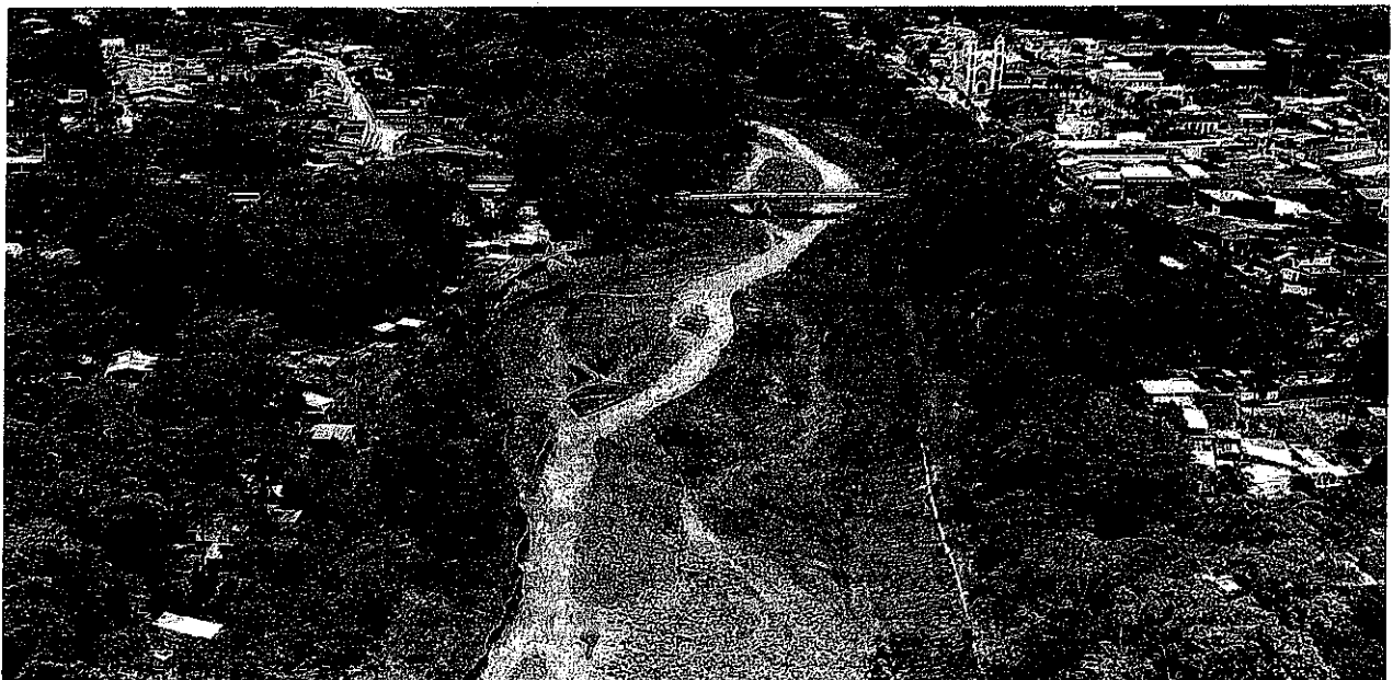
Previo a la intervención, Municipio de Restrepo, Río Upin – Sector Entre Puentes.
