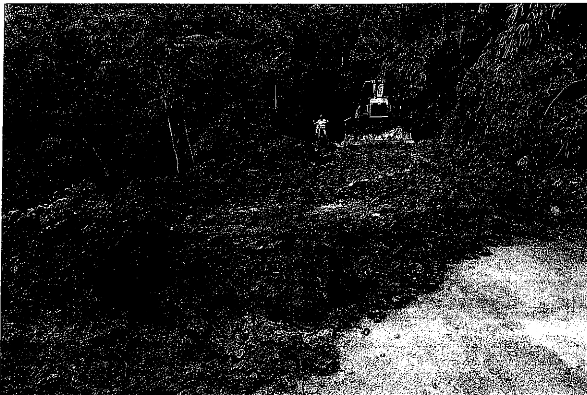
Durante la intervención, Municipio de El Calvario, Vía El Calvario.
