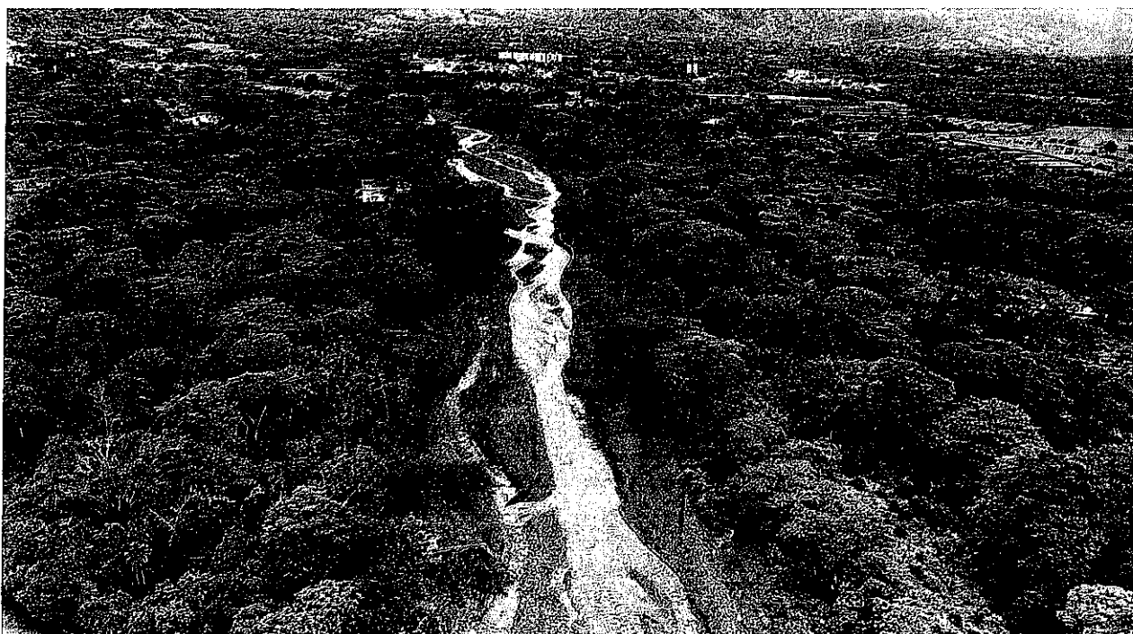
Posterior a la intervención, Municipio de Restrepo, Río Upin – Vereda Los Medios.
