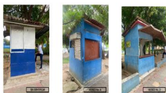
DEMOLICION 3 KIOSCOS SIN USO PARQUE UNIVERSAL - GENERAN FOCOS DE INSEGURIDAD.
