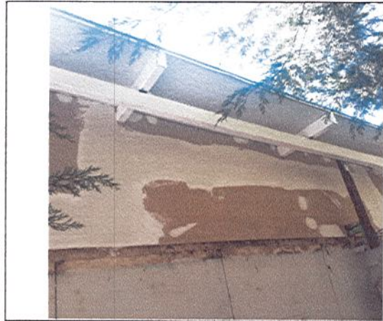
ENCOROZADO EN SUPERBOARD PARA REMATE ENTRE CUBIERTA Y MURO EXISTENTE
