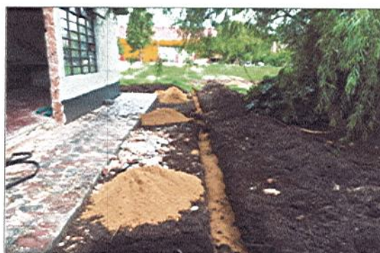
EXCAVACIÓN DE ACOMETIDA
