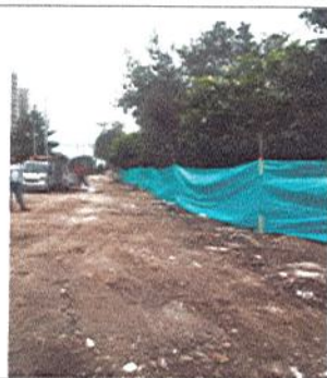
CERRAMIENTO EN LONA VERDE EXTERIOR
