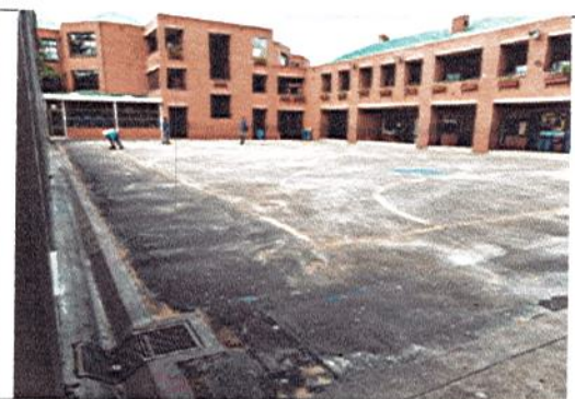
SELLAMIENTO DE FISURAS
