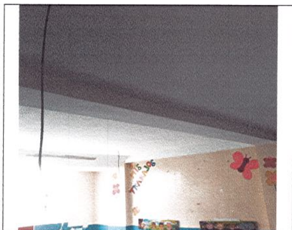
PINTURA DE CIELO RASO EN SUPERBOARD DE SALONES SEGUNDO PISO, ACABADO FINAL
