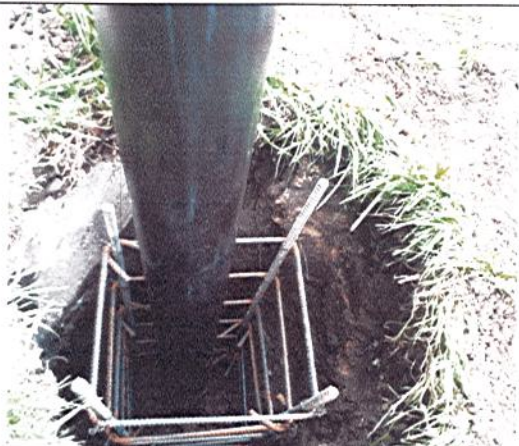
ARMADO DE PEDESTALES PARA FUNDICIÓN DE POSTES
