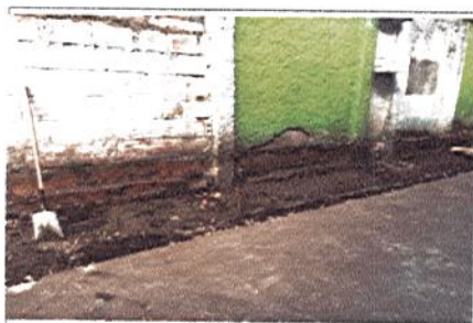
EXCAVACIÓN DE ÁREA DE JARDINERA PARA CONSTRUCCIÓN POSTERIOR DE PLACA
