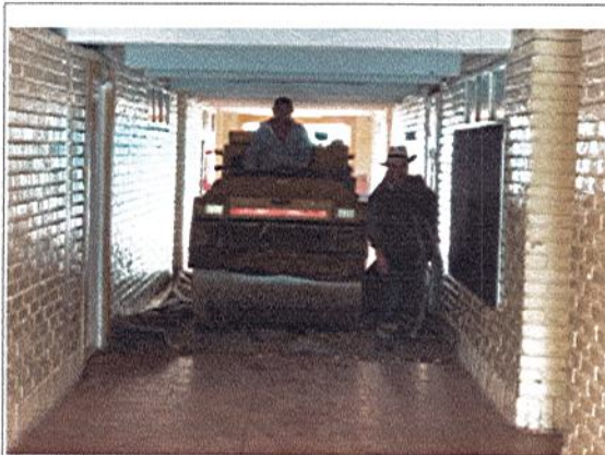
INGRESO DE MAQUINARIA PARA COMPACTACIÓN DE SUELO
