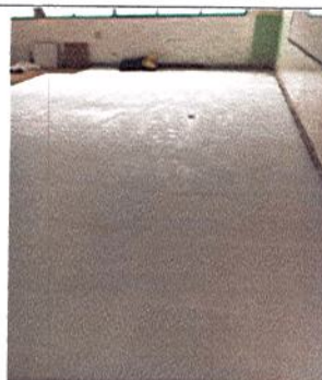
INSTALACIÓN DE ENCHAPE PISO
