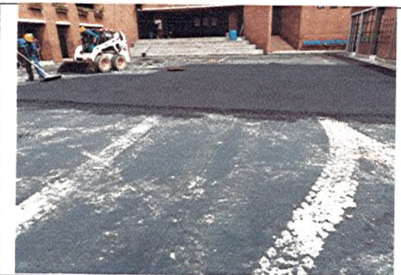
EXTENDIDA DE PAVIMENTO EN ZONA 4
