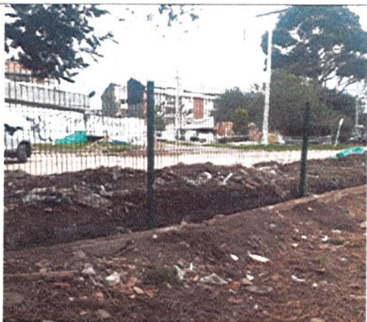
INSTALACIÓN DE CERRAMIENTO
