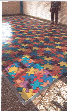
INSTALACIÓN DE PIRLAN DE ALUMINIO PARA TAPETE DIDACTICO
