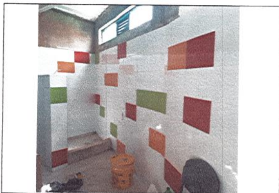
FINALIZA ENCHAPE DE MUROS
