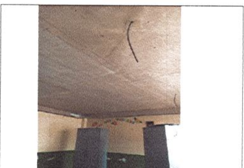
FINALIZAN ACTIVIDADES ELECTRICAS PARA MONTAJE DE LUMINARIAS
