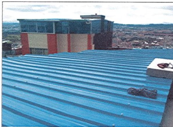
FINALIZA INSTALACIÓN DE CUBIERTA Y PLACA DE SOPORTE DE TANQUE DE ALMACENAMIENTO
