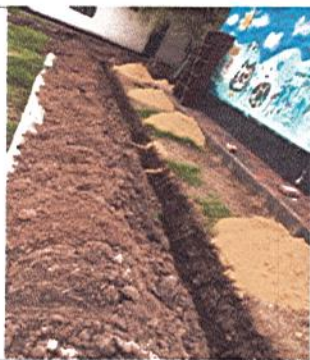
EXCAVACIÓN DE ACOMETIDA
