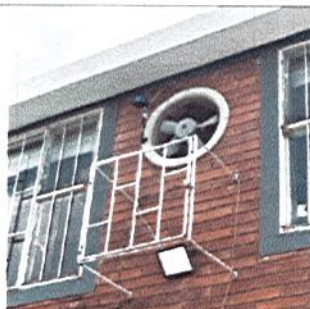
CONEXIÓN E INSTALACIÓN DE REFLECTOR EXTERIOR
