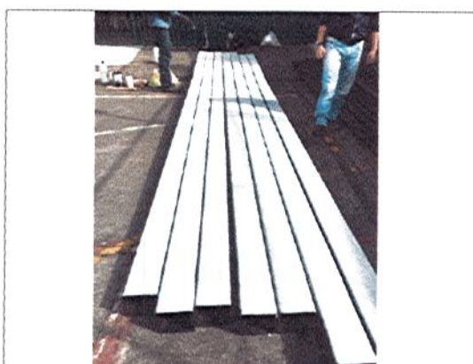
PINTURA EN SITIO DE PERFILERIA DE SOPORTE PARA INSTALACIÓN DE CUBIERTA NUEVA
