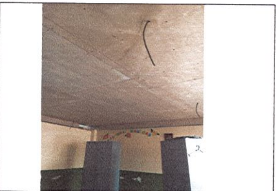
FINALIZAN ACTIVIDADES ELECTRICAS PARA MONTAJE DE LUMINARIAS
