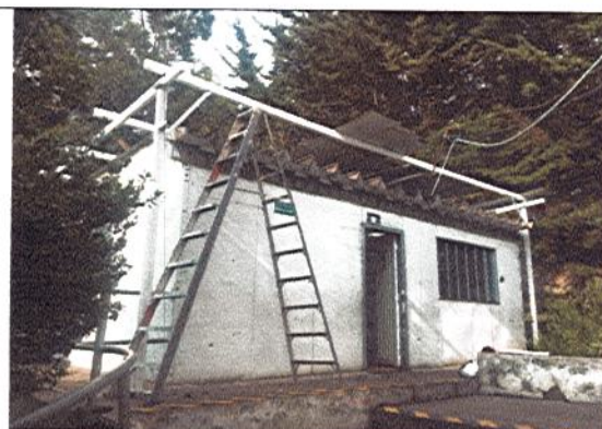
INICIA MONTAJE DE CUBIERTA (TEJA TIPO SANDWICH)
