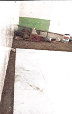
INSTALACIÓN DE ENCHAPE PISO
