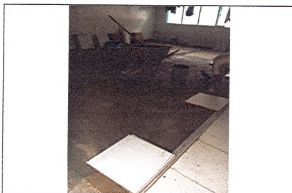
INSTALACIÓN DE ENCHAPE PISO
