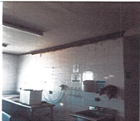
RELLENO Y NIVELACION PARA INSTALACIÓN DE MEDIA CAÑA EN PVC ENTRE PLACA Y MURO
