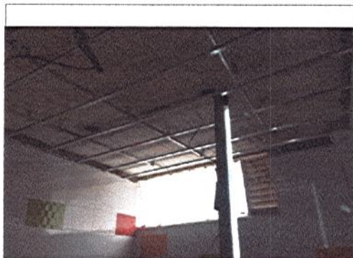
MONTAJE FINAL DE ESTRUCTURA PARA MONTAJE DE CIELO RASO EN SUPERBOARD EN BAÑOS
