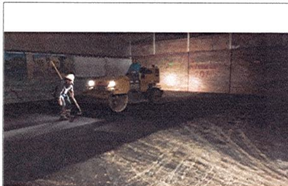
COMPACTACIÓN DE SUELO
