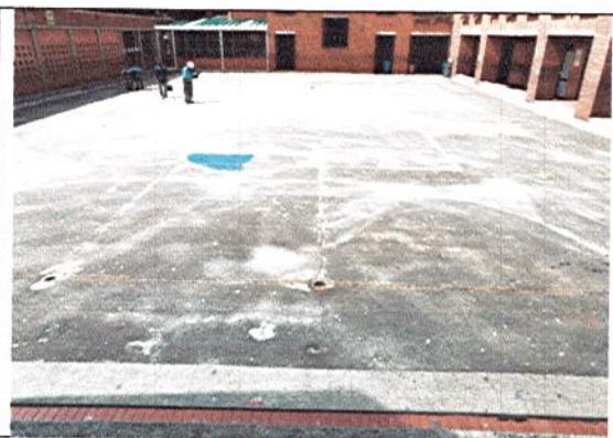
SELLAMIENTO DE FISURAS
