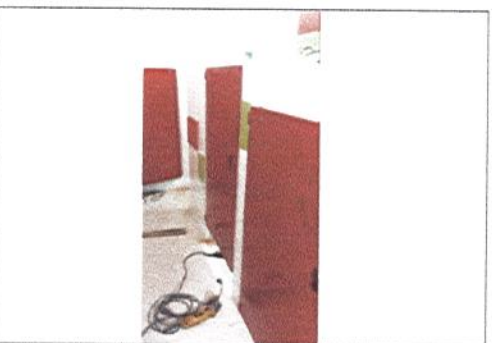
INSTALACIÓN DE PUERTAS METALICAS PARA SANITARIOS
