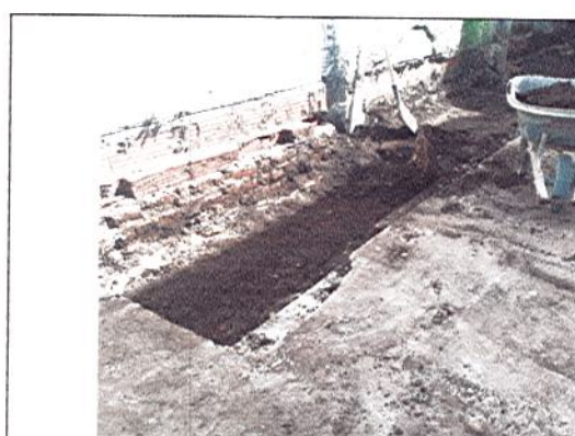
RELLENO DE ZANJA PARA PLACA NUEVA
