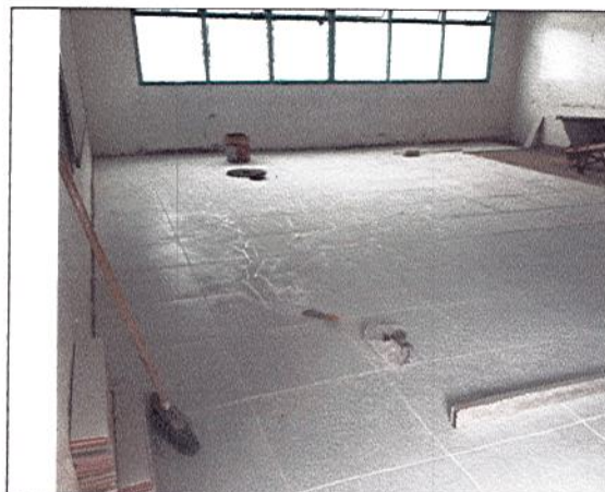
INSTALACIÓN DE MEDIAS CAÑAS PERIMETRALES EN SALON 2
