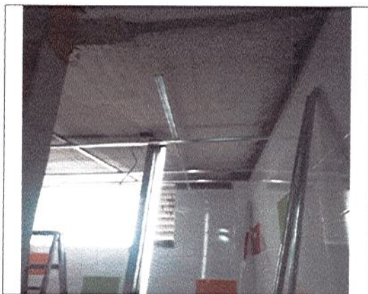
INSTALACIÓN DE ESTRUCTURA DE CIELO RASO EN SUPERBOARD
