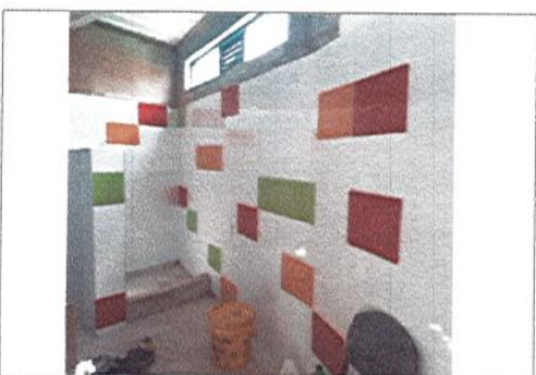
FINALIZA ENCHAPE DE MUROS
