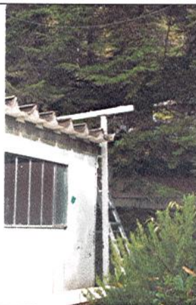
INICIA MONTAJE DE CUBIERTA (PERFILERÍA)
