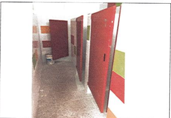
INSTALACIÓN DE PUERTAS METÁLICAS PARA BAÑOS
