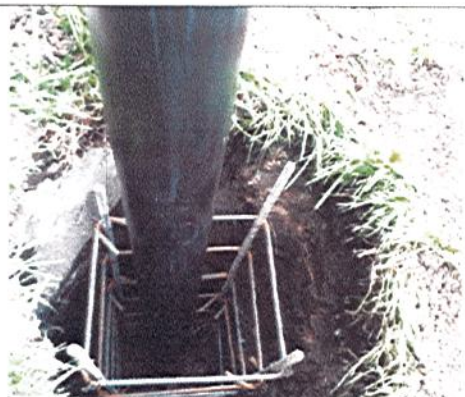
ARMADO DE PEDESTALES PARA FUNDICIÓN DE POSTES
