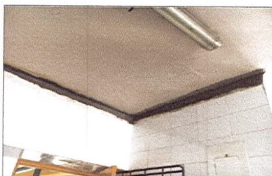
RELLENO Y NIVELACION PARA INSTALACIÓN DE MEDIA CAÑA EN PVC ENTRE PLACA Y MURO
