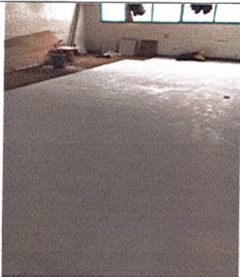
INSTALACIÓN DE ENCHAPE PISO
