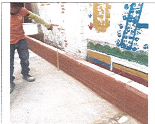
CONSTRUCCIÓN DE JARDINERA NUEVA
