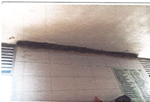
RELLENO Y NIVELACION PARA INSTALACIÓN DE MEDIA CAÑA EN PVC ENTRE PLACA Y MURO
