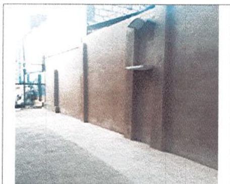
PAÑETE DE MUROS LISO
