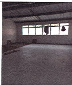
INSTALACIÓN DE ENCHAPE PISO
