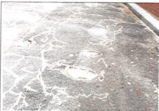
SELLAMIENTO DE FISURAS
