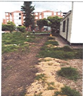
RELLENO DE ZANJA DE ACOMETIDA
