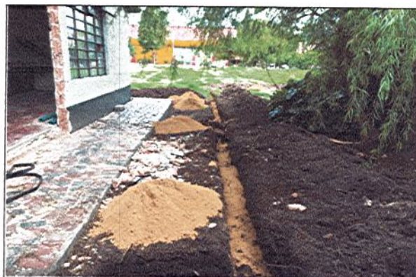
EXCAVACIÓN DE ACOMETIDA
