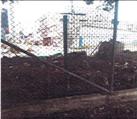
INSTALACIÓN DE CERRAMIENTO
