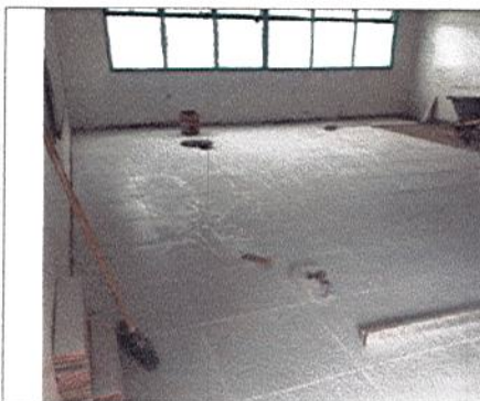
INSTALACIÓN DE MEDIAS CAÑAS PERIMETRALES EN SALON 2
