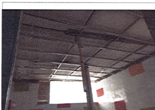
MONTAJE FINAL DE ESTRUCTURA PARA MONTAJE DE CIELO RASO EN SUPERBOARD EN BAÑOS
