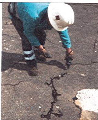
SELLAMIENTO DE FISURAS
