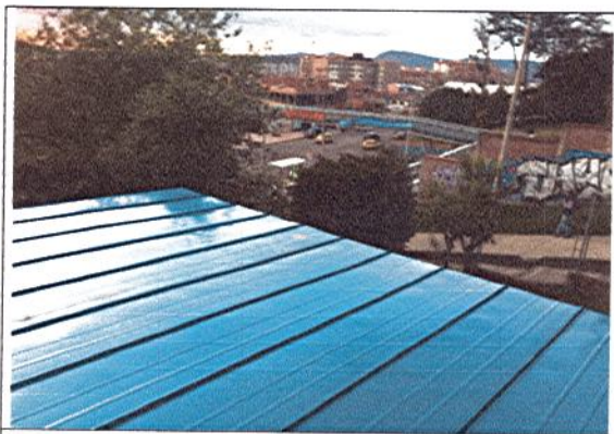
MONTAJE DE CUBIERTA TIPO SANDWICH
