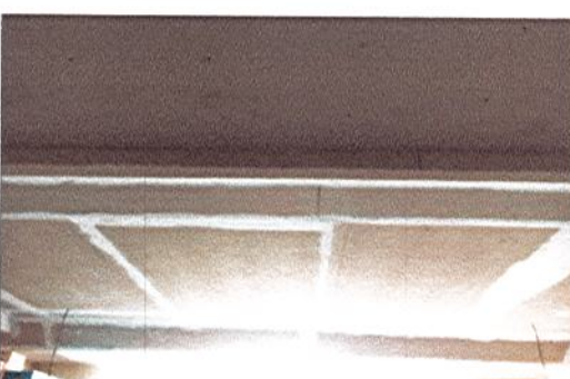
EMPASTADO DE JUNTAS LAMINAS DE SUPERBOARD
