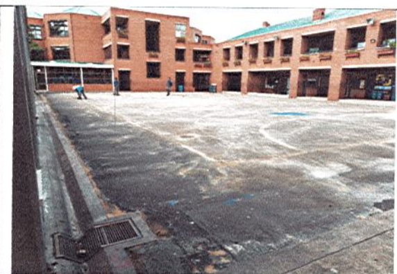
SELLAMIENTO DE FISURAS
