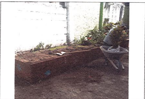
RETIRO DE SIEMBRA, Y DEMOLICIÓN DE JARDINERA
