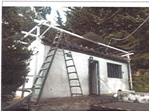
MONTAJE DE CUBIERTA TIPO SANDWICH
