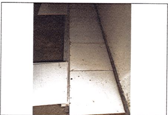
INSTALACIÓN DE ENCHAPE PISO
