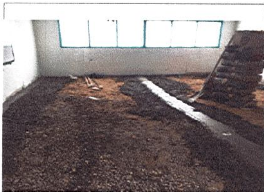
RELLENO, COMPACTACIÓN Y ALISTADO DE PISO
