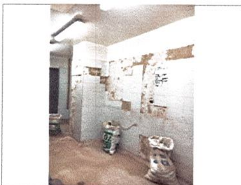
DEMOLICIÓN DE ENCHAPES FISURADOS EN MURO
