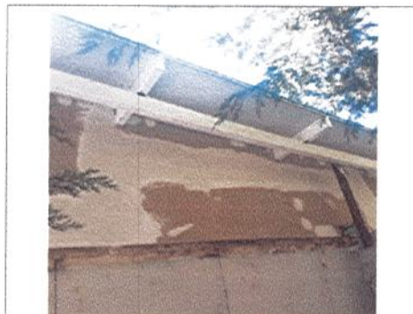
ENCOROZADO EN SUPERBOARD PARA REMATE ENTRE CUBIERTA Y MURO EXISTENTE
