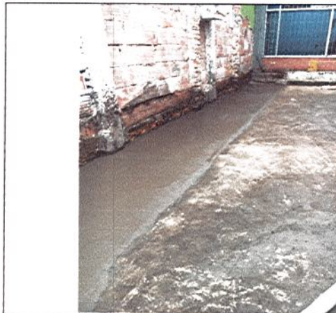
FUNDICIÓN DE PLACA Y NIVELACIÓN DE PISO
