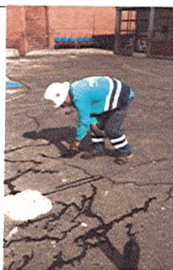
SELLAMIENTO DE FISURAS
