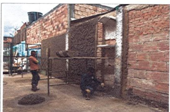
RETIRO DE PAÑETE EXISTENTE
