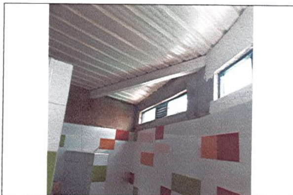
ESTUCO Y PINTURA DE MUROS SUPERIORES
