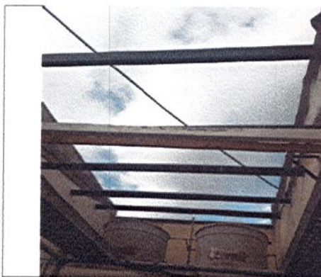
DESMONTE DE CUBIERTA EXISTENTE DE ASBESTO CEMENTO EN ZONA DE ESCALERAS
