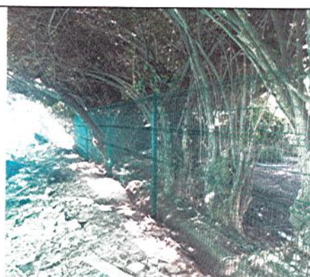
INSTALACIÓN DE CERRAMIENTO PERIMETRAL
