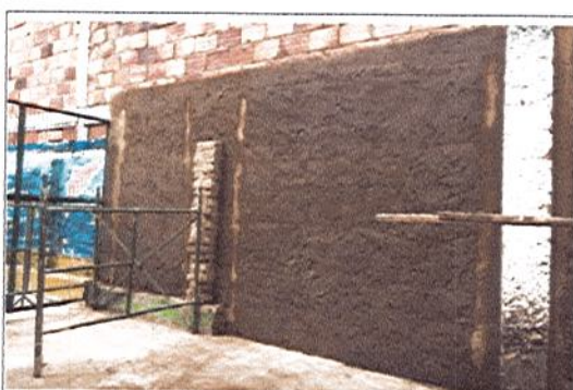
REPOSICIÓN DE PAÑETE EN MUROS
