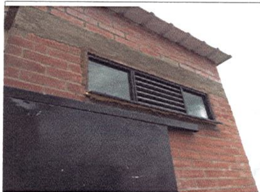
INSTALACIÓN DE VIDRIOS PARA VENTANERIA
