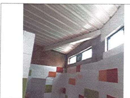
ESTUCO Y PINTURA DE MUROS SUPERIORES
