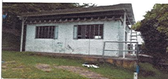
MONTAJE DE CUBIERTA TIPO SANDWICH
