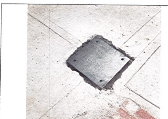
INSTALACIÓN DE PLATINAS PARA MONTAJE DE POSTES
