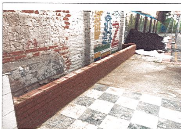
CONSTRUCCIÓN DE JARDINERA NUEVA
