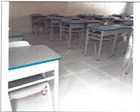
FINALIZA INSTALACIÓN DE ENCHAPE DE PISO EN SALON 1
