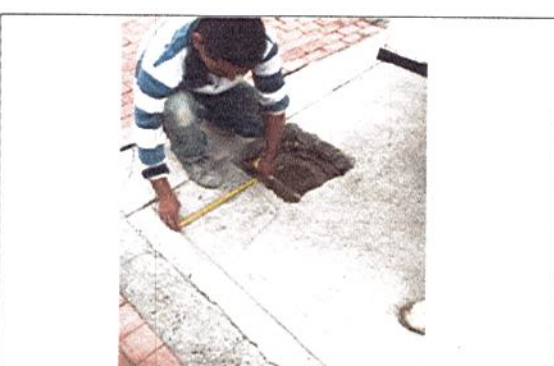
EXCAVACIÓN PARA PEDESTALES(ZONA DE CANCHA)
