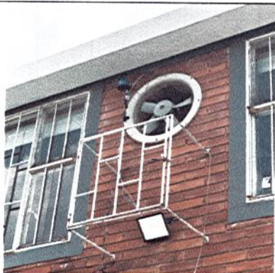
CONEXIÓN E INSTALACIÓN DE REFLECTOR EXTERIOR
