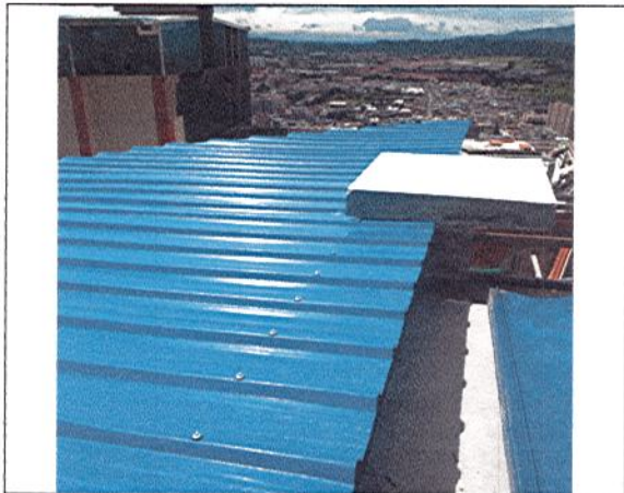
FINALIZA INSTALACIÓN DE CUBIERTA Y PLACA DE SOPORTE DE TANQUE DE ALMACENAMIENTO
