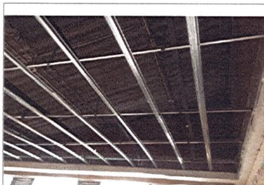
INSTALACION DE ESTRUCTURA PARA CIELO RASO EN SUPERBOARD EN SALONES
