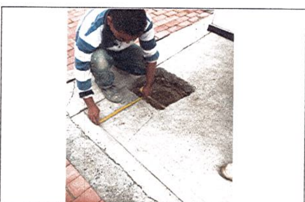
EXCAVACIÓN PARA PEDESTALES(ZONA DE CANCHA)
