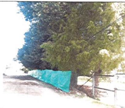
CERRAMIENTO Y LIMPIEZA DE ÁREA DE INTERVENCIÓN
