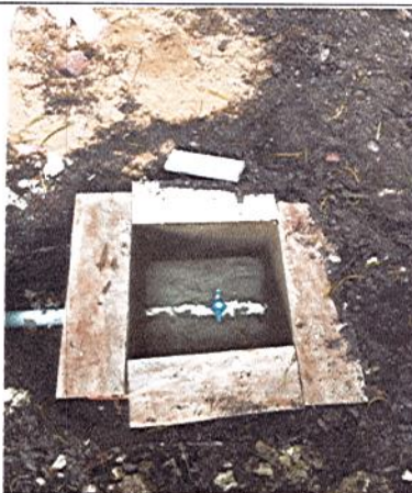
FUNDICION DE CAJA DE PASO
