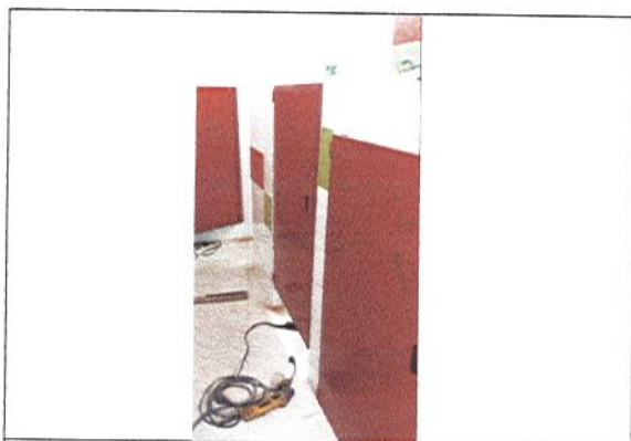
INSTALACIÓN DE PUERTAS METALICAS PARA SANITARIOS
