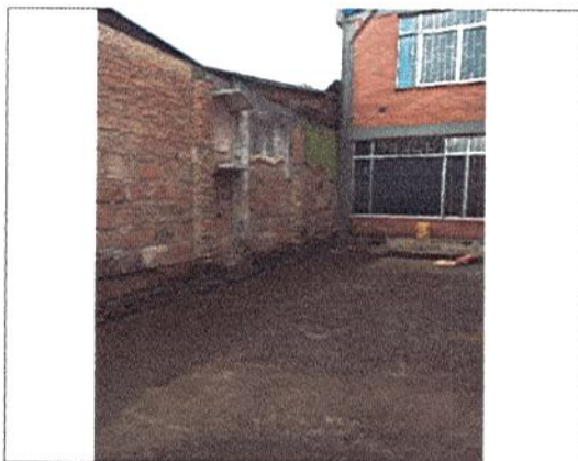
FUNDICIÓN DE PLACA Y NIVELACIÓN DE PISO
