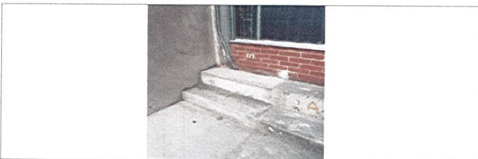
CONSTRUCCIÓN DE ESCALONES
