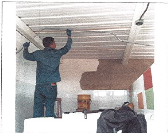
INSTALACIÓN DE TUBERIA EMT ELECTRICA
