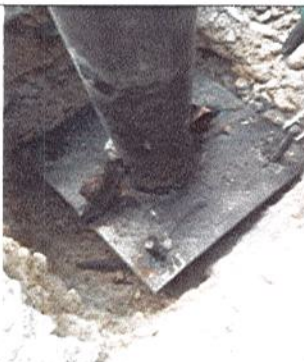
INSTALACIÓN DE PLATINAS PARA MONTAJE DE POSTES EN ZONA DE BAÑOS
