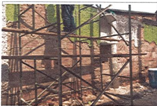
DEMOLICIÓN DE ENCHAPE MURO
