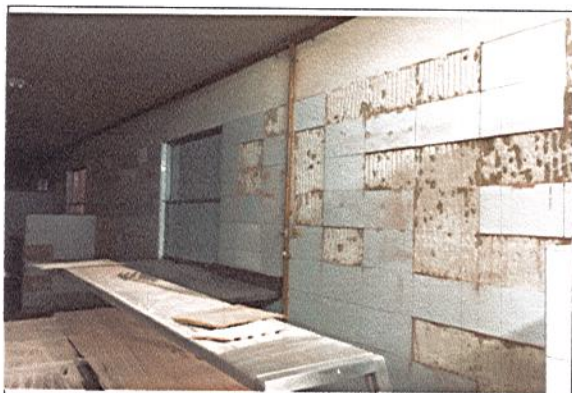
DESMONTE DE ENCHAPES FISURADOS DE MURO
