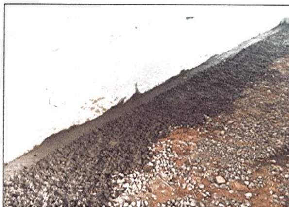
RELLENO,COMPACTACIÓN Y ALISTADO DE PISO
