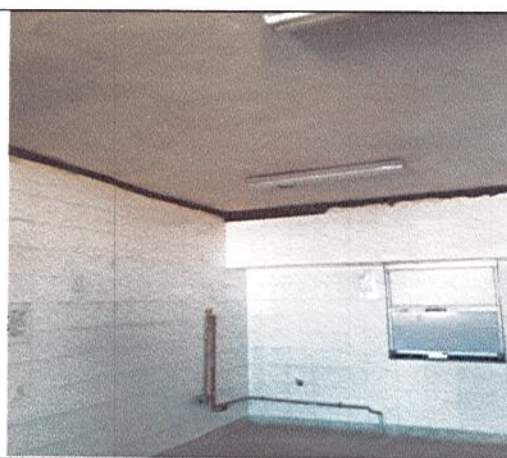
RELLENO Y NIVELACION PARA INSTALACIÓN DE MEDIA CAÑA EN PVC ENTRE PLACA Y MURO
