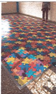
INSTALACIÓN DE PIRLA/ DE ALUMINIO PARA TAPETE DIDACTICO
