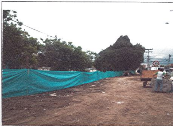
CERRAMIENTO EN LONA VERDE EXTERIOR
