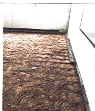
DESMONTE DE ADOQUIN EN SALONES
