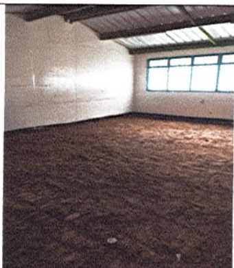
DESMONTE DE ADOQUIN EN SALONES
