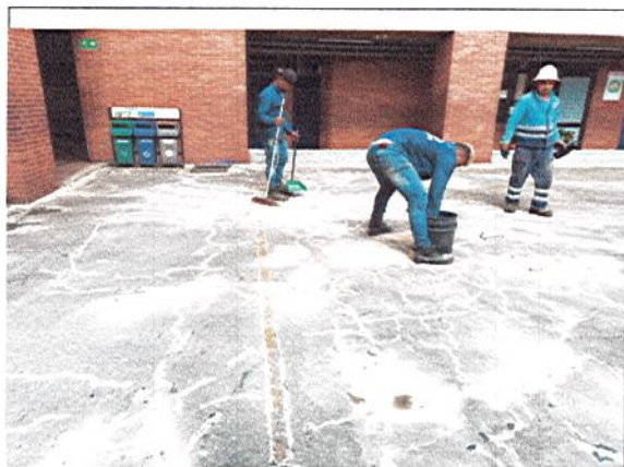
SELLAMIENTO DE FISURAS
