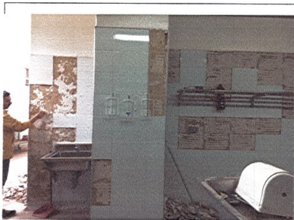
DEMOLICIÓN DE ENCHAPES FISURADOS EN MURO
