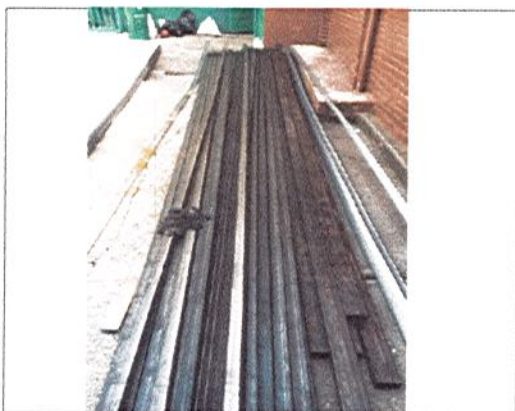
INGRESO DE PERFILERIA DE SOPORTE PARA INSTALACIÓN DE CUBIERTA NUEVA
