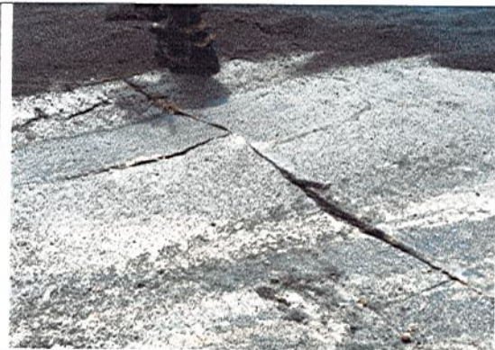
EVIDENCIA DE LEVANTAMIENTO DEL PAVIMENTO EXISTENTE
