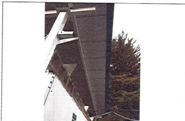
MONTAJE DE CUBIERTA TIPO SANDWICH Y DESMONTE DE CUBIERTA CANALETA 90 EXISTENTE
