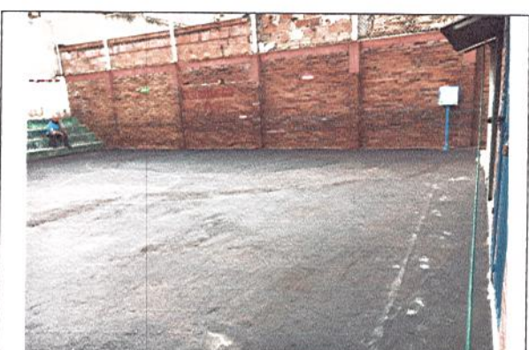
APLICACIÓN DE SLURRING PARA SELLAMIENTO DE FISURAS
