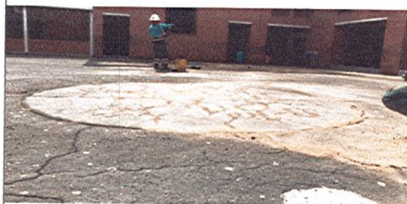
SELLAMIENTO DE FISURAS
