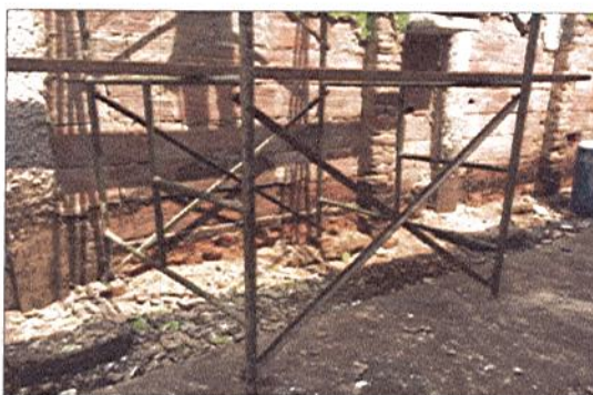
DEMOLICIÓN DE ENCHAPE MURO
