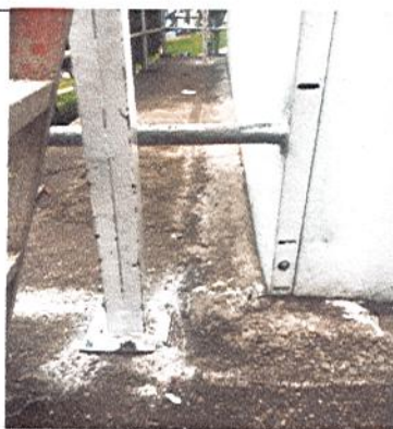
INICIA MONTAJE DE CUBIERTA (PERFILERÍA)
