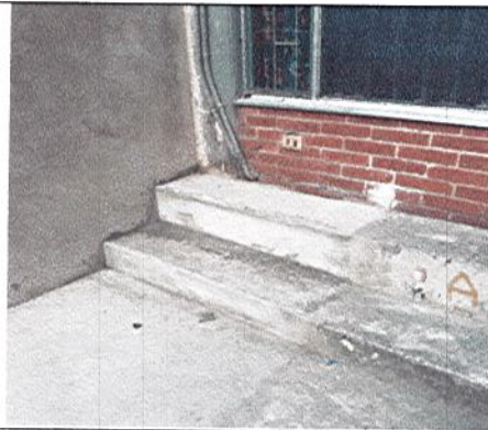
CONSTRUCCIÓN DE ESCALONES
