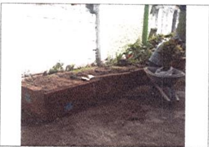
RETIRO DE SIEMBRA Y DEMOLICIÓN DE JARDINERA
