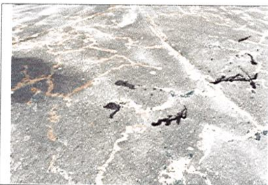
SELLAMIENTO DE FISURAS
