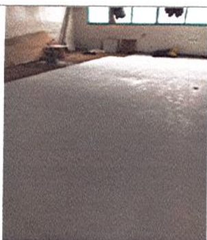
INSTALACIÓN DE ENCHAPE PISO
