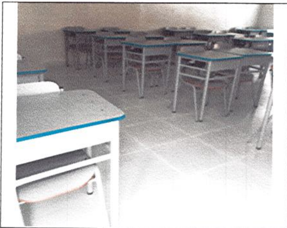
FINALIZA INSTALACIÓN DE ENCHAPE DE PISO EN SALON 1
