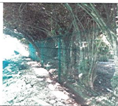
INSTALACIÓN DE CERRAMIENTO PERIMETRAL
