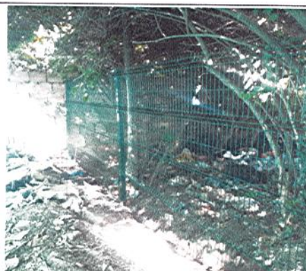
INSTALACIÓN DE CERRAMIENTO PERIMETRAL
