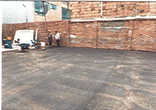
ACABADO FINAL PARA CANCHA
