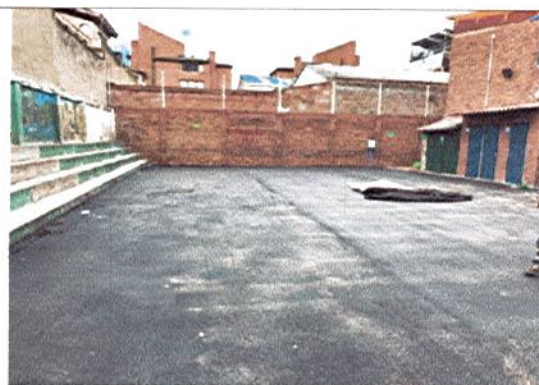
ACABADO FINAL PARA CANCHA
