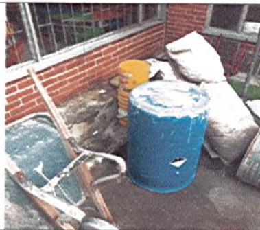
INGRESO DE MATERIAL DE OBRA
