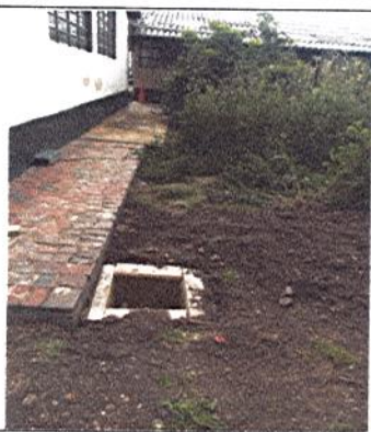
FUNDICION DE CAJA DE PASO Y RELLENO DE ACOMETIDA
