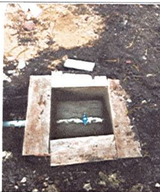
FUNDICION DE CAJA DE PASO
