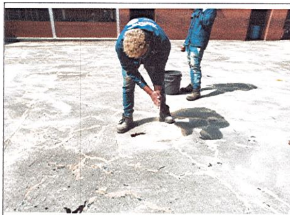
SELLAMIENTO DE FISURAS
