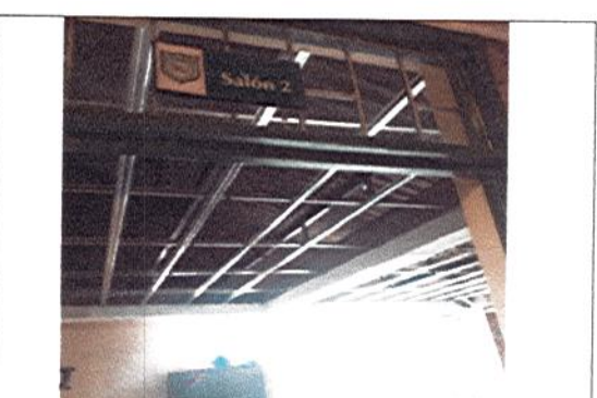
INSTALACION DE ESTRUCTURA PARA CIELO RASO EN SUPERBOARD EN SALONES Y RED ELECTRICA
