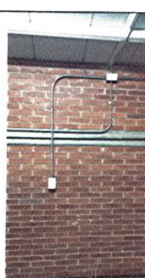
INSTALACIÓN DE TUBERIA EMT Y SALIDAS ELECTRICAS
