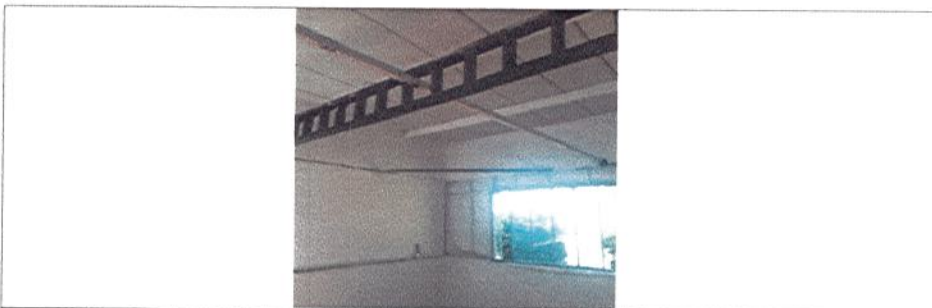
REFUERZO DE ESTRUCTURA PORTANTE DE CUBIERTA Y PINTURA DE SUPERBOARD AL INTERIOR DEL AREA
