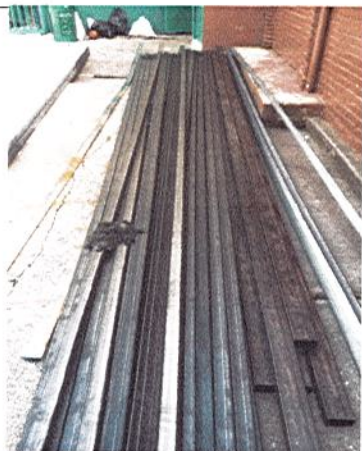
INGRESO DE PERFILERIA DE SOPORTE PARA INSTALACIÓN DE CUBIERTA NUEVA
