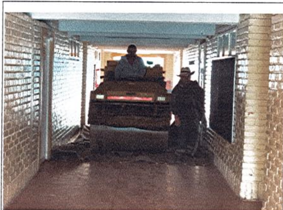
INGRESO DE MAQUINARIA PARA COMPACTACIÓN DE SUELO
