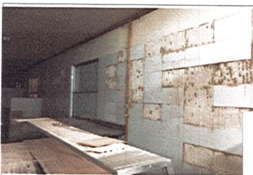
DESMONTE DE ENCHAPES FISURADOS DE MURO
