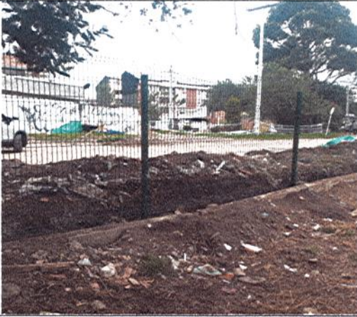
INSTALACIÓN DE CERRAMIENTO
