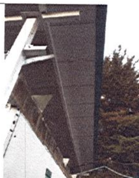
MONTAJE DE CUBIERTA TIPO SANDWICH Y DESMONTE DE CUBIERTA CANALETA 90 EXISTENTE
