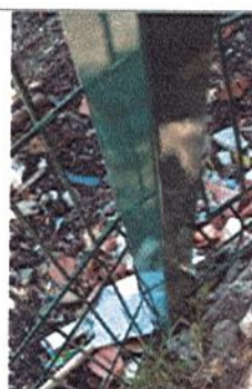
EVIDENCIA DE CERRAMIENTO VIOLENTADO
