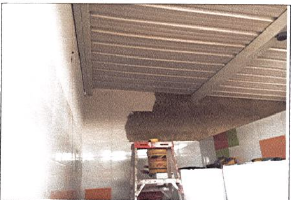
ESTUCO DE MURO SUPERIOR
