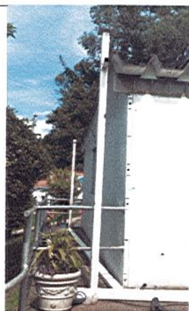
INICIA MONTAJE DE CUBIERTA (PERFILERÍA)
