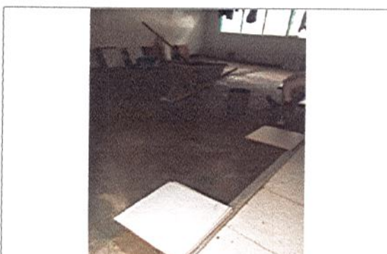
INSTALACIÓN DE ENCHAPE PISO
