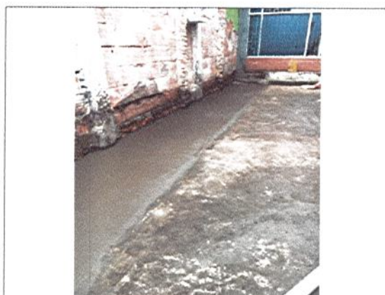
FUNDICIÓN DE PLACA Y NIVELACIÓN DE PISO
