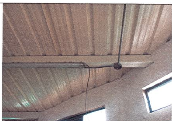
INSTALACIÓN DE LUMINARIOS Y RED ELECTRICA EN EMT
