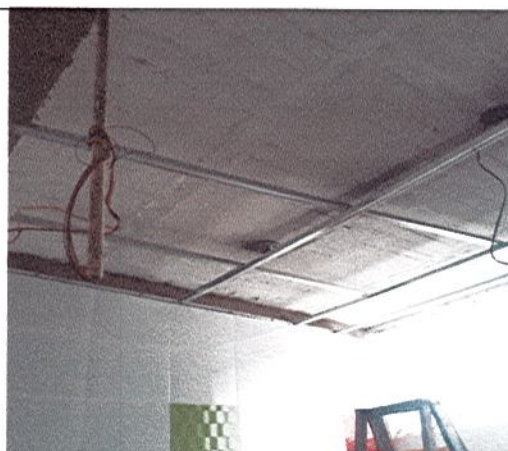
INSTALACIÓN DE ESTRUCTURA DE CIELO RASO EN SUPERBOARD
