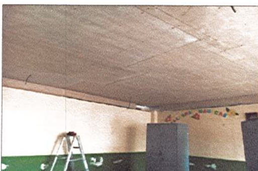
INSTALACIÓN DE LAMINAS DE SUPERBOARD EN LOS 3 SALONES
