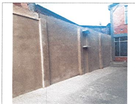
PAÑETE DE MUROS LISO
