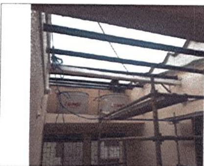
DESMONTE DE CUBIERTA EXISTENTE DE ASBESTO CEMENTO EN ZONA DE ESCALERAS
