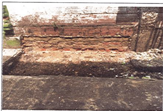
LIMPIEZA DE ZANJA PARA PLACA NUEVA
