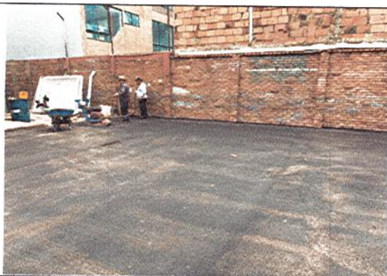
ACABADO FINAL PARA CANCHA
