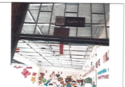
INSTALACION DE ESTRUCTURA PARA CIELO RASO EN SUPERBOARD EN SALONES Y RED ELECTRICA
