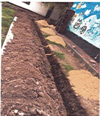
EXCAVACIÓN DE ACOMETIDA
