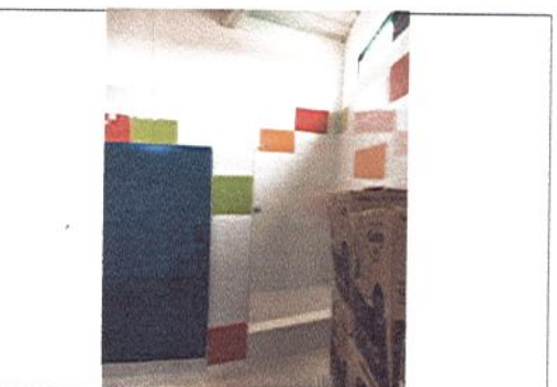
INSTALACIÓN DE PUERTAS METALICAS PARA BAÑOS
