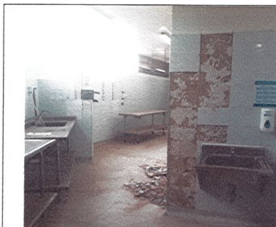
DESMONTE DE ENCHAPES FISURADOS DE MURO
