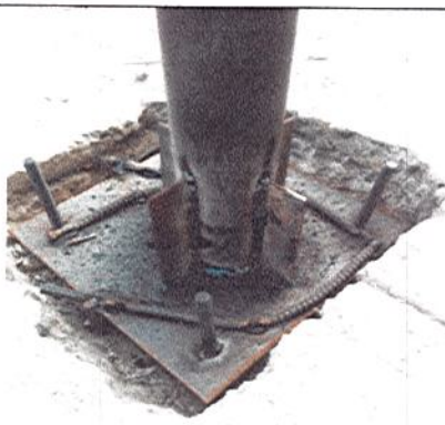
INSTALACIÓN DE PLATINAS PARA MONTAJE DE POSTES EN ZONA DE BAÑOS
