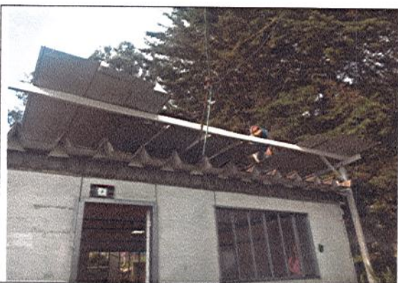
INICIA MONTAJE DE CUBIERTA (TEJA TIPO SANDWICH)
