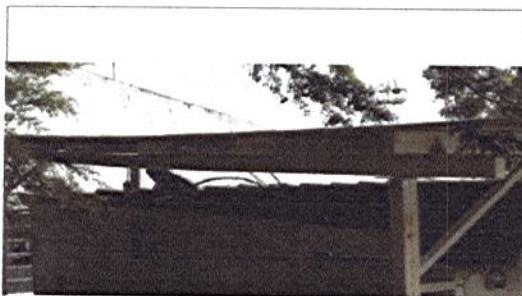
MONTAJE DE CUBIERTA TIPO SANDWICH
