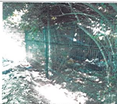
INSTALACIÓN DE CERRAMIENTO PERIMETRAL
