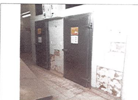
DESMONTE DE ENCHAPES FISURADOS DE MURO
