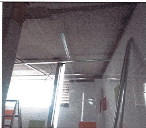
INSTALACIÓN DE ESTRUCTURA DE CIELO RASO EN SUPERBOARD
