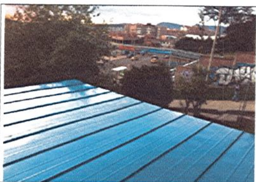
MONTAJE DE CUBIERTA TIPO SANDWICH
