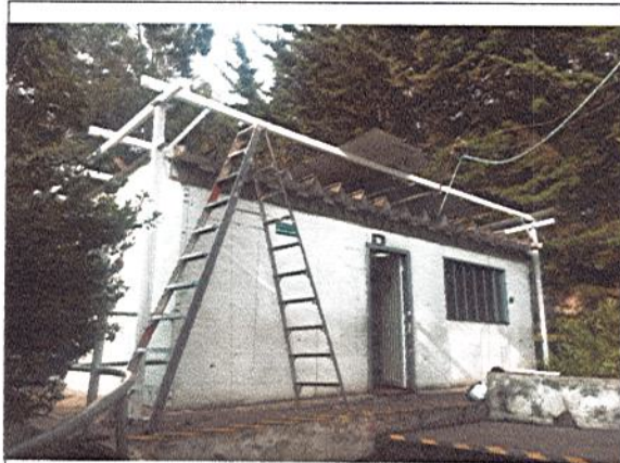
MONTAJE DE CUBIERTA TIPO SANDWICH
