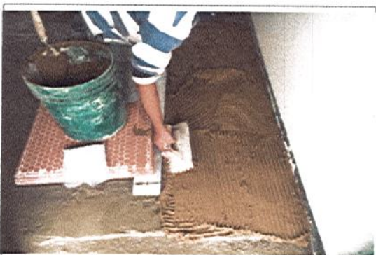
INSTALACIÓN DE ENCHAPE PISO
