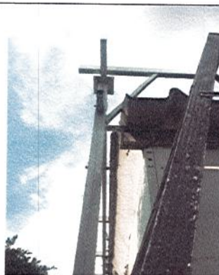
ANCLAJE DE PERFILES PARA CUBIERTA TIPO SANDWICH
