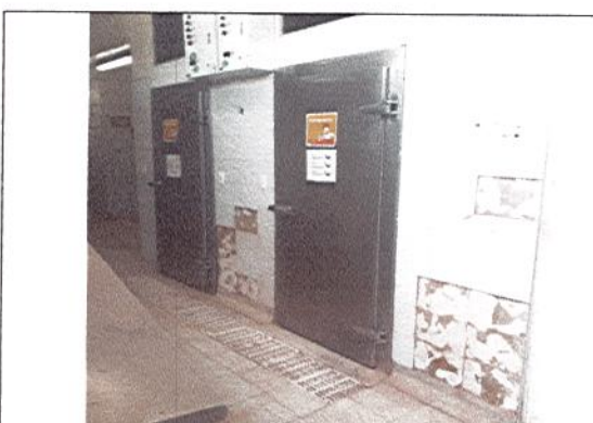
DESMONTE DE ENCHAPES FISURADOS DE MURO
