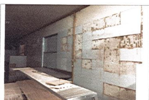
DEMOLICIÓN DE ENCHAPES FISURADOS EN MURO
