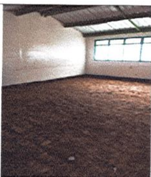
DESMONTE DE ADOQUIN EN SALONES
