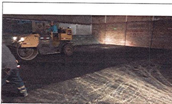
COMPACTACIÓN DE SUELO
