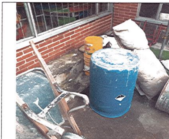
INGRESO DE MATERIAL DE OBRA
