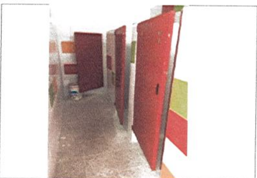
INSTALACIÓN DE PUERTAS METALICAS PARA BAÑOS
