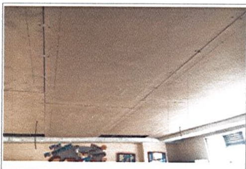
INSTALACIÓN DE LAMINAS DE SUPERBOARD EN LOS 3 SALONES
