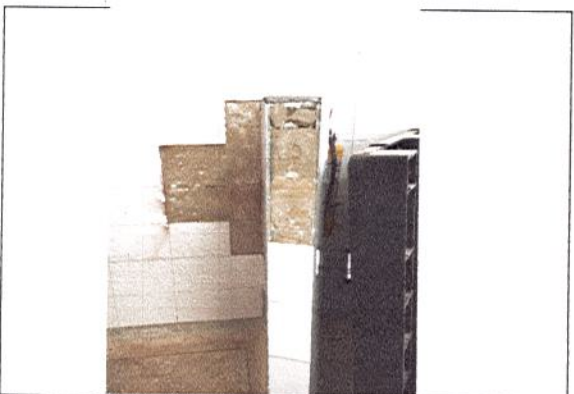
DEMOLICIÓN DE ENCHAPES FISURADOS EN MURO
