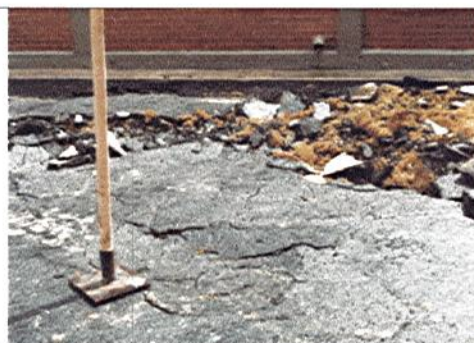
EVIDENCIA DE LEVANTAMIENTO DEL PAVIMENTO EXISTENTE
