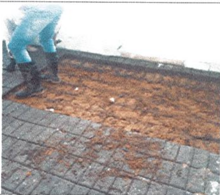
DESMONTE DE ADOQUIN EN SALONES
