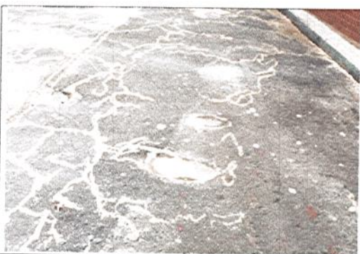
SELLAMIENTO DE FISURAS
