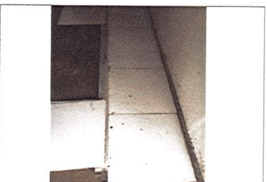
INSTALACIÓN DE ENCHAPE PISO
