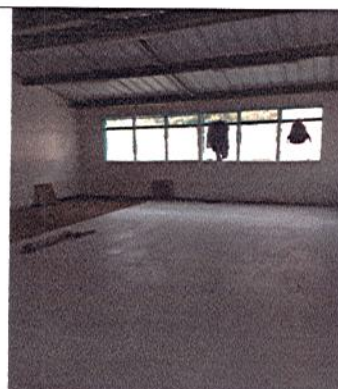
INSTALACIÓN DE ENCHAPE PISO
