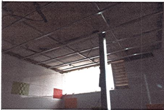
MONTAJE FINAL DE ESTRUCTURA PARA MONTAJE DE CIELO RASO EN SUPERBOARD EN BAÑOS
