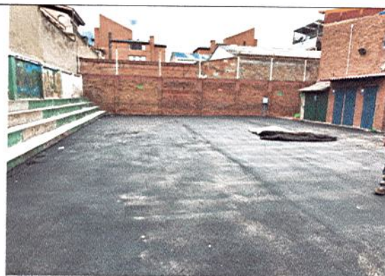
ACABADO FINAL PARA CANCHA
