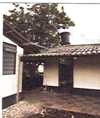
CONEXIÓN DE TUBERIA A TANQUE ELEVADO PARA BAÑOS
