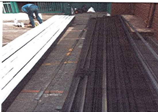
INGRESO DE PERFILERIA DE SOPORTE PARA INSTALACIÓN DE CUBIERTA NUEVA
