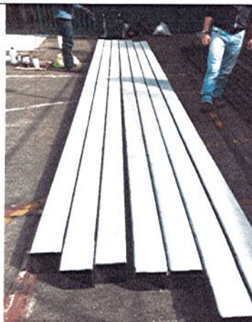
PINTURA EN SITIO DE PERFILERIA DE SOPORTE PARA INSTALACIÓN DE CUBIERTA NUEVA
