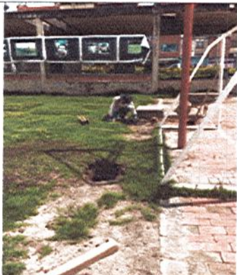
EXCAVACIÓN EN ZONA VERDE PARA INSTALACIÓN DE POSTES DE MALLA
