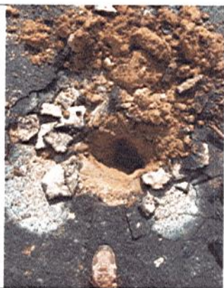
APIQUE A 0.40 CM REVISIÓN DEL SUELO
