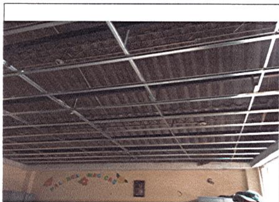
INSTALACION DE ESTRUCTURA PARA CIELO RASO EN SUPERBOARD EN SALONES
