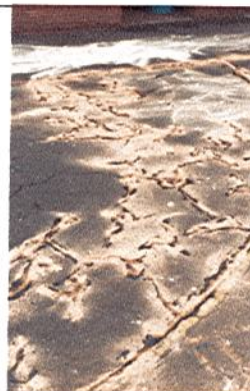
SELLAMIENTO DE FISURAS
