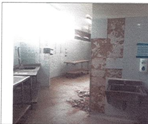
DESMONTE DE ENCHAPES FISURADOS DE MURO
