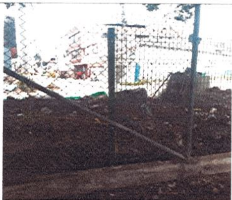
INSTALACIÓN DE CERRAMIENTO
