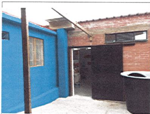
APLICACIÓN DE PINTURA DE MURO EXTERIOR
