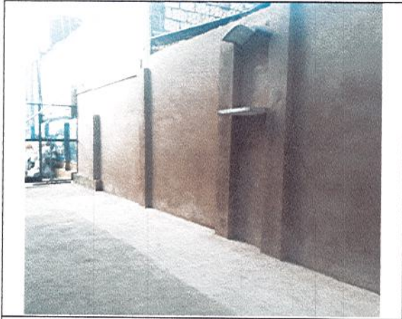
PAÑETE DE MUROS LISO
