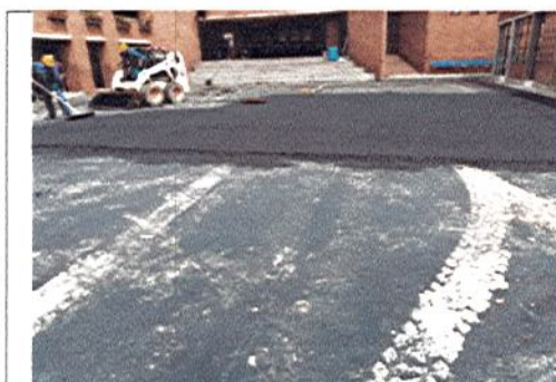
EXTENDIDA DE PAVIMENTO EN ZONA 4
