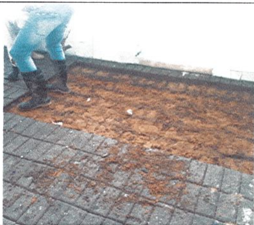
DESMONTE DE ADOQUIN EN SALONES
