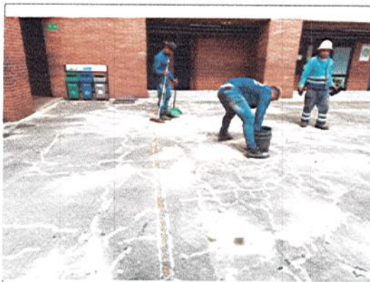
SELLAMIENTO DE FISURAS
