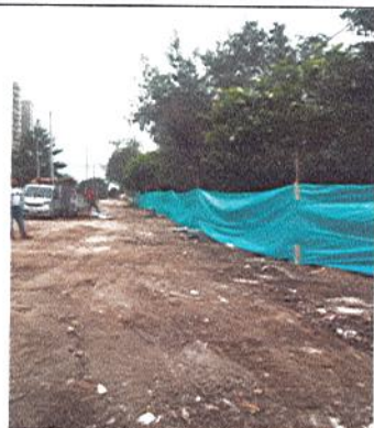
CERRAMIENTO EN LONA VERDE EXTERIOR
