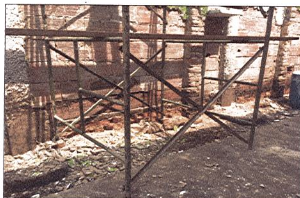
DEMOLICIÓN DE ENCHAPE MURO
