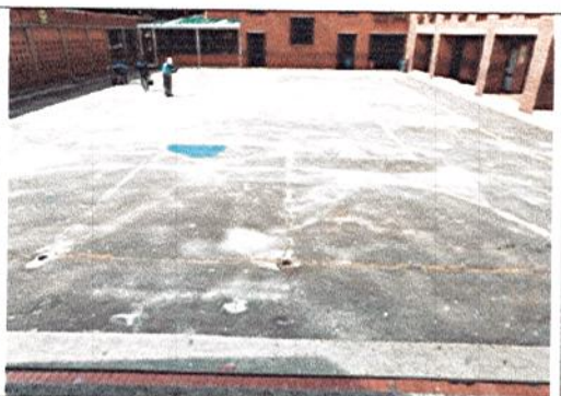
SELLAMIENTO DE FISURAS
