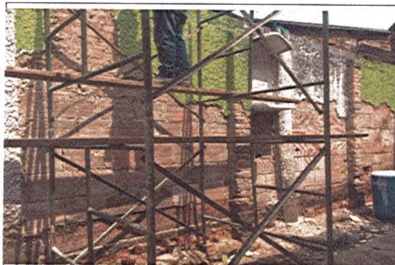
DEMOLICIÓN DE ENCHAPE MURO
