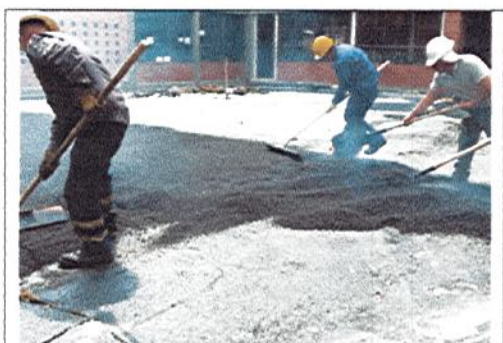
EXTENDIDA DE PAVIMENTO EN ZONA 4
