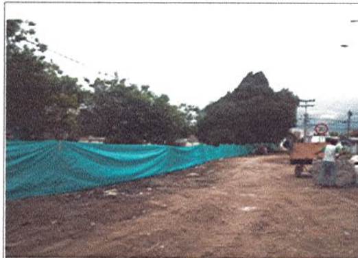
CERRAMIENTO EN LONA VERDE EXTERIOR
