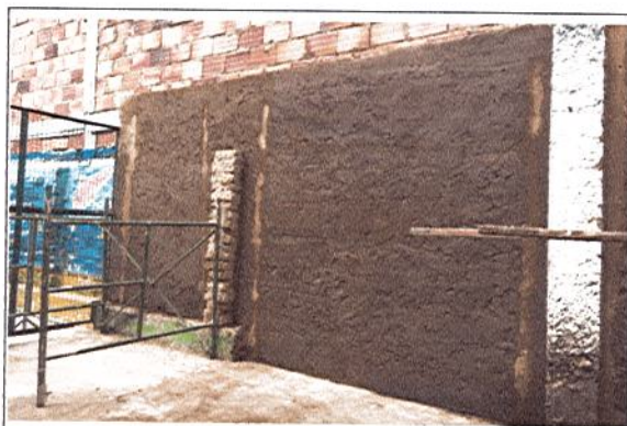
REPOSICIÓN DE PAÑETE EN MUROS
