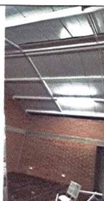
INSTALACIÓN DE LUMINARIAS EN ZONA DE TARIMA
