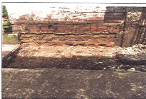
LIMPIEZA DE ZANJA PARA PLACA NUEVA
