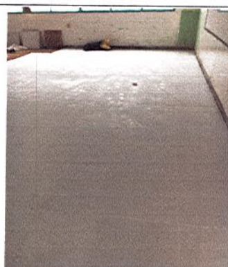
INSTALACIÓN DE ENCHAPE PISO
