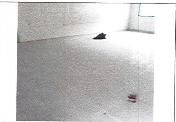
FINALIZA INSTALACIÓN DE ENCHAPE DE PISO EN SALON 3
