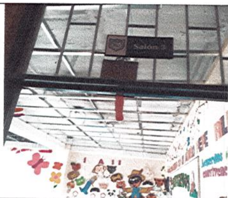
INSTALACION DE ESTRUCTURA PARA CIELO RASO EN SUPERBOARD EN SALONES Y RED ELECTRICA
