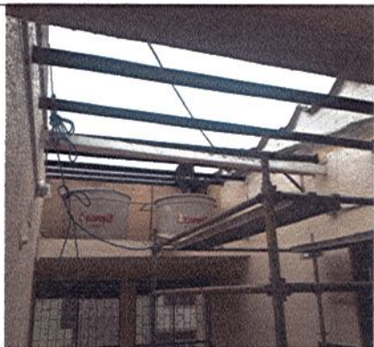
DESMONTE DE CUBIERTA EXISTENTE DE ASBESTO CEMENTO EN ZONA DE ESCALERAS
