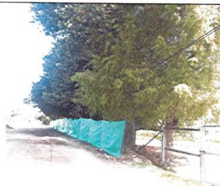
CERRAMIENTO Y LIMPIEZA DE ÁREA DE INTERVENCIÓN
