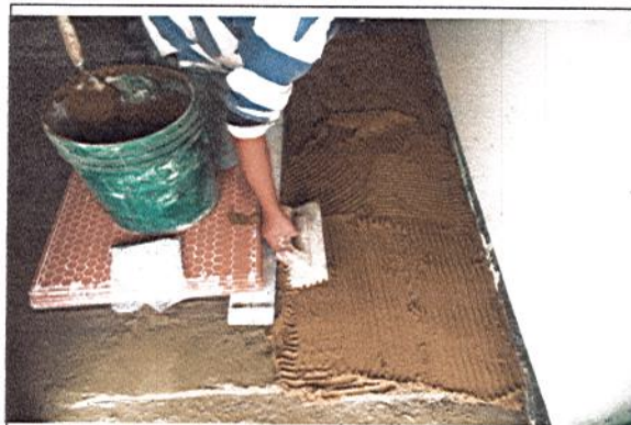
INSTALACIÓN DE ENCHAPE PISO
