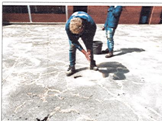
SELLAMIENTO DE FISURAS
