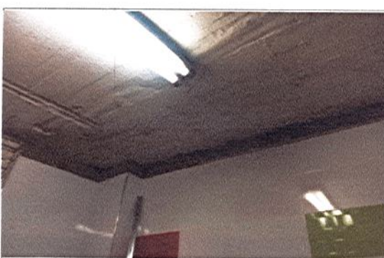
INSTALACION DE ESTRUCTURA PARA CIELO RASO EN SUPERBOARD EN BAÑO
