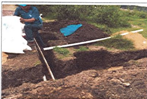
INSTALACIÓN DE RED DE SUMINISTRO PARA CONEXIÓN DE TANQUES
