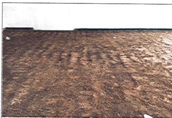
DESMONTE DE ADOQUIN EN SALONES
