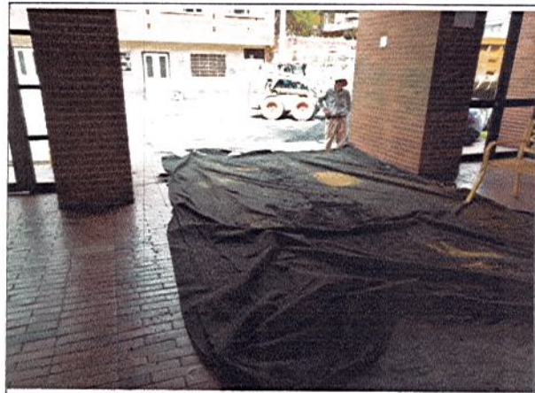
ADECUACIÓN Y PROTECCIÓN DE ÁREA DE INGRESO DE MAQUINARIA
