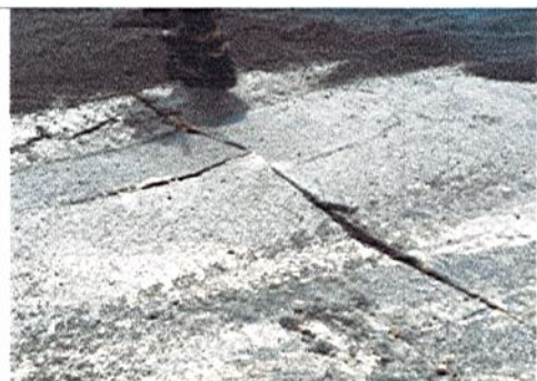
EVIDENCIA DE LEVANTAMIENTO DEL PAVIMENTO EXISTENTE
