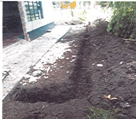
INICIO DE EXCAVACIÓN PARA ACOMETIDA
