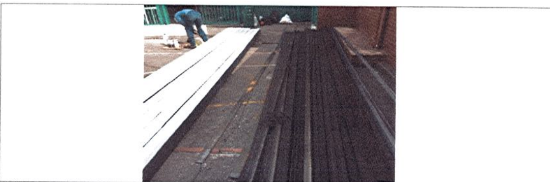
INGRESO DE PERFILERIA DE SOPORTE PARA INSTALACIÓN DE CUBIERTA NUEVA
