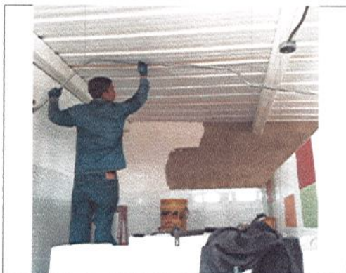
INSTALACIÓN DE TUBERIA EMT ELECTRICA
