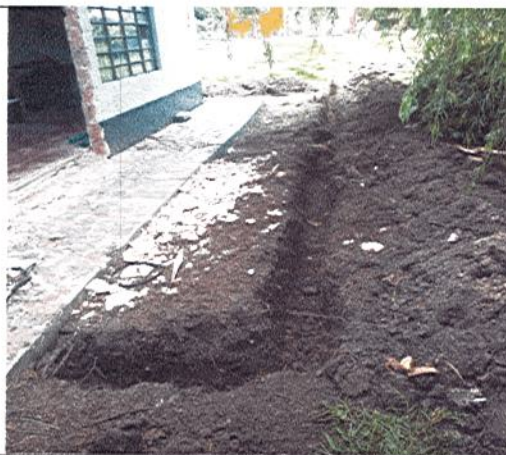
INICIO DE EXCAVACIÓN PARA ACOMETIDA
