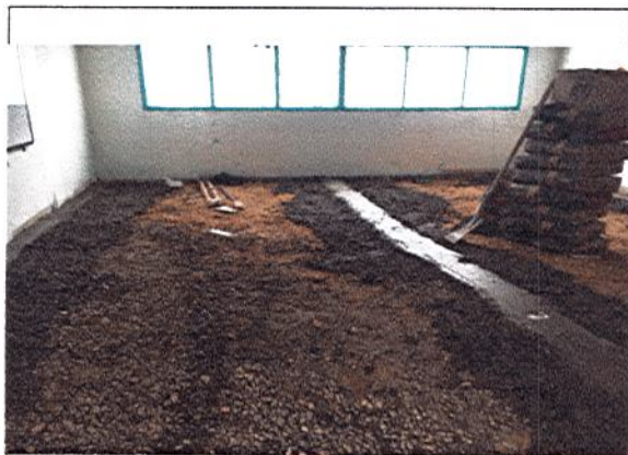
RELLENO,COMPACTACIÓN Y ALISTADO DE PISO
