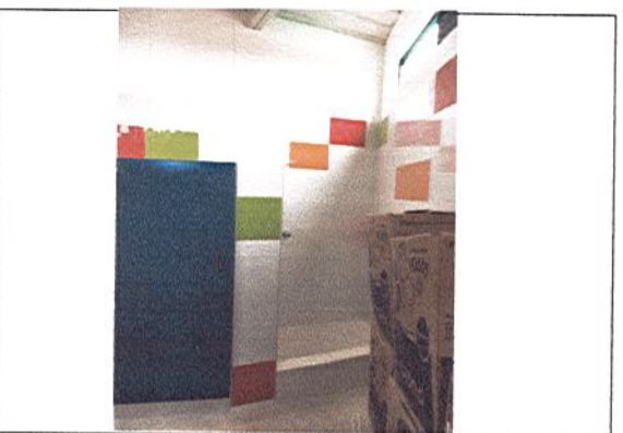
INSTALACIÓN DE PUERTAS METÁLICAS PARA BAÑOS
