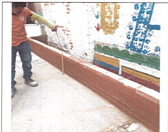
CONSTRUCCIÓN DE JARDINERA NUEVA
