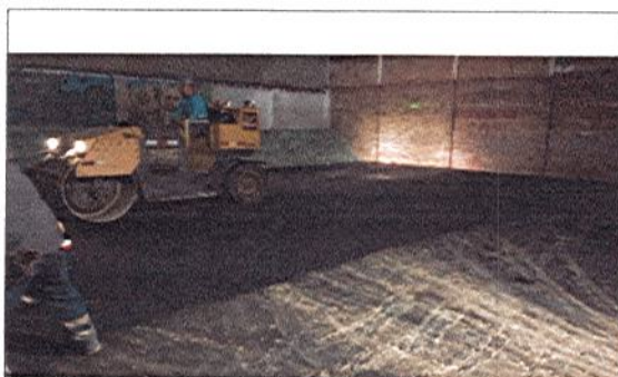
COMPACTACIÓN DE SUELO
