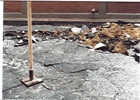
EVIDENCIA DE LEVANTAMIENTO DEL PAVIMENTO EXISTENTE
