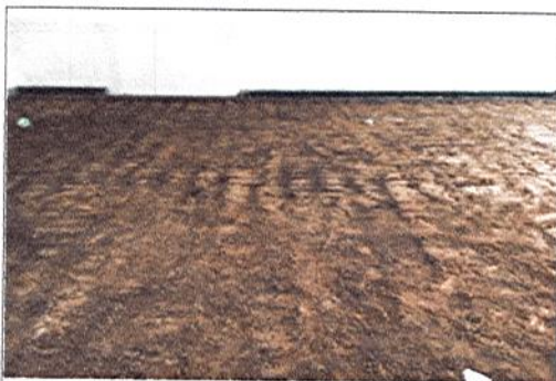
DESMONTE DE ADOQUIN EN SALONES
