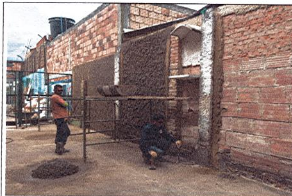
RETIRO DE PAÑETE EXISTENTE
