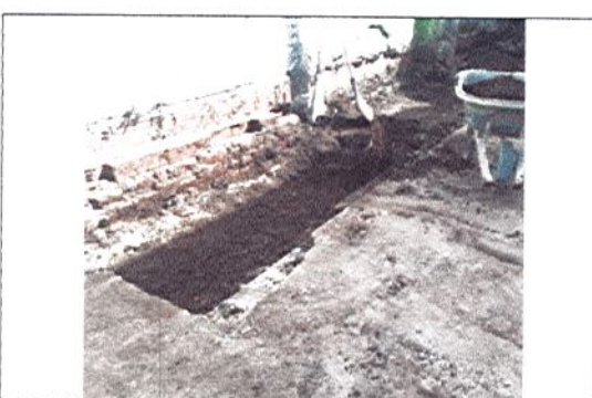
RELLENO DE ZANJA PARA PLACA NUEVA
