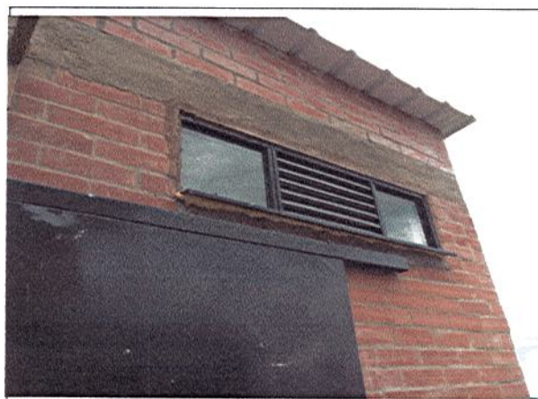
INSTALACIÓN DE VIDRIOS PARA VENTANERÍA
