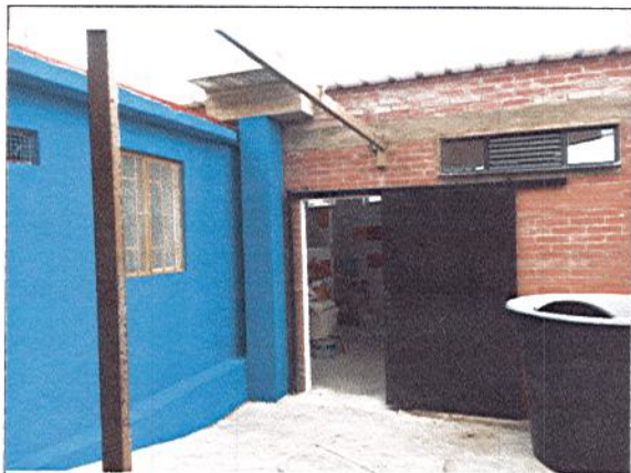
APLICACIÓN DE PINTURA DE MURO EXTERIOR
