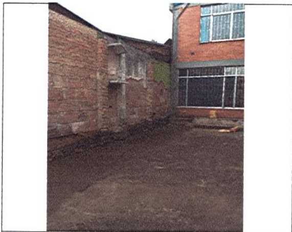
FUNDICIÓN DE PLACA Y NIVELACIÓN DE PISO
