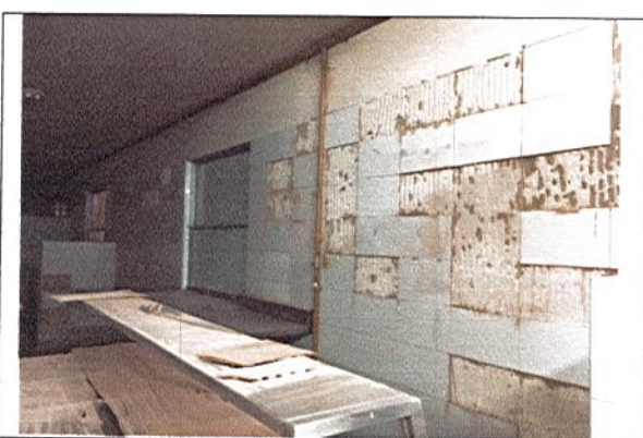
DEMOLICIÓN DE ENCHAPES FISURADOS EN MURO
