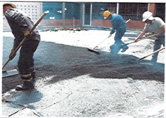
EXTENDIDA DE PAVIMENTO EN ZONA 4
