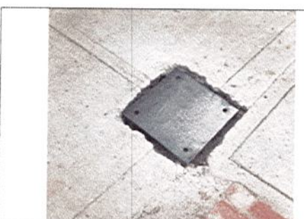
INSTALACIÓN DE PLATINAS PARA MONTAJE DE POSTES
