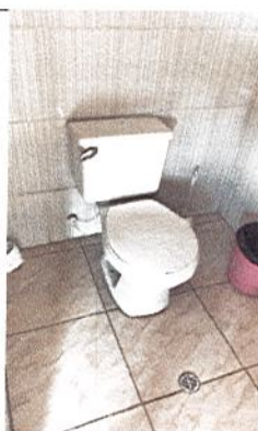
REPOSICIÓN DE TAPA DE SANITARIO
