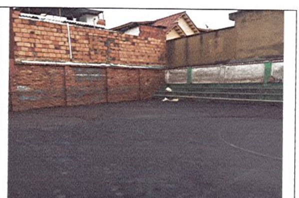
APLICACIÓN DE SLURRING PARA SELLAMIENTO DE FISURAS
