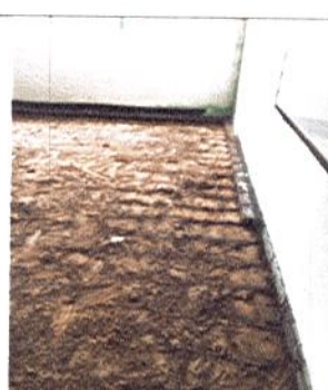
DESMONTE DE ADOQUIN EN SALONES
