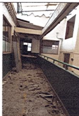
DESMONTE DE CUBIERTA EXISTENTE DE ASBESTO CEMENTO EN ZONA DE CORREDOR
