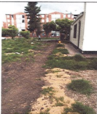
RELLENO DE ZANJA DE ACOMETIDA
