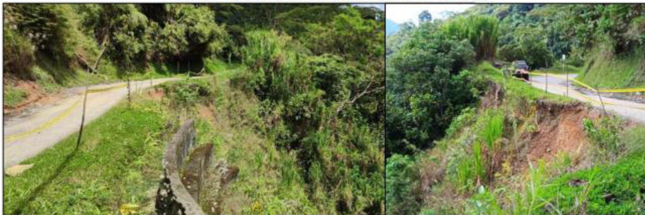
Fotografía 1. Estado actual del sitio de estudio, deslizamiento.
